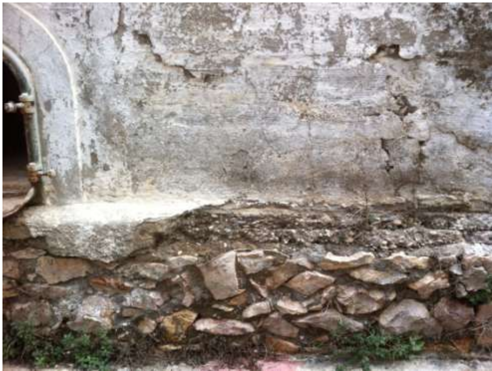
Εικόνα 3.1 Θεμελίωση δεξαμενής Ω/Σ επί λιθοδομής.
