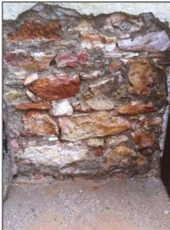
Εικόνα 3.4 Αποκάλυψη τρίστρωτης τοιχοποιίας από μη λαξευμένους λίθους ασβεστολιθικής προέλευσης.
