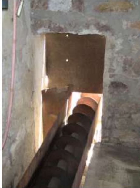
Εικόνα 2.8 Διέλευση κοχλίας από τη λιθοδομή χωρίς την ύπαρξη πρεκτιού στο άνοιγμα.
