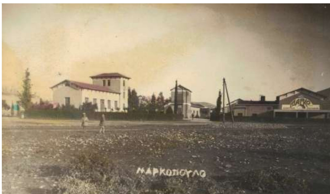
Εικόνα 1.1 Οι εγκαταστάσεις του Α.Σ. ΜΑΡΚΟ. Στα αριστερά της Εικόνας φαίνεται το κτήριο που στέγαζε τα ηλεκτροπαραγωγά ζεύγη, στο κέντρο το παλιό ζυγιστήριο και στα δεξιά το συγκρότημα πατητηριού (Φωτό, Ιστορικό Αρχείο Α.Σ. "ΜΑΡΚΟ").
