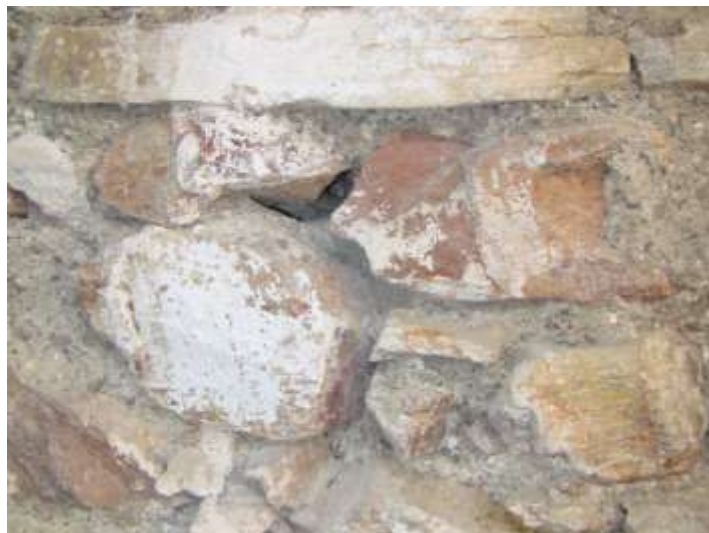
Εικόνα 2.5 Αποκάλυψη λιθοδομής στον τοίχο του πηγαδιού, από φυσικούς μη λαξευμένους λίθους.
