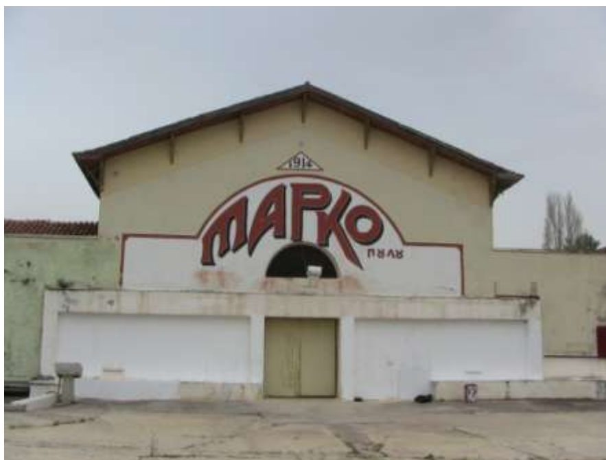
Εικόνα 2.1 Δυτική όψη. Κύρια είσοδος στον χώρο των σταφυλοποιεστηρίων. Το πλαίσιο πάνω από την κύρια είσοδο αποτελεί κομμάτι της πλαίσιακής κατασκευής Ω/Σ που στέγαζε τις μεταλλικές σταφυλοδόχους που έχουν πλέον αφαιρεθεί.
