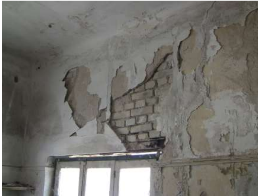
Εικόνα 2.6 Έντονες αποκολλήσεις του επιχρίσματος στο παλιό χημείο. Είναι εμφανής η φέρουσα μπατική οπτοπλινθοδομή όπως και το πρέκι του παραθύρου από χαλύβδινη δοκό τύπου IPE 80.
