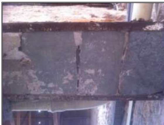
Εικόνα 3.9 Ανώφλι ανοίγματος που συνδέει το παλιό μηχανοστάσιο με τον χώρο των σταφυλοπιεστηρίων.
