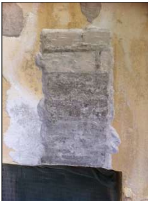
Εικόνα 3.10 Πρέκι πάνω από το παράθυρο στον χώρο του πατητηριού. Στην αποκάλυψη του πρεκιού φαίνεται και ο τύπος των οπτοπλινθών από τους οποίους είναι κατασκευασμένο το τοίχωμα.
