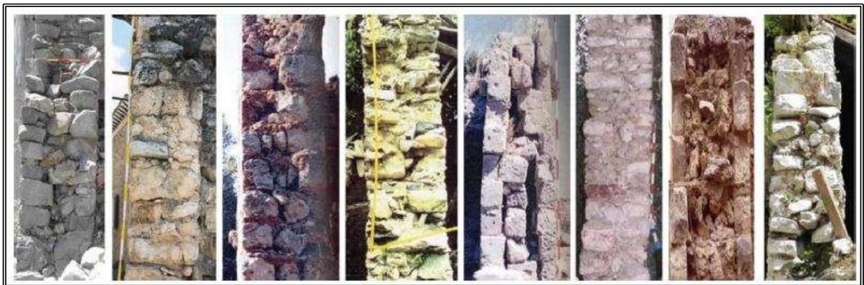
Εικόνα 1-5 Τομές δίστρων και τρίστρων τοιχοποιιών από φυσικούς λίθους (Binda et al, 2003) [6].
