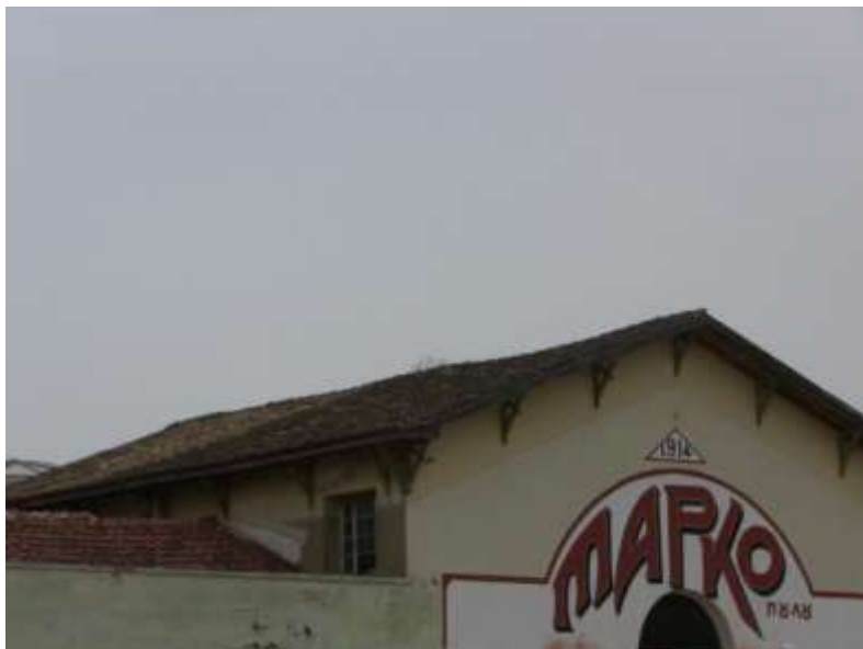
Εικόνα 2.10 Βύθιση της δόριχτης στέγης του πατητηριού.
