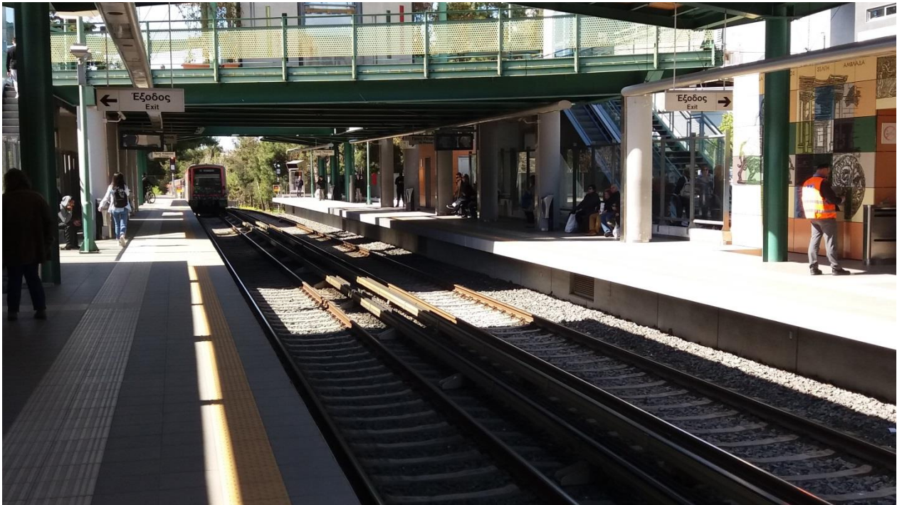
Εικόνα 52: Σταθμός ΗΣΑΠ – ΝΕΑ ΙΩΝΙΑ
