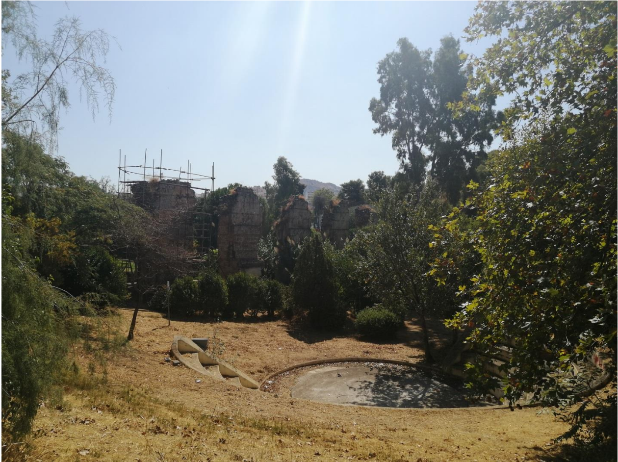
Εικόνα 7: Το Αδριάνειο Υδραγωγείο, μεταξύ των οικισμών της Ελευθερούπολης και της Νεάπολης
