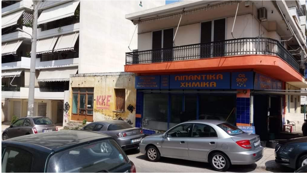
Εικόνα 12: Επί της οδού Παλαιολόγου στη διασταύρωση με την οδό Ομήρου
