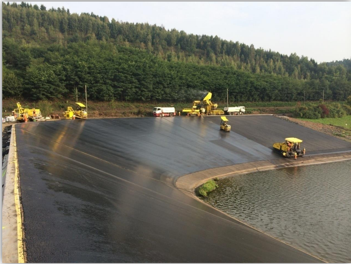
Εικόνα 12: Φράγμα με ειδική στεγάνωση (άσφαλτος)
