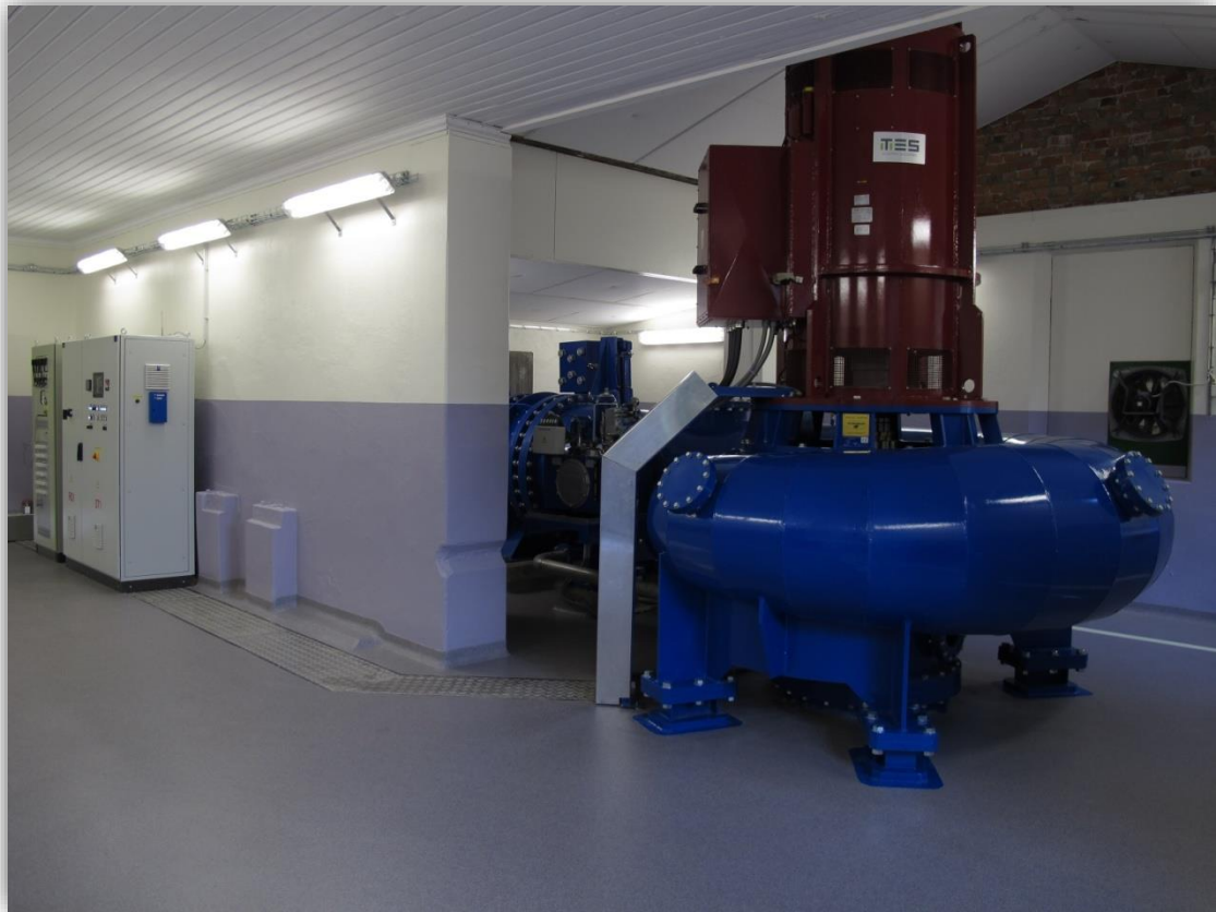
Εικόνα 26: Υδροστρόβιλος Francis με κατακόρυφη άτρακτο
