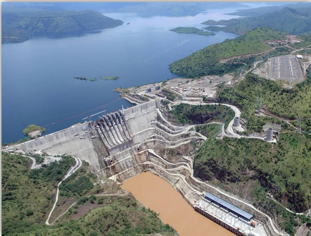
Εικόνα 5: Φράγμα από ισχύ κυλινδρούμενο σκυρόδεμα (RCC)
