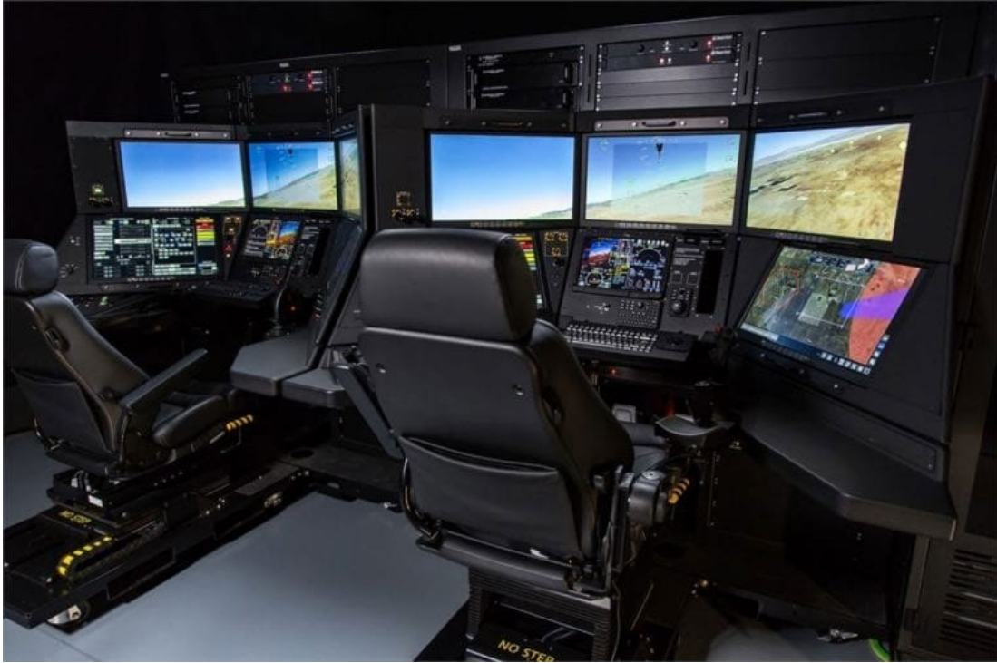
Εικόνα 51 : Εγκατεστημένος σταθμός εδάφους UAV (General Atomics Aeronautical Systems)
