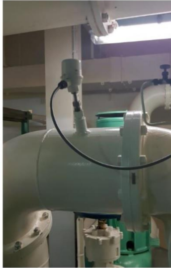
Εικόνα 4.8 – Αισθητήρας θερμοκρασίας γλυκού νερού [Πηγή: ABB]
