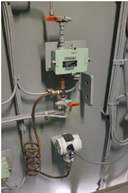
Εικόνα 4.9 – Αισθητήρας πίεσης γλυκού νερού [Πηγή: ABB]
