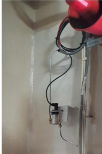
Εικόνα 4.4 Αισθητήρια Διαφορικής Πίεσης [Πηγή: ABB]
