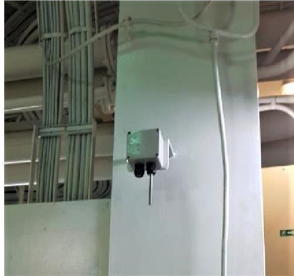
Εικόνα 4.3 Αισθητήριο Θερμοκρασίας [Πηγή: CTi Sensors, ABB]
