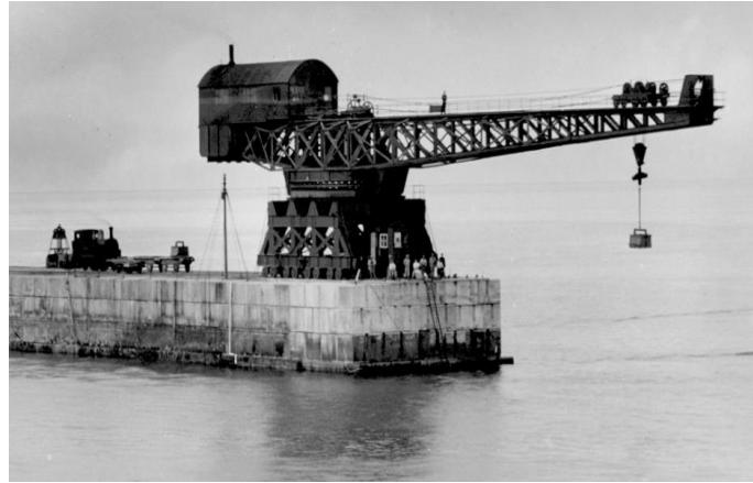
Εικόνα 3: Γερανογέφυρα τύπου προβλήτας στο παρελθόν.
