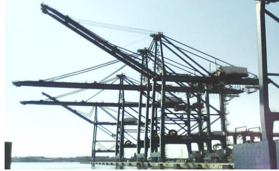
Εικόνα 10: Γερανογέφυρα τύπου προβλήτας
