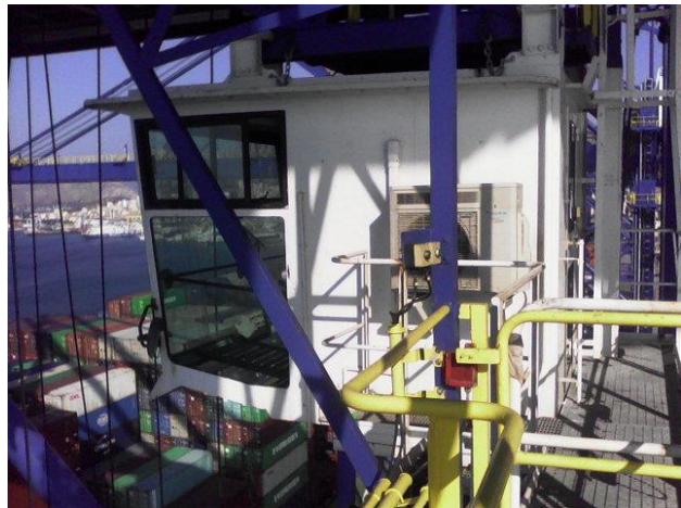
Εικόνα 17: καμπίνα χειρισμού γερανογέφυρας (από έξω)
