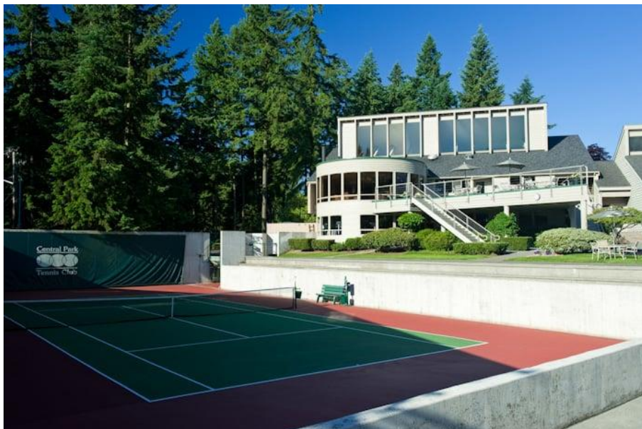
Εικόνα 13: Εξωτερικό γήπεδο τένις του Central Park Tennis Club
