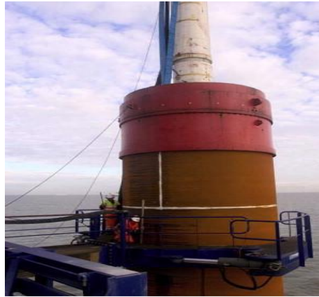
Εικόνα 3.4: Ειδικό σφυρί έμπηξης πασσάλου
