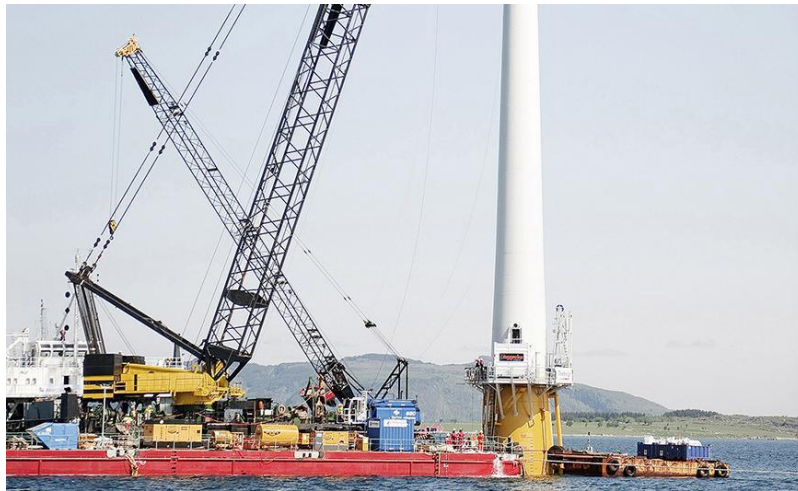
Εικόνα 5.19 : Συναρμολόγηση ανεμογεννητριών
