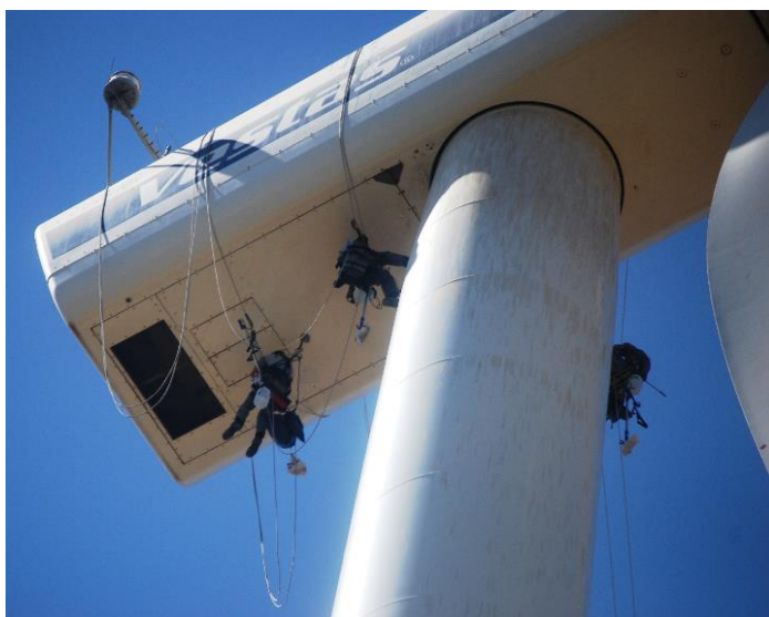
Εικόνα 5.22 : Συντήρηση ανεμογεννήτριας Vestas
