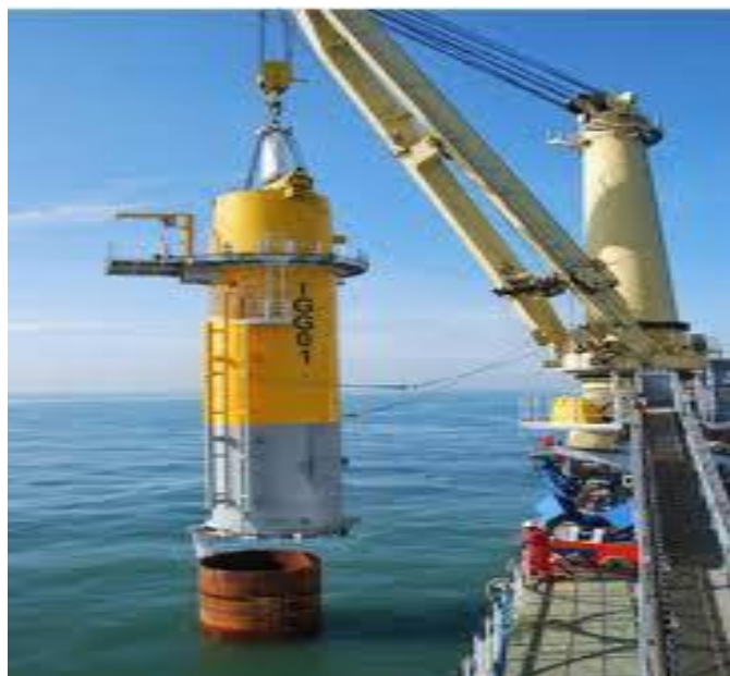
Εικόνα 5.15 : Θεμελίωση ανεμογεννήτριας
