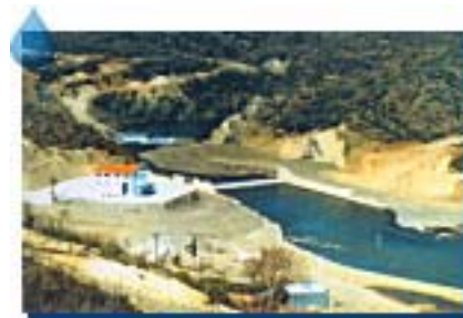
ΦΡΑΓΜΑ ΥΔΡΟΛΗΨΙΑΣ ΣΤΟΝ Π. ΑΛΙΑΚΜΟΝΑ
