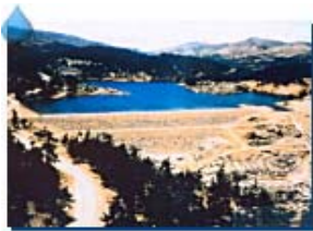
ΑΠΟΨΗ ΦΡΑΓΜΑΤΟΣ ΠΕΖΙ ΡΑΧΩΝ, Ν. ΙΚΑΡΙΑΣ
