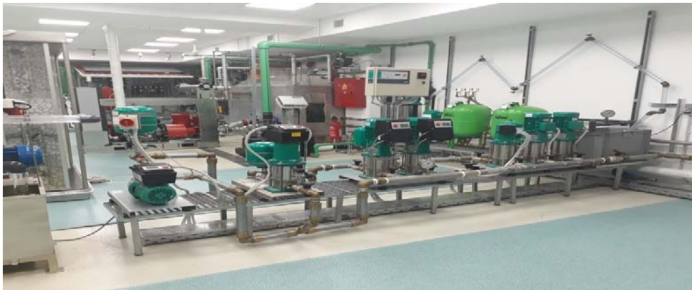
Εικόνα 7.1: Τμήμα πιεστικών συγκροτημάτων(Πηγή: Αίθουσα πρακτικής Wilo Hellas)
