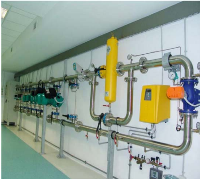
Εικόνα 7.8: Διαχωριστής & απαερωτής κυκλώματος(Πηγή: Αίθουσα πρακτικής Wilo Hellas)
