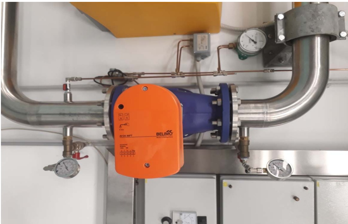
Εικόνα 7.12: Τριόδη Βάνα Belimo(Πηγή: Manual Belimo)
