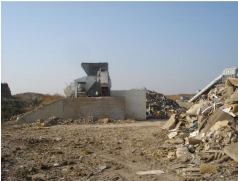
Εικόνα 3-4: Εξοπλισμός ανακύκλωσης ΑΕΚΚ (υδραυλικός θρυμματιστής) (πηγή: Ομάδα εργασίας ΤΕΕ, 2012)
