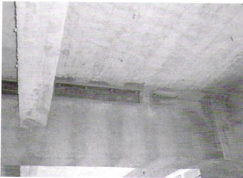
Αγκύρωση μανδύα σύνθετου υλικού για ενίσχυση πλακοδοκού.
