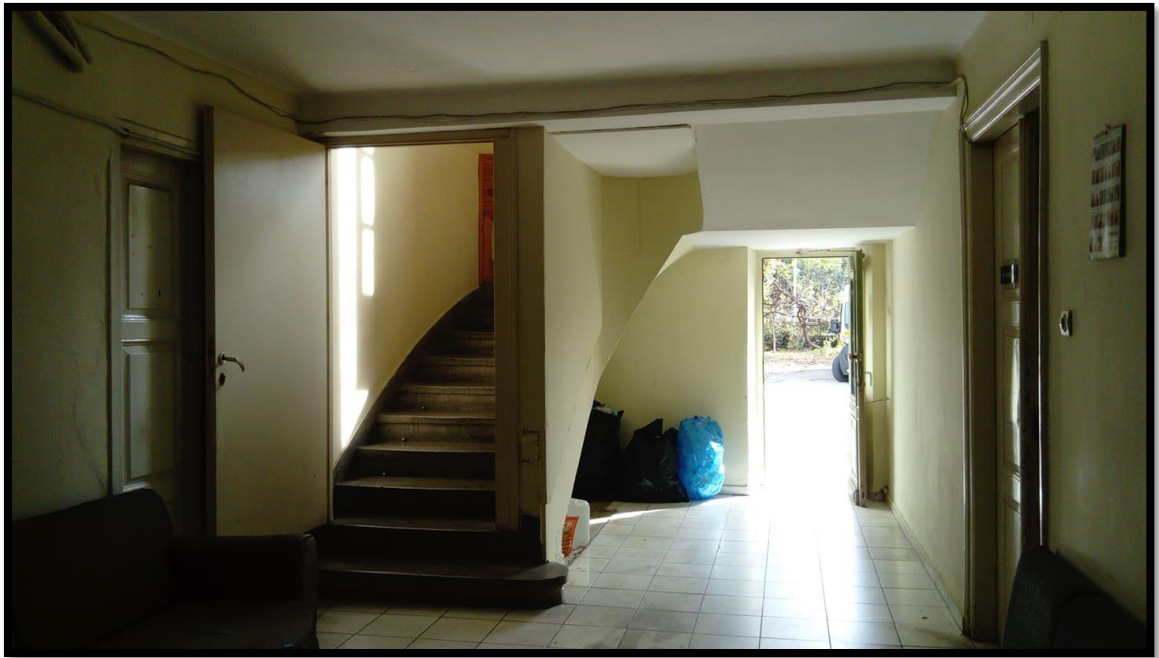
Εικόνα 3.6: Η εσωτερική κλίμακα που δίνει πρόσβαση από το ισόγειο στον όροφο.
