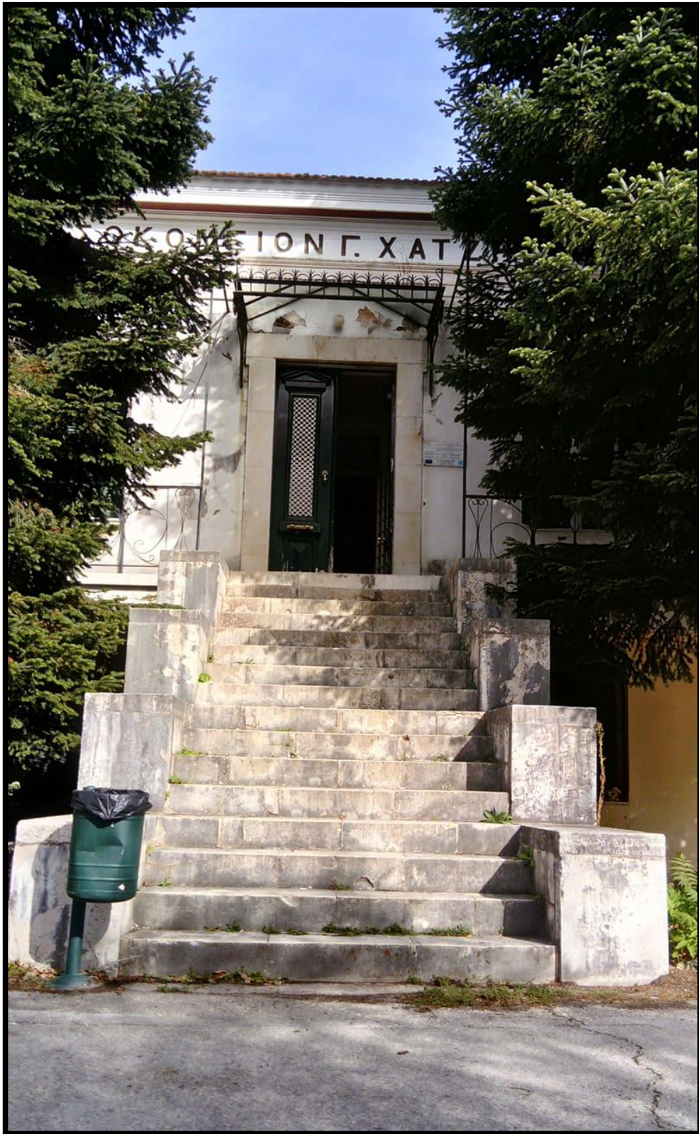
Εικόνα 3.5: Η κτιστή εξωτερική κλίμακα στη δυτική όψη του παλαιού νοσοκομείου «Γ. Χατζηκώστα».
