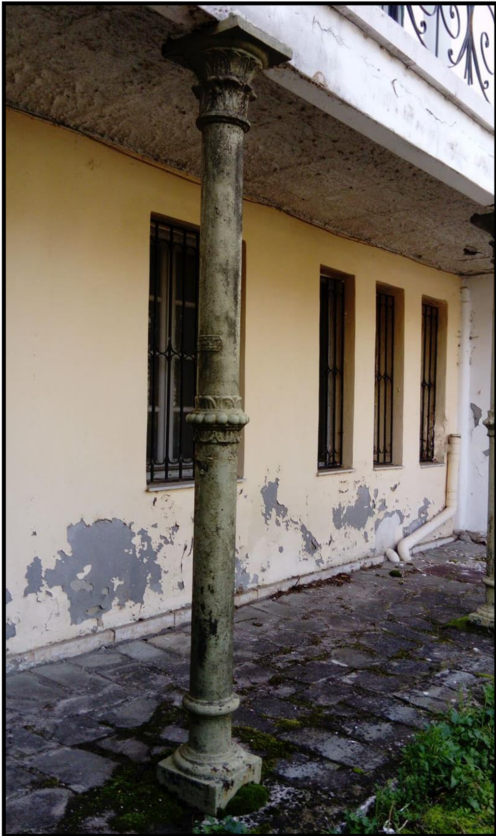
Εικόνα 3.18: Χαρακτηριστικό δείγμα περίτεχνου μεταλλικού υποστυλώματος του κτιρίου.
