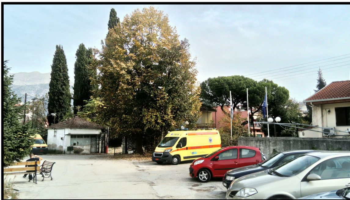
Εικόνα 3.19: Η διαμορφωμένη αυλή στα νότια του κτιρίου που χρησιμοποιείται ως χώρος στάθμευσης.
