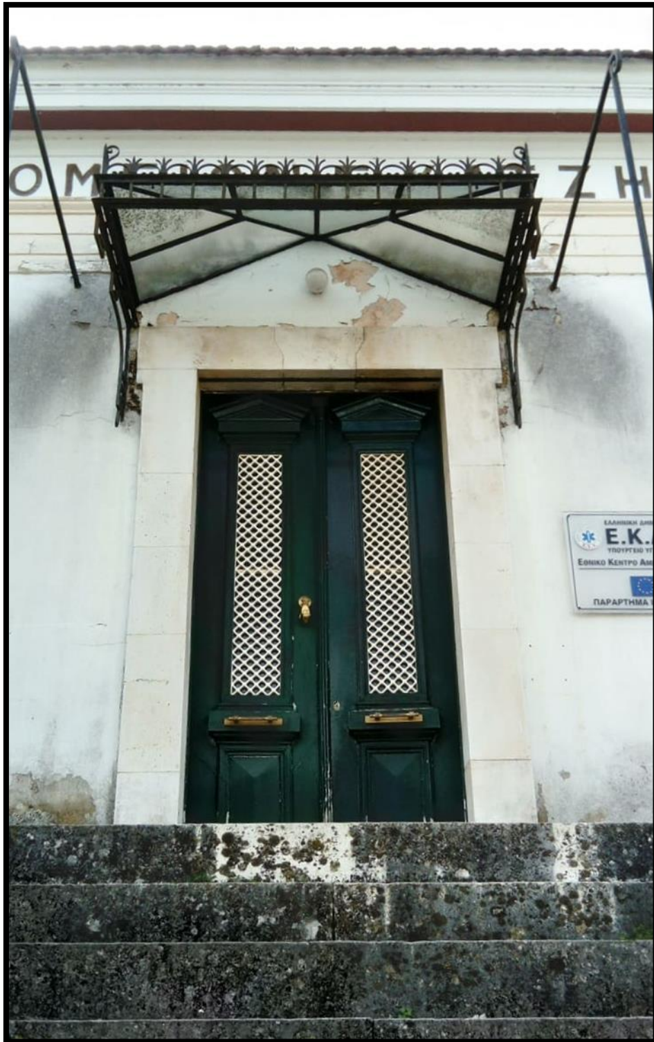
Εικόνα 3.13: Το περίτεχο μεταλλικό στέγαστρο της ανατολικής εισόδου του ορόφου.
