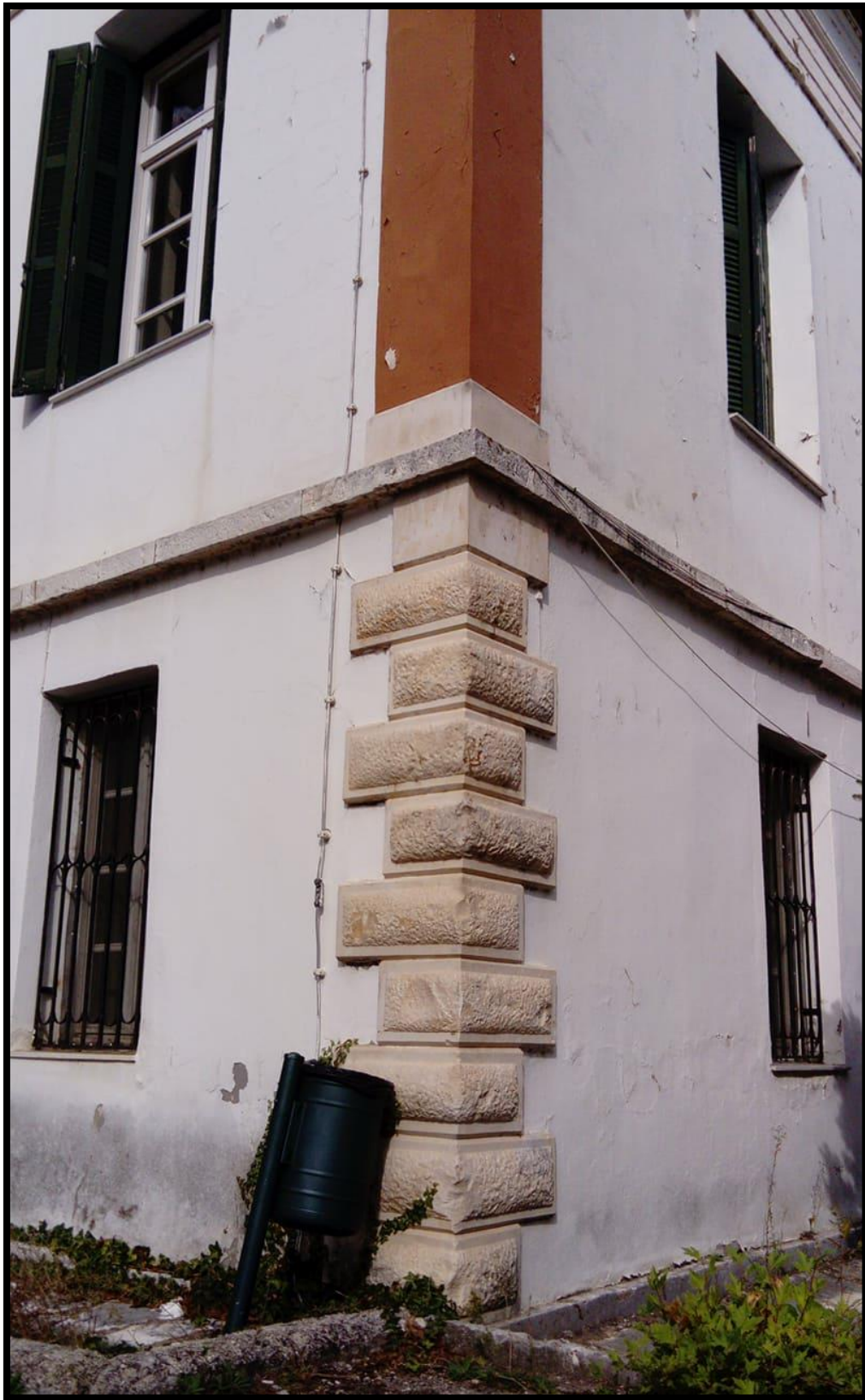
Εικόνα 3.9: Γωνιόλιθοι (αγκωνάρια) στη νοτιοδυτική γωνία του κτιρίου.
