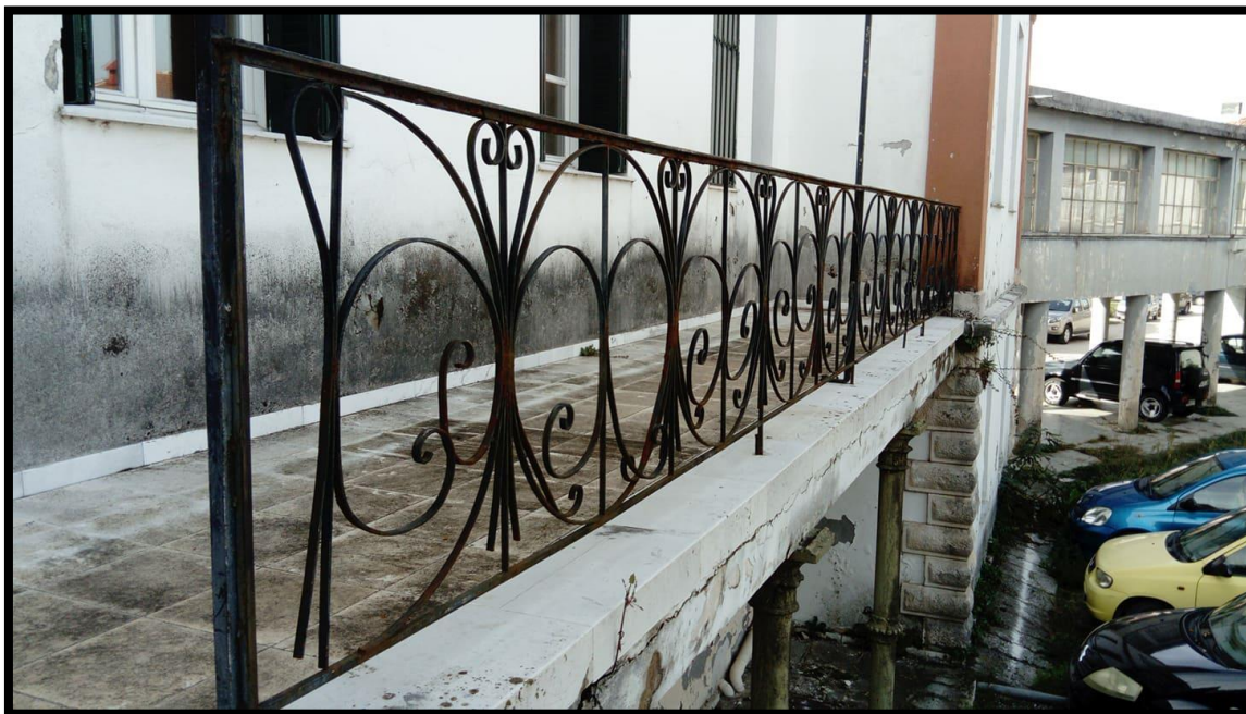
Εικόνα 3.12: Τα περίτεχνα μεταλλικά κιγκλιδώματα στον ανατολικό εξώστη του ορόφου.
