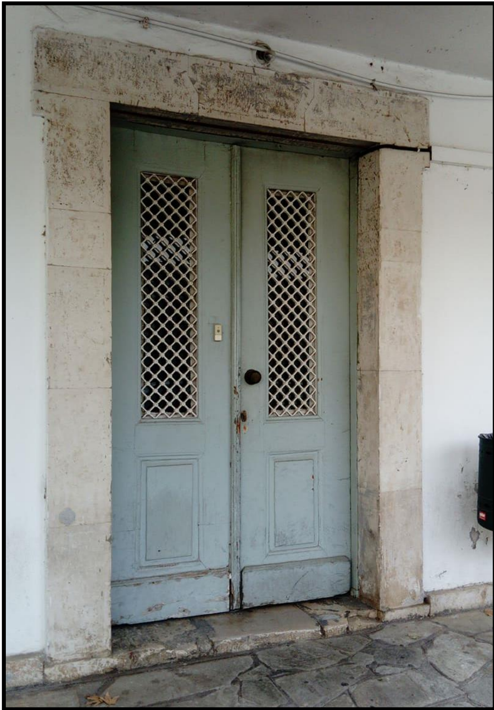
Εικόνα 3.16: Η βόρεια εξωτερική θύρα του κτιρίου.
