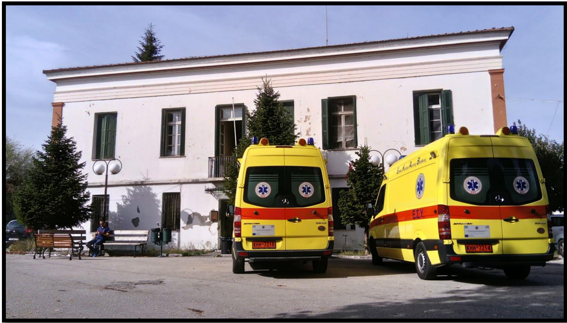
Εικόνα 3.2: Η νότια όψη του κτιρίου με τη σημερινή του χρήση ως έδρα της 7 ης Περιφέρειας του Εθνικού Κέντρου Άμεσης Βοήθειας (Ε.Κ.Α.Β.) – Παραρτήματος Ιωαννίνων.
