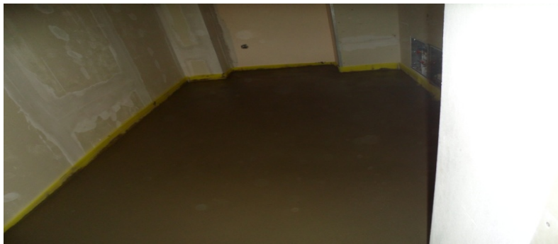
Εικόνα 15- Φωτογραφία από την ολοκλήρωση της ενδοδαπέδιας
