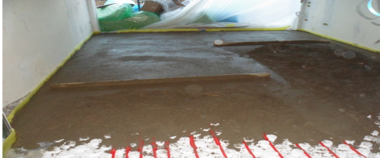
Εικόνα 14-Φωτογραφία από το στάδιο που τοποθετείται το θερμοπετόν
