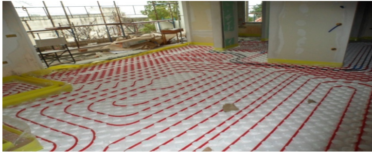
Εικόνα 13- Φωτογραφία ενδοδαπέδιας κατά την τοποθέτηση σωληνώσεων
