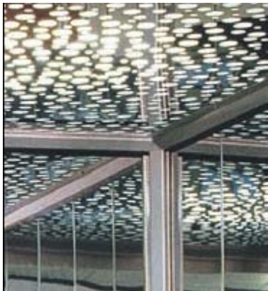
ειδικό στερέωμα, φωτισμός οροφής
