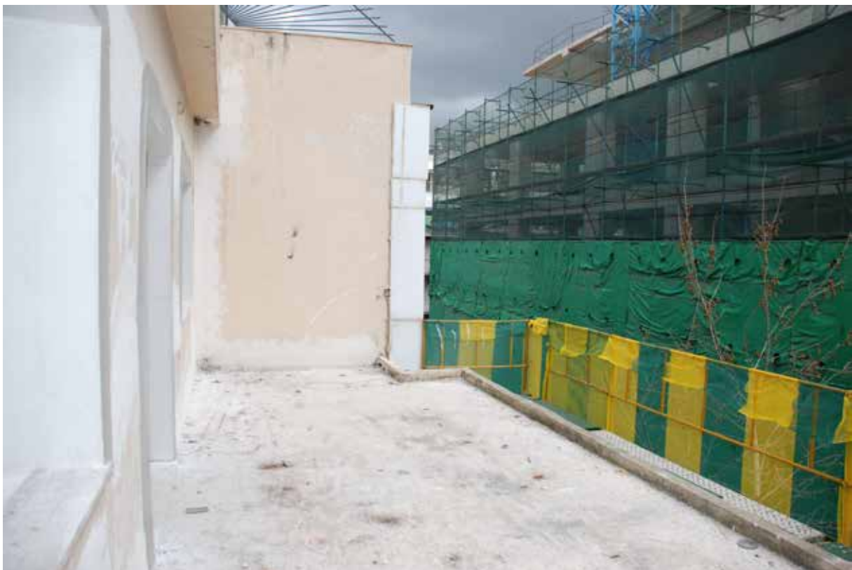
Εικ. Το μπαλκόνι της τρίτης εσοχής . Απέναντι το υπο κατασκευή κτίριο Μινιον
