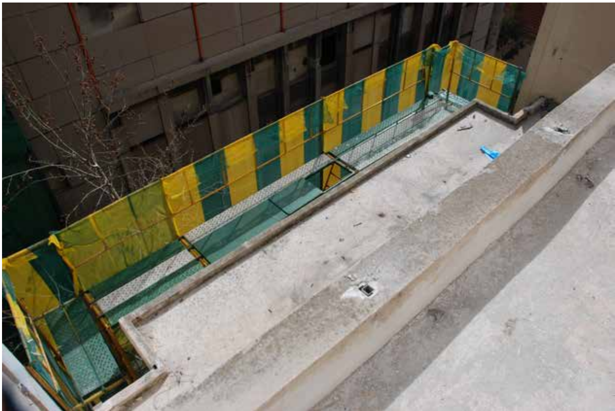
Εικ. Οι εσοχές του κτιρίου απ το δώμα
