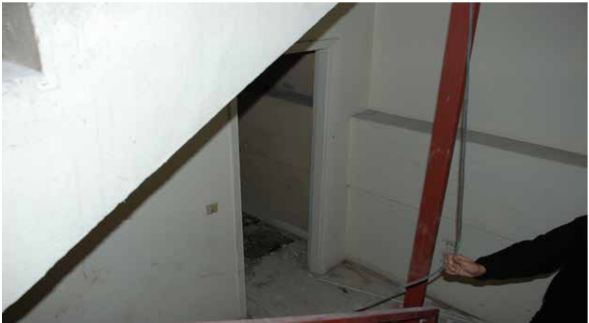
Εικ. Το μικρό δωματάκι στο κλιμακοστάσιο , θα χρησιμοποιηθεί σαν w.c
