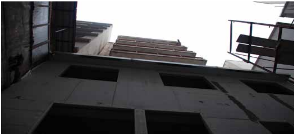
Εικ.94: Το κτίριο απ τον ακάλυπτο εμπρός της σιδηροκατασκευής
