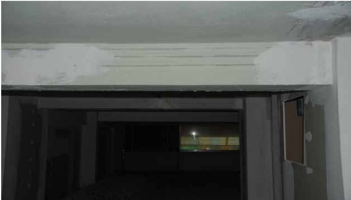
Εικ. Τα δοκάρια σε ορισμένους ορόφους λόγω του μεγέθους των , δημιουργούν πολύ μικρά ελεύθερα ύψη.
