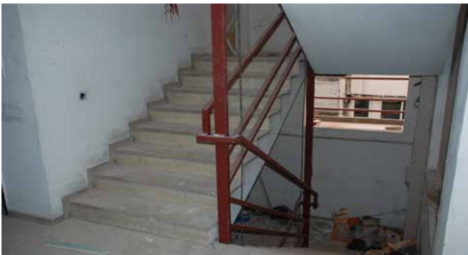
Εικ.100: Το κλιμακοστάσιο στο εσωτερικό του κτιρίου
