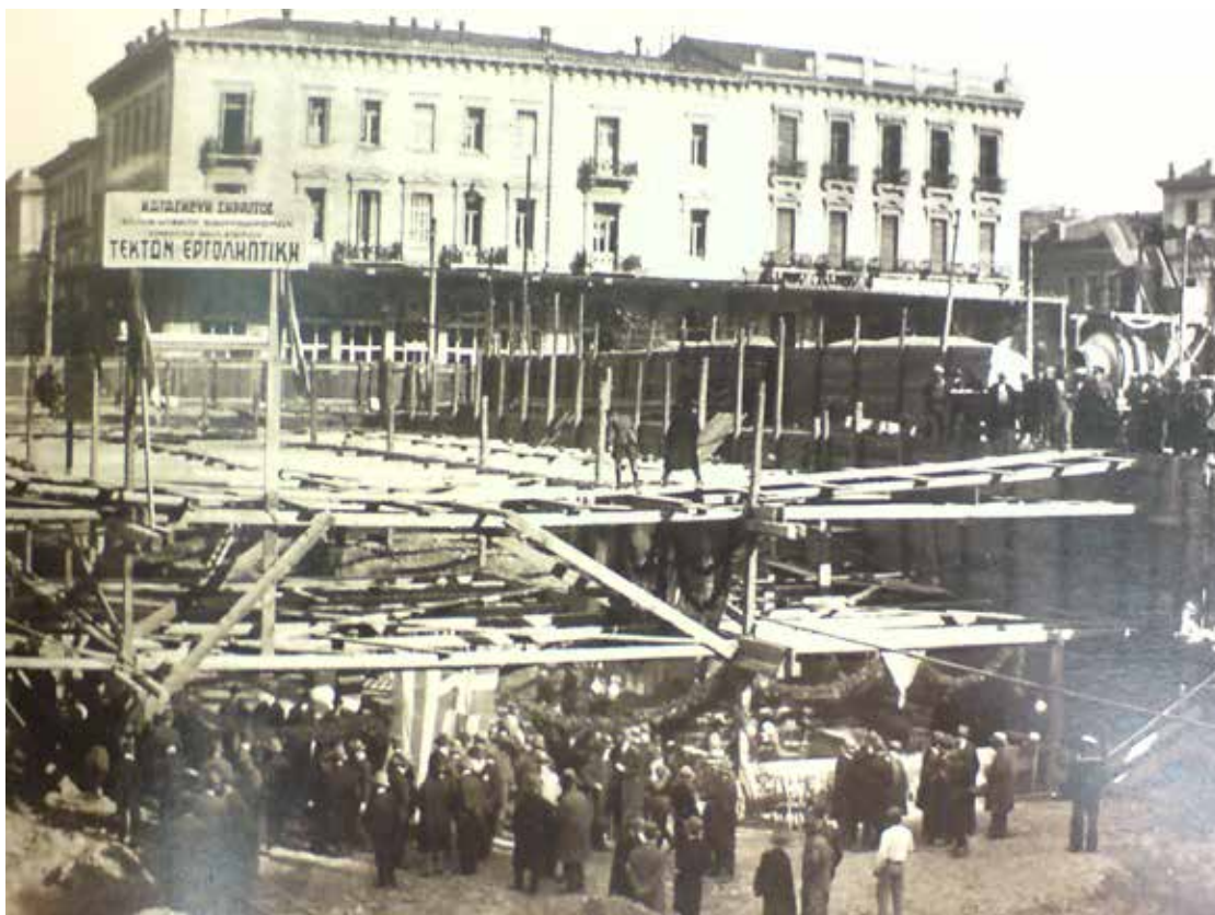
Εικ. Κατασκευή του Ηλεκτρικού Σιδηροδρόμου στο σταθμό της Ομόνοιας
