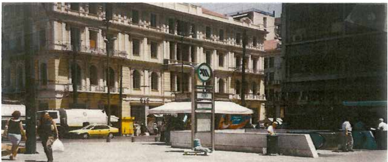
Εικόνα 16: Αττικό μετρό πλατείας Ομονοίας
