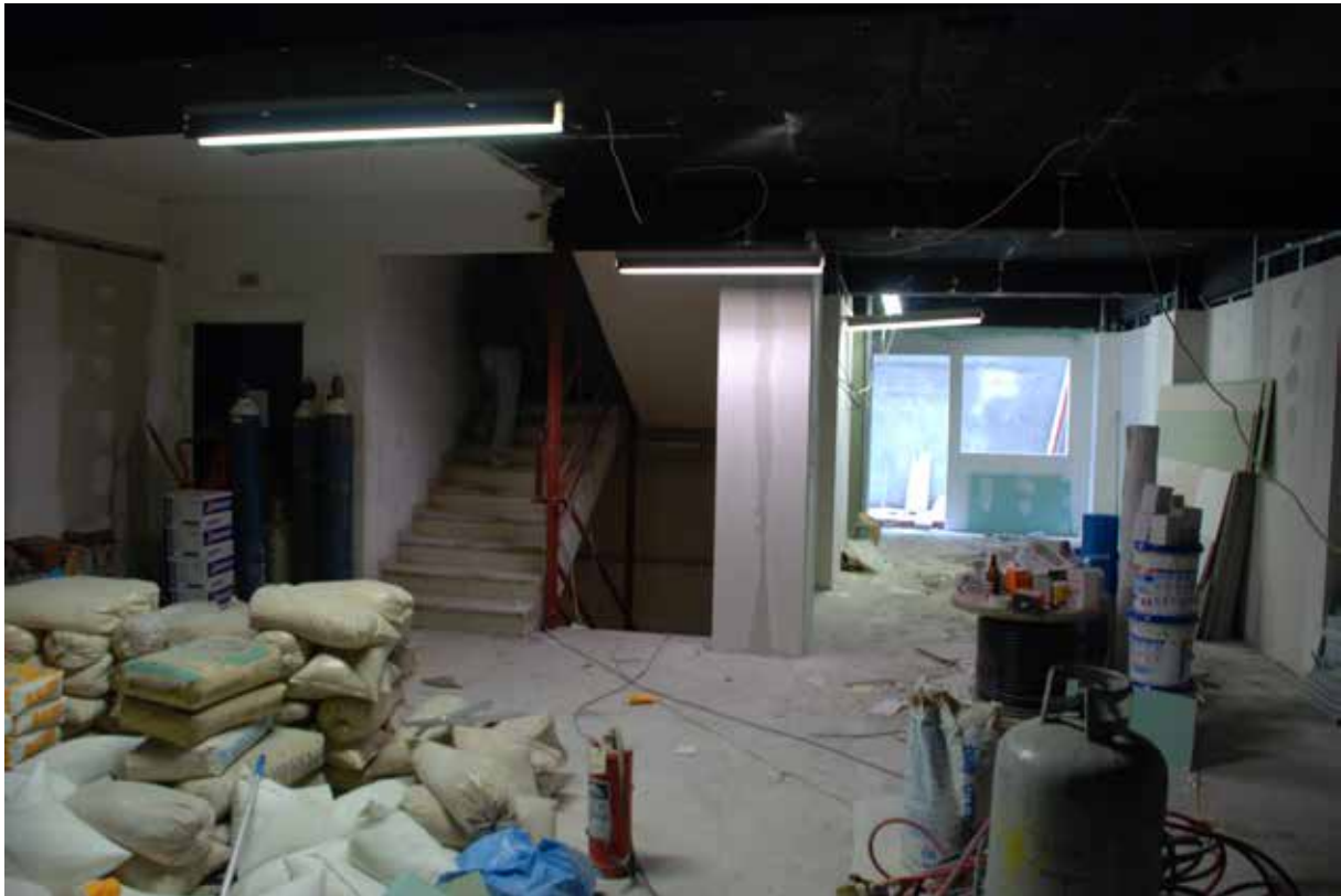
Εικ. Το εσωτερικό του κτιρίου σε φάση ανακατασκευής
