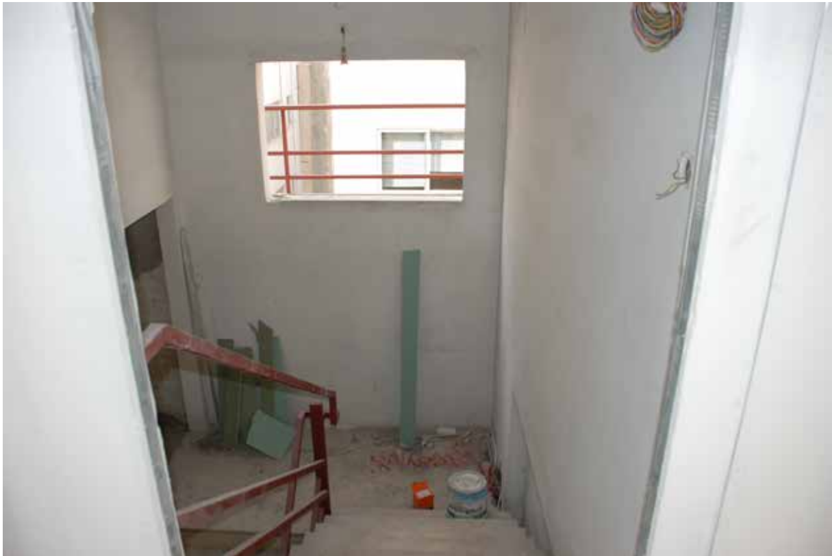
Εικ. Το κλιμακοστάσιο του κτιρίου
