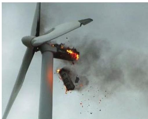
Σχήμα 3.4 Εικόνα ανεμογεννήτριας αμέσως μετά από κεραυνικό πλήγμα
