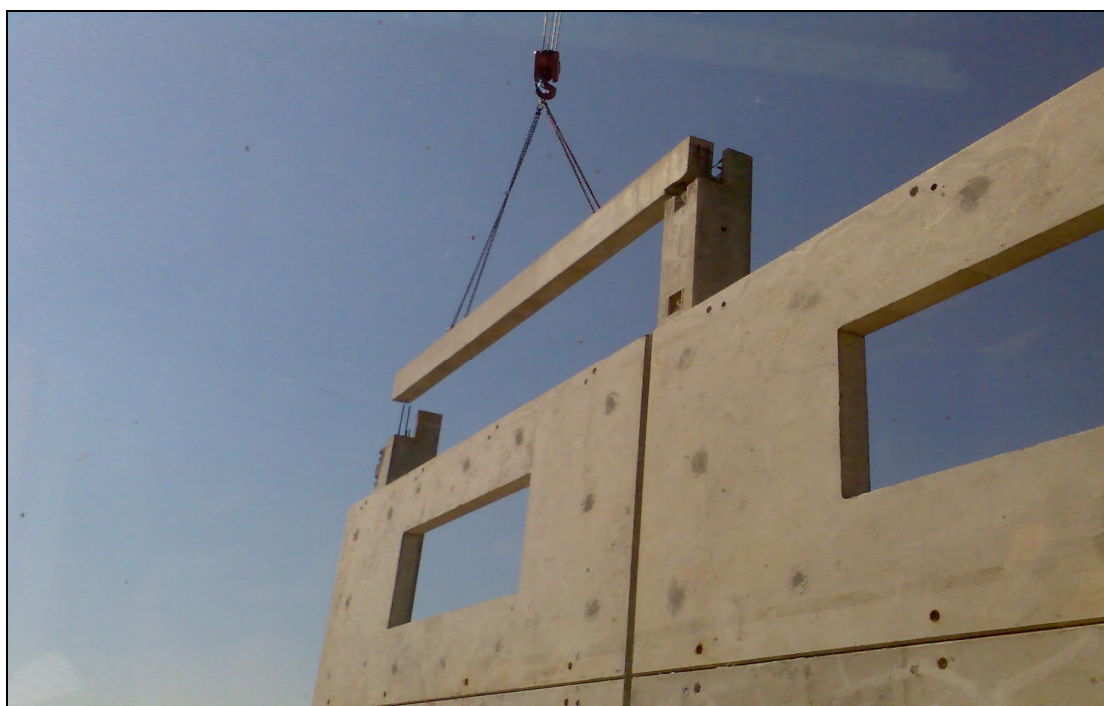
Εικ. 105 Ραβδόμορφα στοιχεία (δοκοί)
