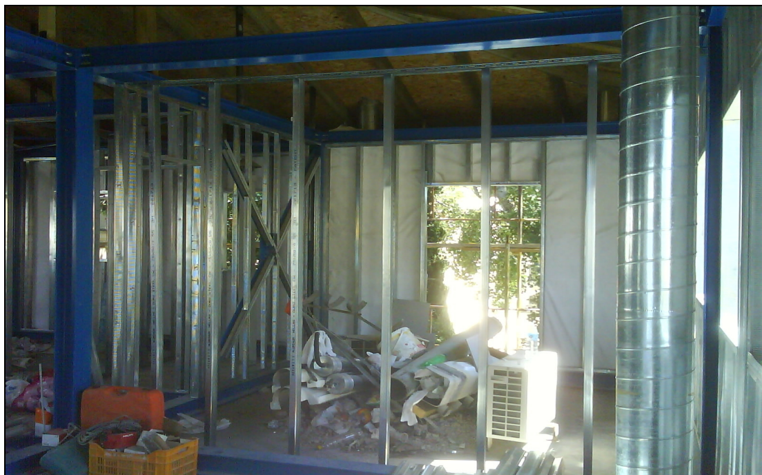
Εικ. 74 Τοποθέτηση κάθετων σιδερένιων ορθοστατών και οριζόντιων στρωτήρων για τη στήριξη γυψοσανίδας
