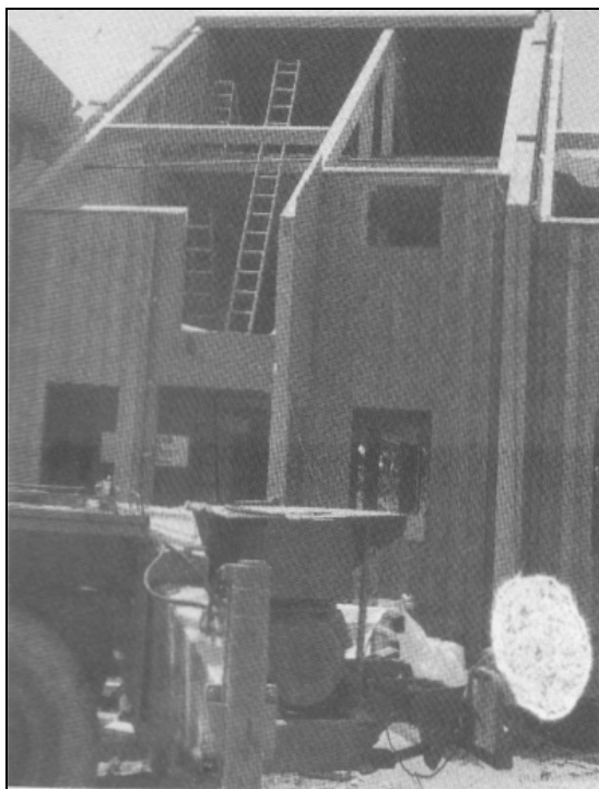
Εικόνα 20 Τοποθέτηση προκατασκευασμένων στοιχείων όψης.
