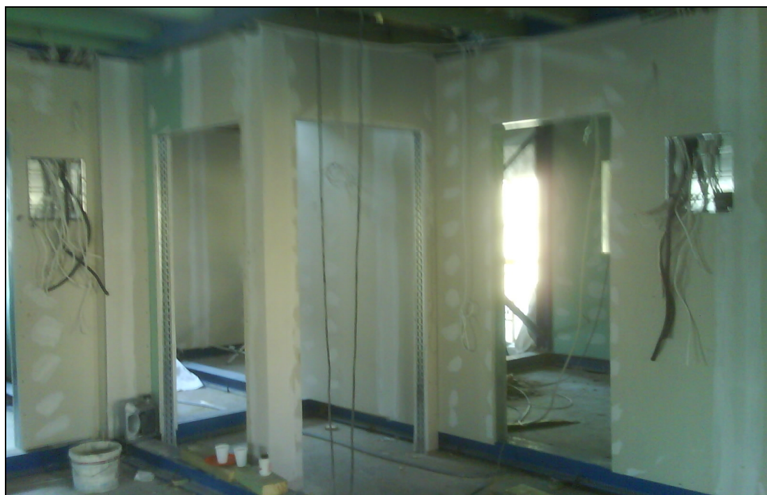
Εικ. 81 Εσωτερική επένδυση τοιχοποιίας με γυψοσανίδα
