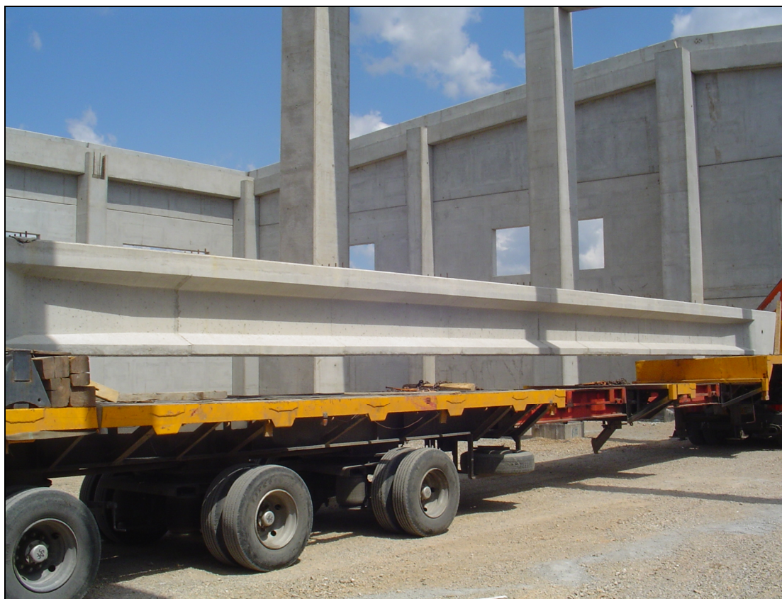
Εικ. 98 Μεταφορά προκατασκευασμένων στοιχείων
