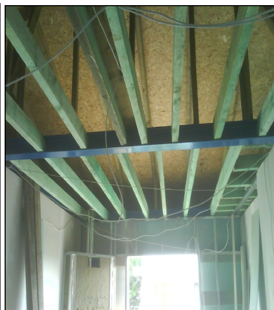
Εικ. 78 Εγκατάσταση ηλεκτρολογικών παροχών
