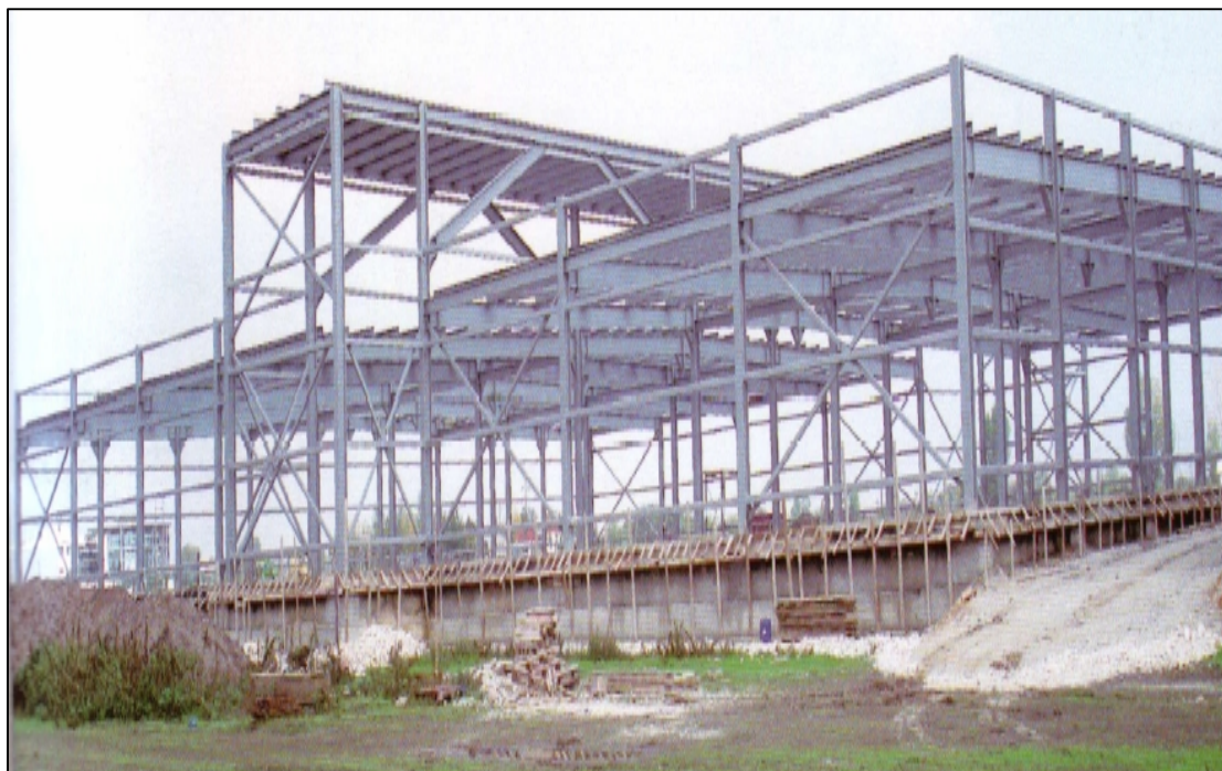
Εικ. 48 Μεταλλική κατασκευή στο στάδιο της ανέγερσης
