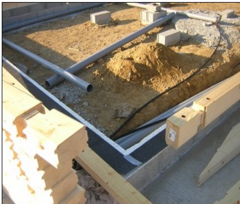
Εικ. 38 Τοποθέτηση υδραυλικών και ηλεκτρολογικών παροχών ανάμεσα στα δύο στάδια κατασκευής
