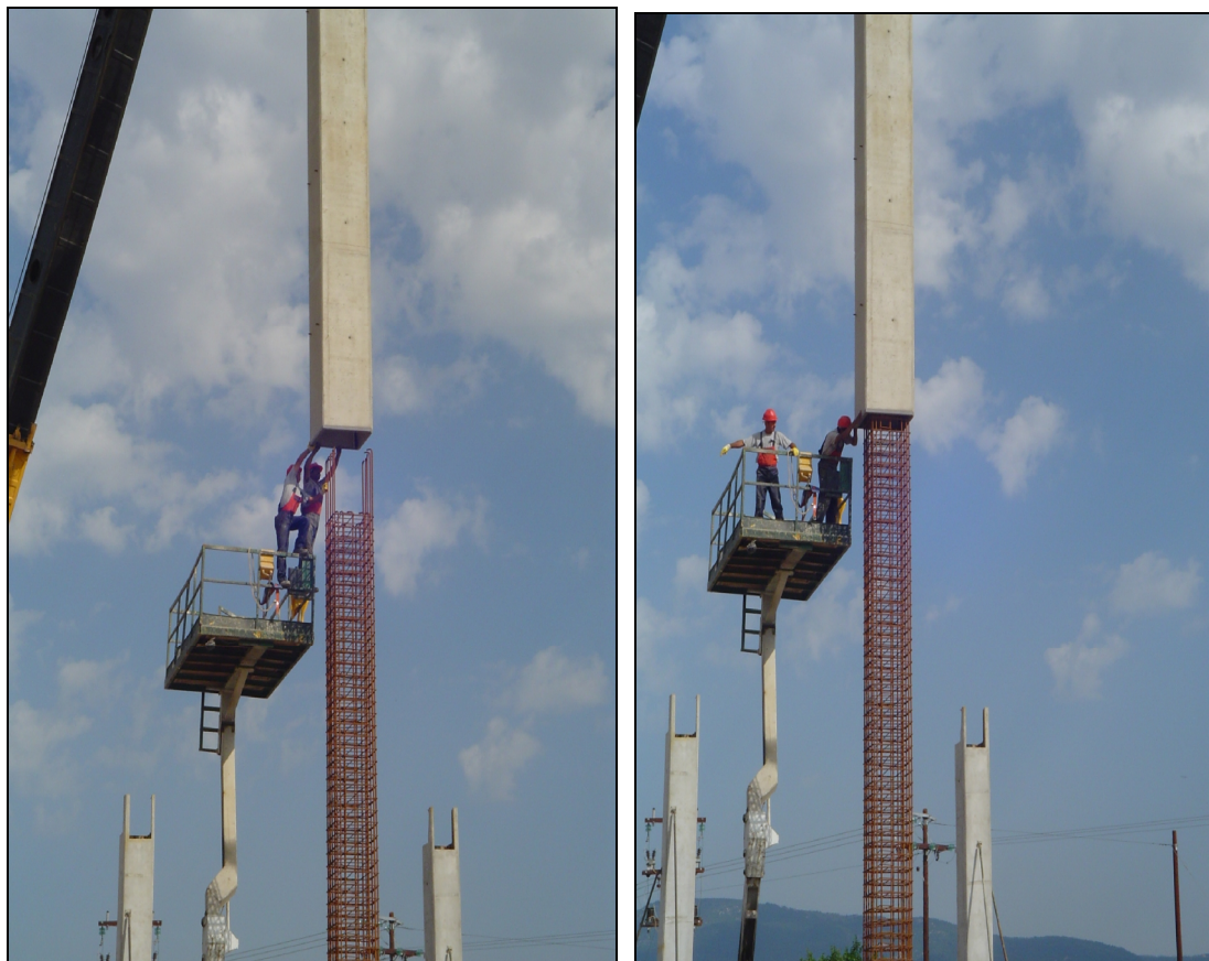
Εικ. 115 & 116 Τοποθέτηση φλοιού υποστυλώματος εξωτερικά του κλωβού
