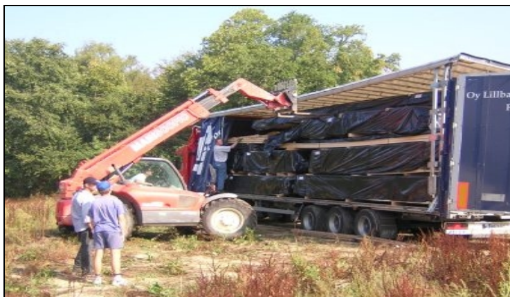
Εικ. 33 Μεταφορά των κορμών στο χώρο του έργου
