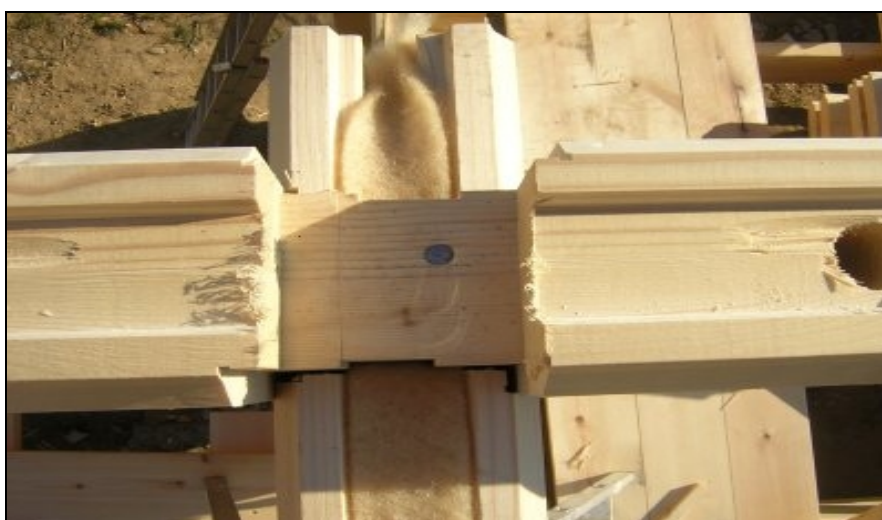
Εικ. 16 Σύνδεση στοιχείων με ξυλόβιδες
