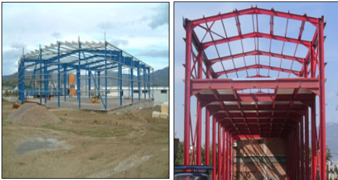
Εικ. 89 & 90 Συναρμολόγηση μεταλλικού σκελετού βιομηχανικού κτιρίου και μεταλλικού σκελετού δώροφου βιομηχανικού κτιρίου 2000 m 2
