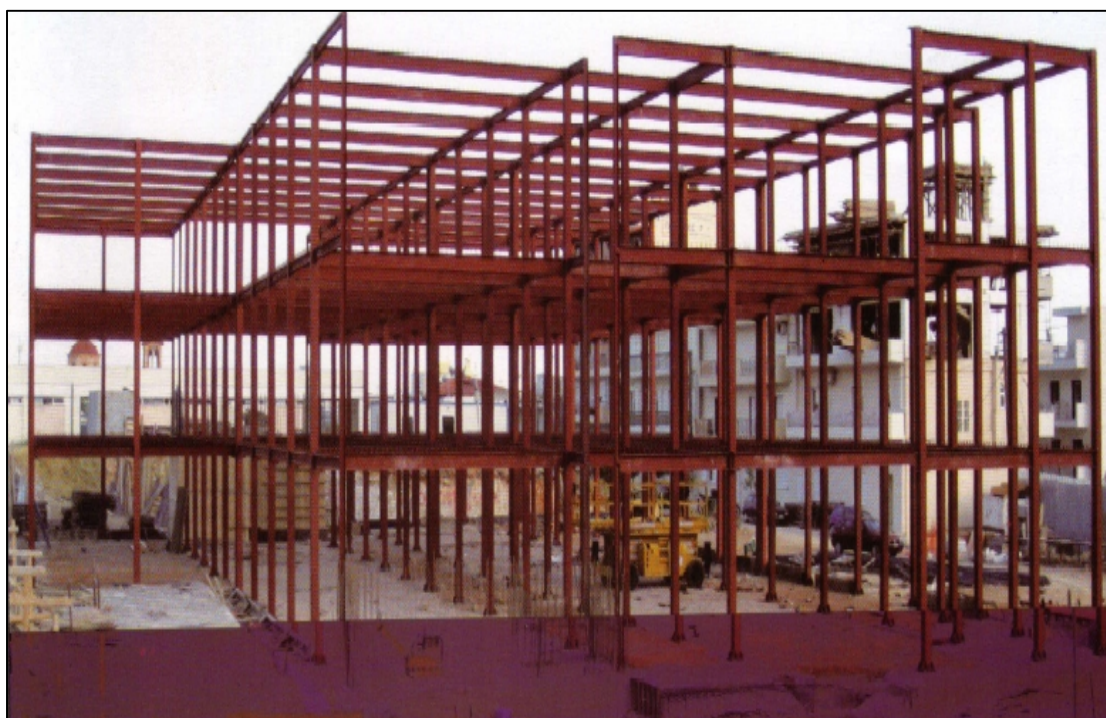
Εικ. 49 Μεταλλική κατασκευή στο στάδιο της ανέγερσης
