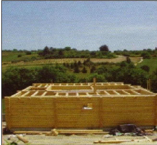
Εικόνα 36 Συναρμολόγηση των κορμών
