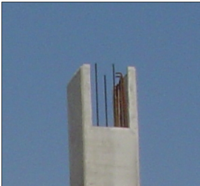
Εικ. 131 Λεπτομέρεια υποστυλώματος με εμφανής ντίζες για την τοποθέτηση του δοκαριού, με μπουλόνια
