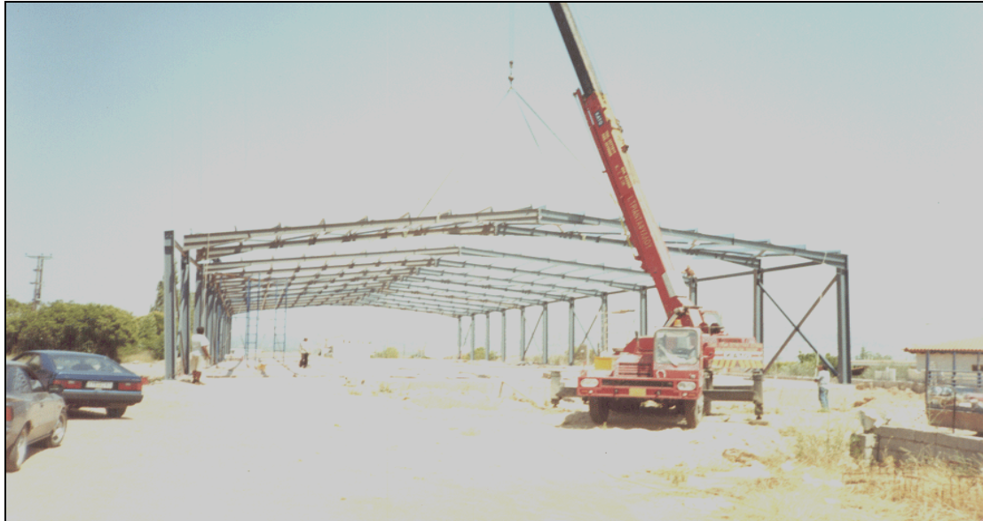
Εικ. 88 Ανέγερση μεταλλικής κατασκευής βιομηχανικού κτιρίου 1380 m 2
