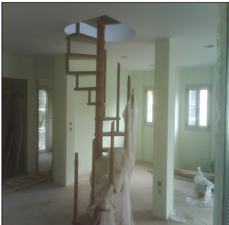
Εικ. 84 Τελική άποψη καθιστικού και εσωτ. σκάλας
