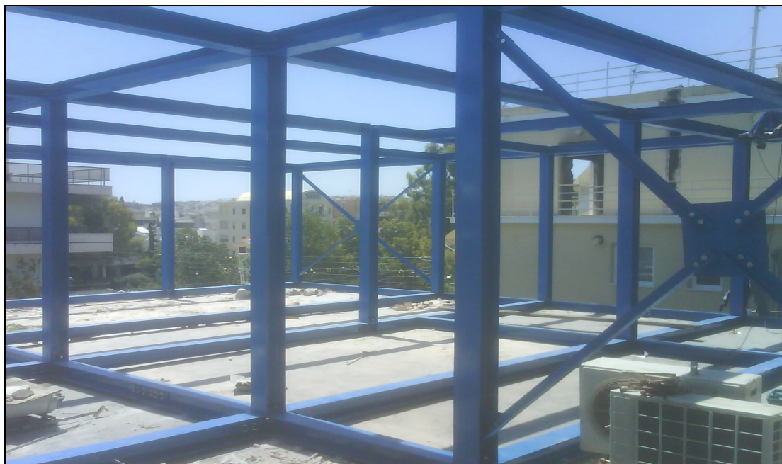
Εικ. 70 Συναρμολόγηση μεταλλικών στοιχείων (κατασκευή σκελετού)
