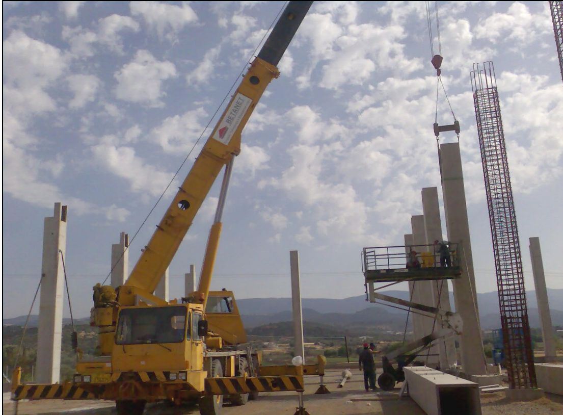
Εικ. 97 Τοποθέτηση προκατασκευασμένων στοιχείων με γερανό
