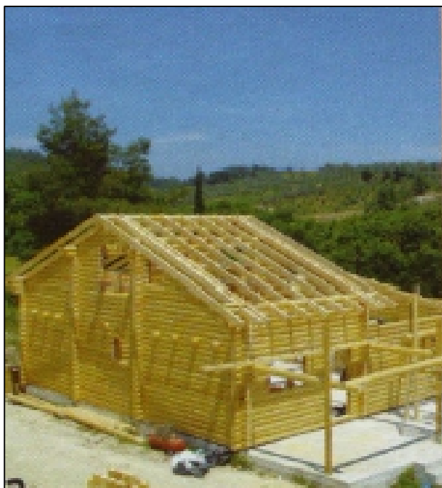
Εικ. 39 Κατασκευή ορόφου
