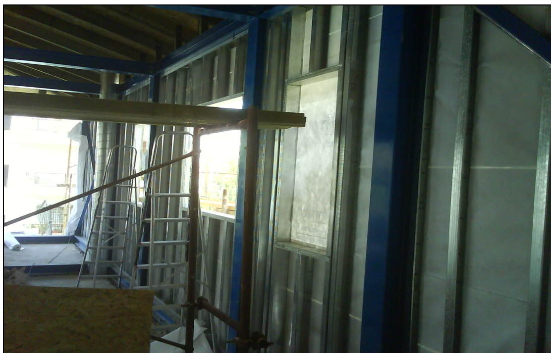
Εικ. 71 Εξωτερική επένδυση τοιχοποιίας με τσιμεντοσανίδα και τοποθέτηση κάθετων σιδερένιων ορθοστατών για τη στήριξη της τσιμεντοσανίδας (εσωτερική λήψη φωτογραφίας)
