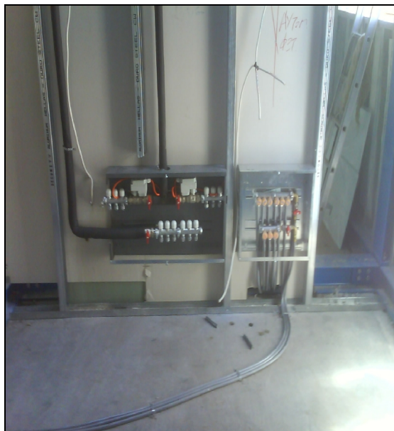
Εικ. 79 Εγκατάσταση ηλεκτρολογικών παροχών
