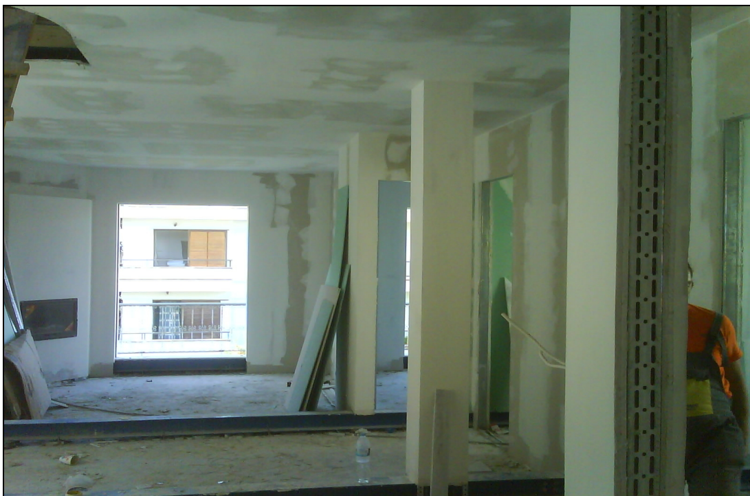
Εικ. 82 Εσωτερική επένδυση τοιχοποιίας με γυψοσανίδα
