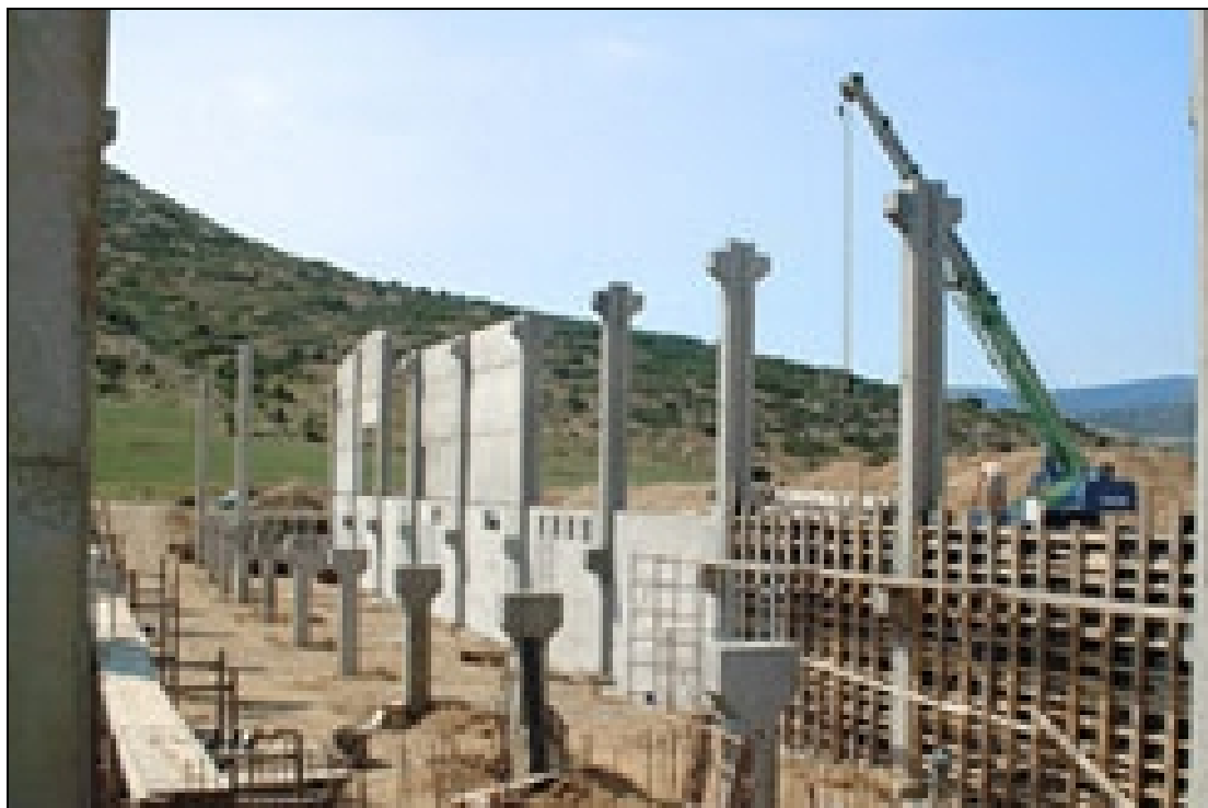
Εικ. 122 Ανύψωση και μεταφορά στοιχείων με τη χρήση αυτοκινούμενου γερανού
