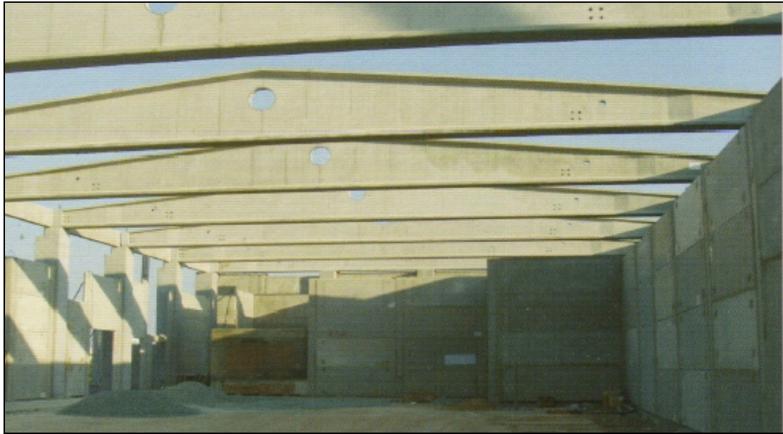
Εικ. 132 Βιομηχανικό κτίριο υπό κατασκευή
