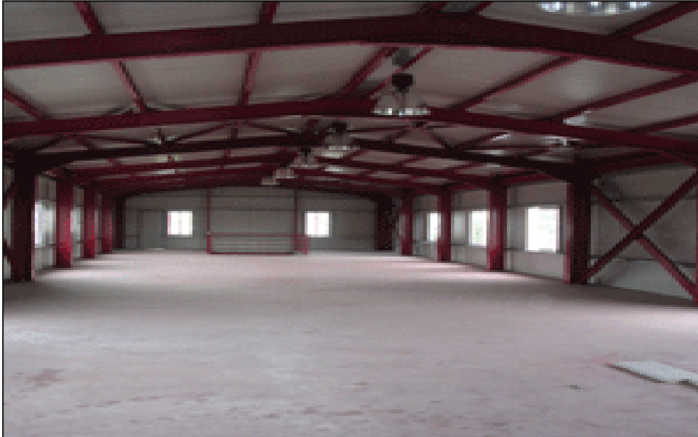
Εικ. 91 Εσωτερική όψη ορόφου μεταλλικού - βιομηχανικού κτιρίου
