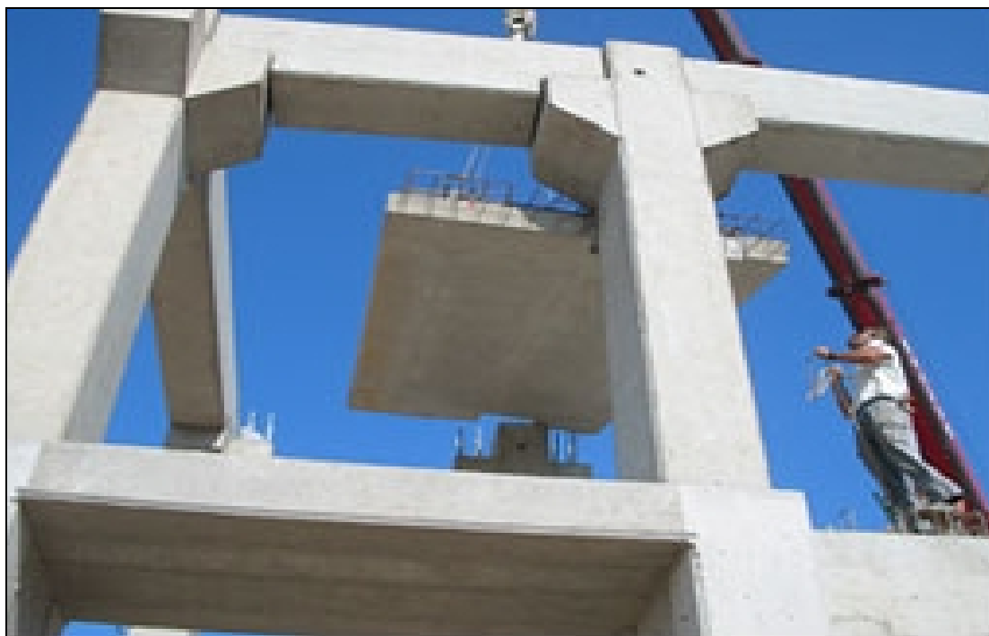
Εικ. 128 Σύνδεση γειτονικών στοιχείων
