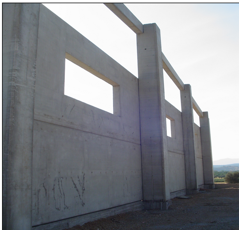
Εικ. 104 Ραβδόμορφα στοιχεία (υποστυλώματα, δοκοί)
