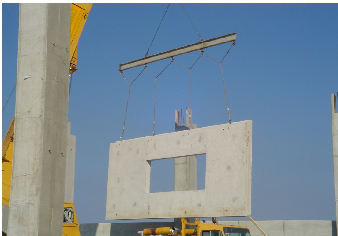
Εικ. 123 Ανύψωση και μεταφορά τοιχείου με τη χρήση αυτοκινούμενου γερανού
