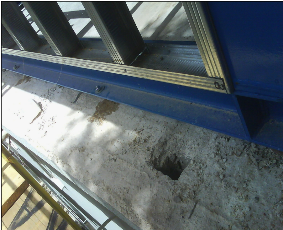
Εικ. 66 Λεπτομέρεια οπής στην υπάρχουσα πλάκα
