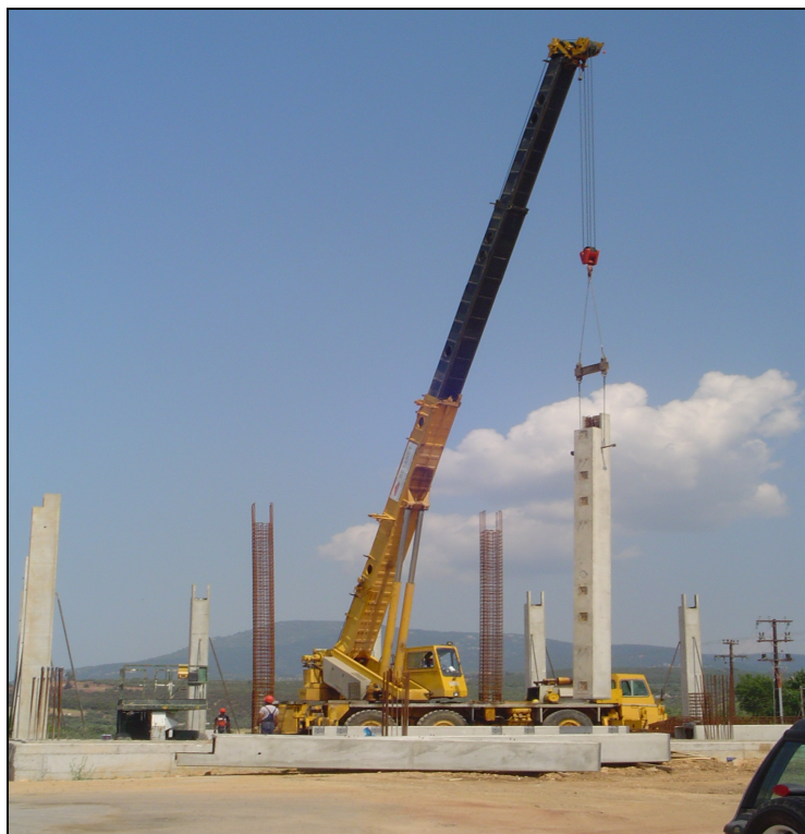
Εικ. 96 Τοποθέτηση προκατασκευασμένων στοιχείων με γερανό
