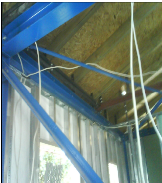
Εικ. 77 Εγκατάσταση ηλεκτρολογικών παροχών
