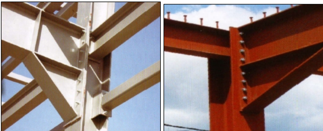
Εικ. 52 & 53 Κόμβοι μεταλλικών στοιχείων συνδεδεμένοι με κοχλίες
