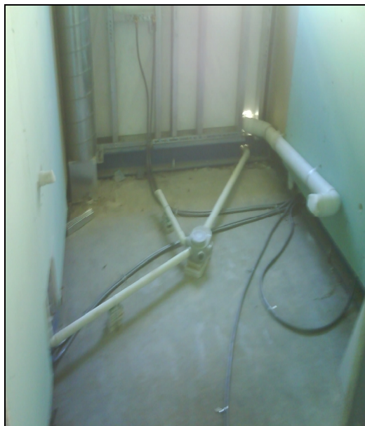
Εικ. 80 Εγκατάσταση υδραυλικών παροχών
