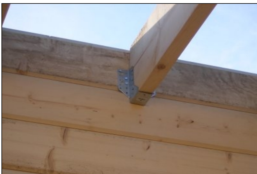
Εικ. 17 Σύνδεση στοιχείων με μεταλλικές λάμες
