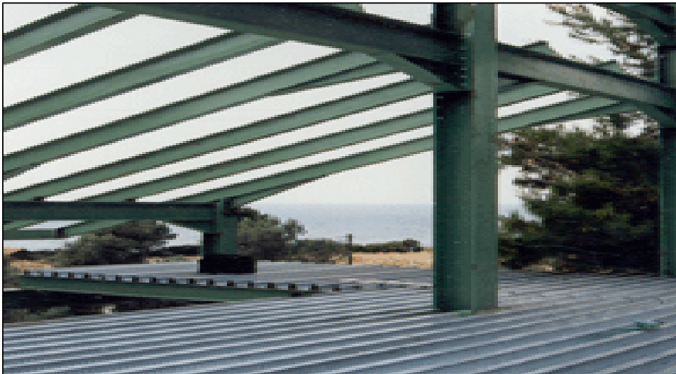
Εικ. 92 Επικάλυψη μεταλλικών δοκών με τραπεζοειδή λαμαρίνα (πλάκα)
