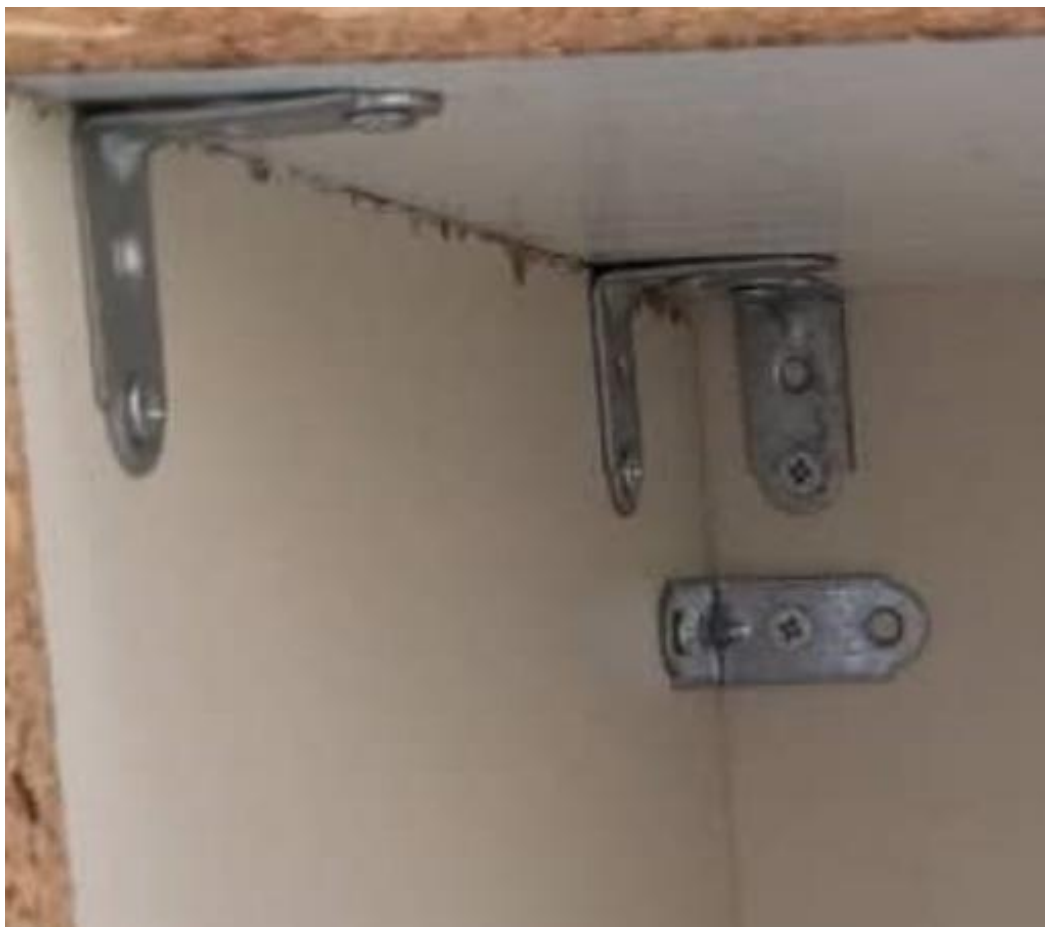
Εικόνα 14 Λεπτομέρεια μεταλλικών γωνιών
