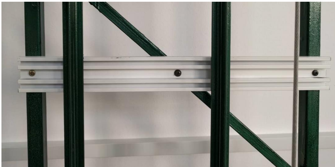
Εικόνα 8 Μεταλλική λάμα στήριξης παράλληλη στο έδαφος
