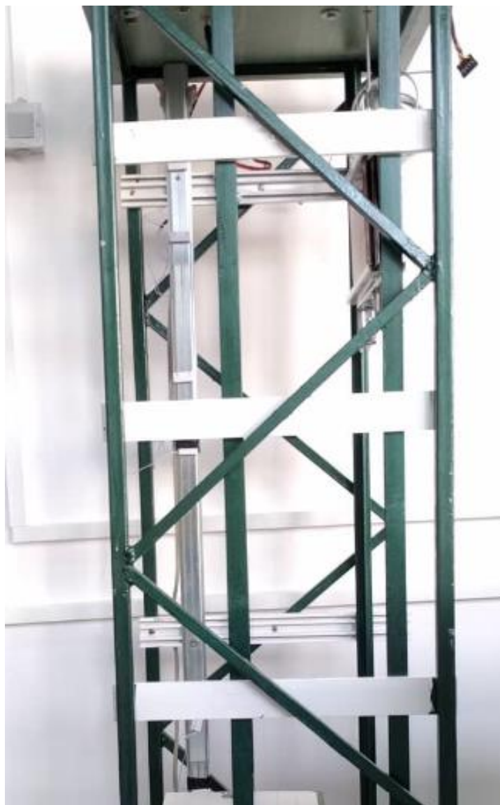
Εικόνα 7 Μεταλλικές νευρώσεις φρεατίου
