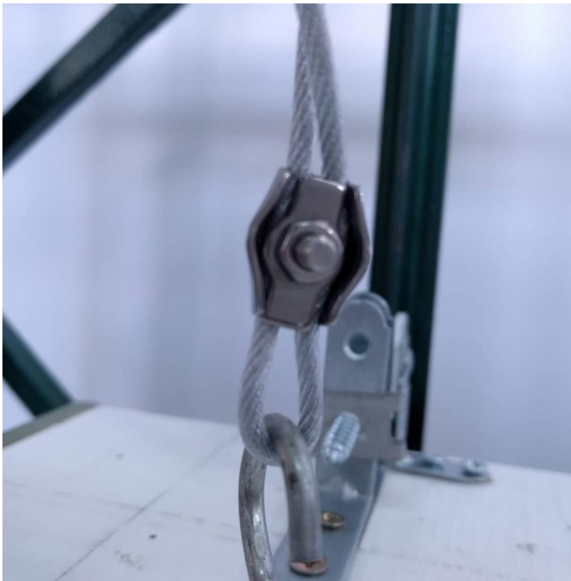
Εικόνα 17 Λεπτομέρεια συρματοσχοινο - σφιγκτήρα - γάντζου
