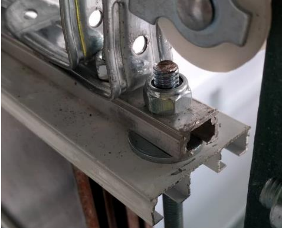
Εικόνα 20 Λεπτομέρεια παξιμαδιού ασφαλείας αντίβαρου
