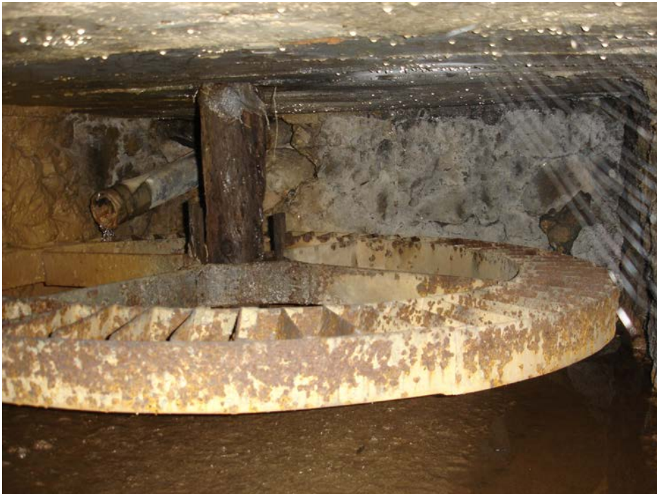
Εικόνα 8. Ημιυπόγειος χώρος και οριζόντια φτερωτή στον μπαρουτόμυλο του Παρασκευόπουλου
