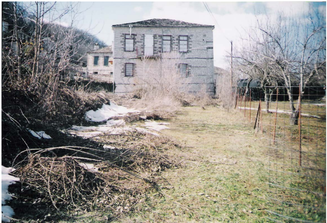
ΔΕΞΙΑ ΠΛΑΓΙΑ ΟΨΗ ΚΤΙΡΙΟΥ
