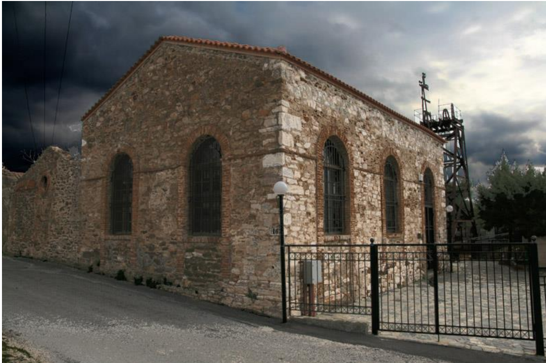
Εικόνα 6 Το κτίριο που στεγάζε τις μηχανές του ορυχείου Σερπιέρι
