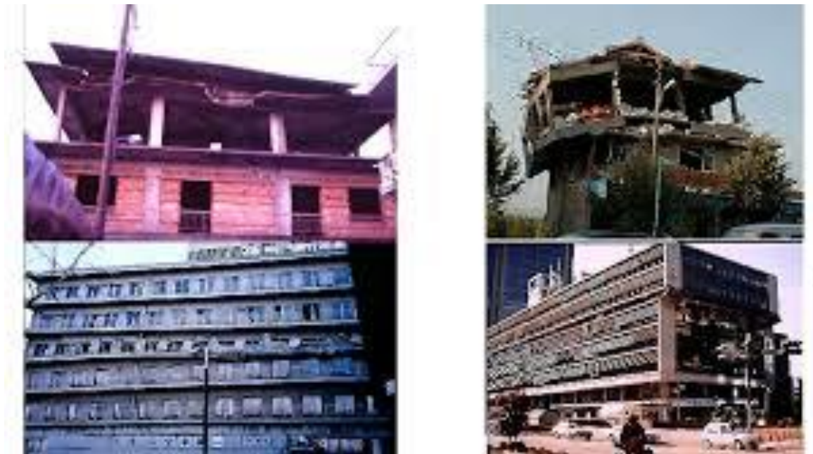
Σχήμα 6 : Αστοχία κτιρίων λόγω μειωμένης δυσκαμψίας
