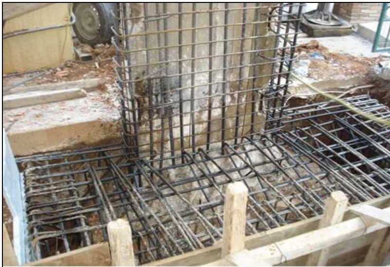
Εικόνα 3.23: : Ενίσχυση με πρόσθετος μανδύας στο πέδιλο θεμελίωσης
