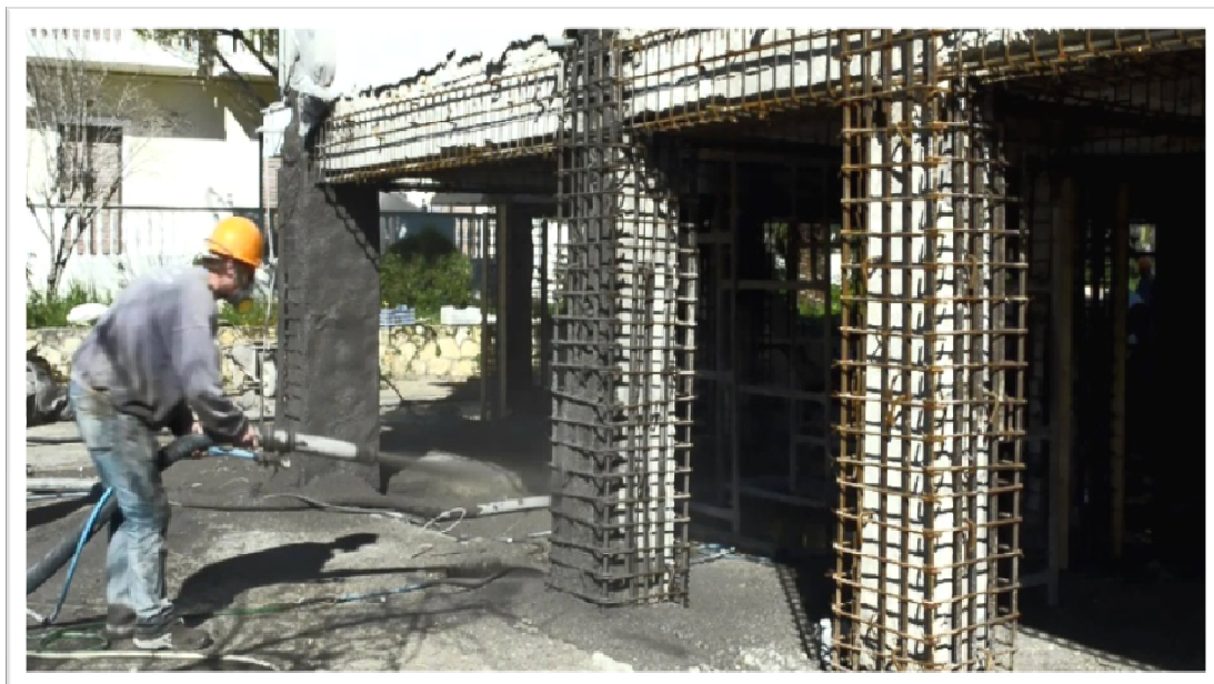
Εικόνα 3.4 : Ενίσχυση υποστυλώματος με μανδύα από εκτοξευόμενο σκυρόδεμα
