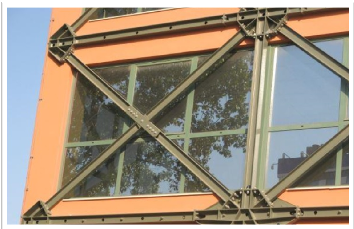
Εικόνα 3.11: Ενίσχυση με κεντρικό χιαστί μεταλλικό σύνδεσμο.
