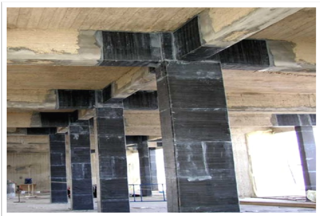
Εικόνα 3.13: Ενίσχυση υποστυλωμάτων και δοκών με ΙΟΠ
