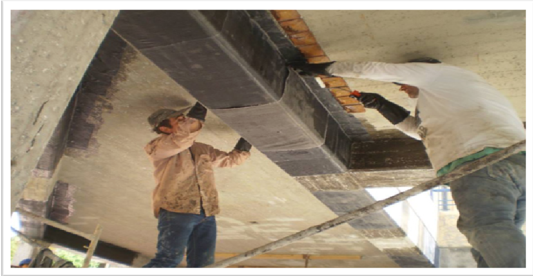
Εικόνα 3.12: Ενίσχυση δοκών με ΙΟΠ
