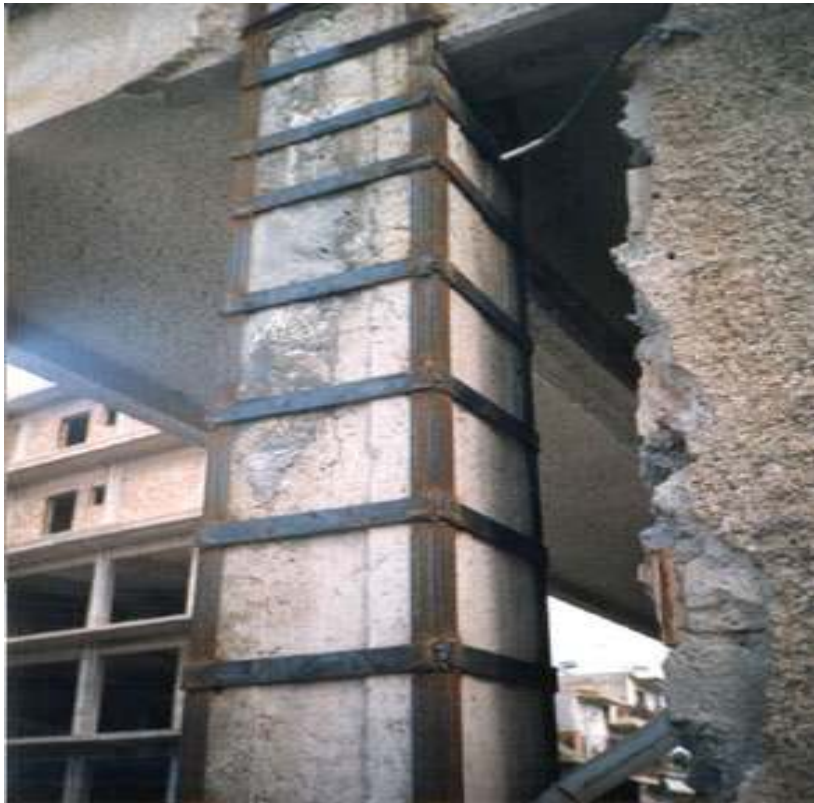
Εικόνα 3.16: Ενίσχυση υποστυλώματος με επικολητά χαλύβδινες λάμες.
