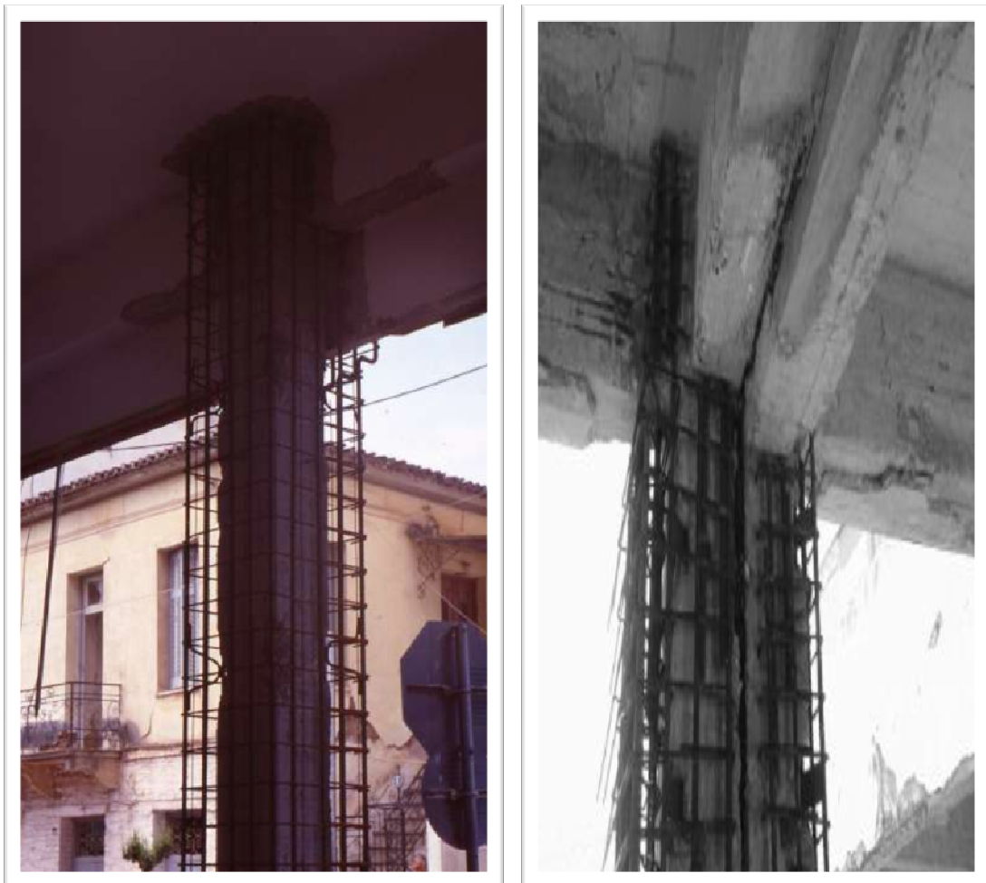
Εικόνα 3.2 : Ενίσχυση υποστυλώματος με μανδύα οπλισμένου σκυροδέματος
