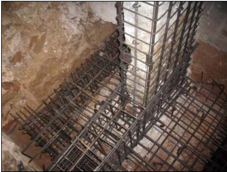
Εικόνα 3.22: Ενίσχυση με πρόσθετος μανδύας στο πέδιλο θεμελίωσης.
