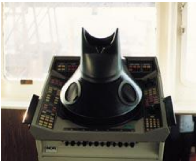
Εικόνα: ARPAραντάρ και ραδιοφωνικός δέκτης γέφυρας
