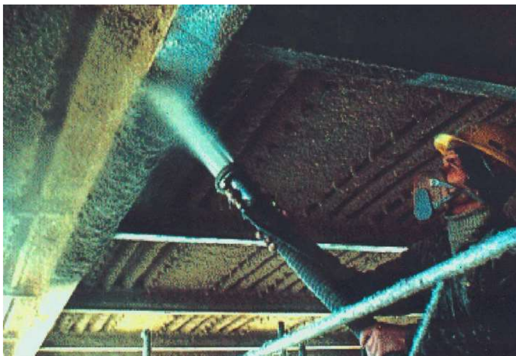
Εικόνα 11. Εφαρμογή εκτοξευόμενου επιχρίσματος
