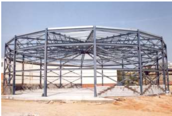
Εικόνα 1. Σκελετός Μεταλλικού Κτιρίου
