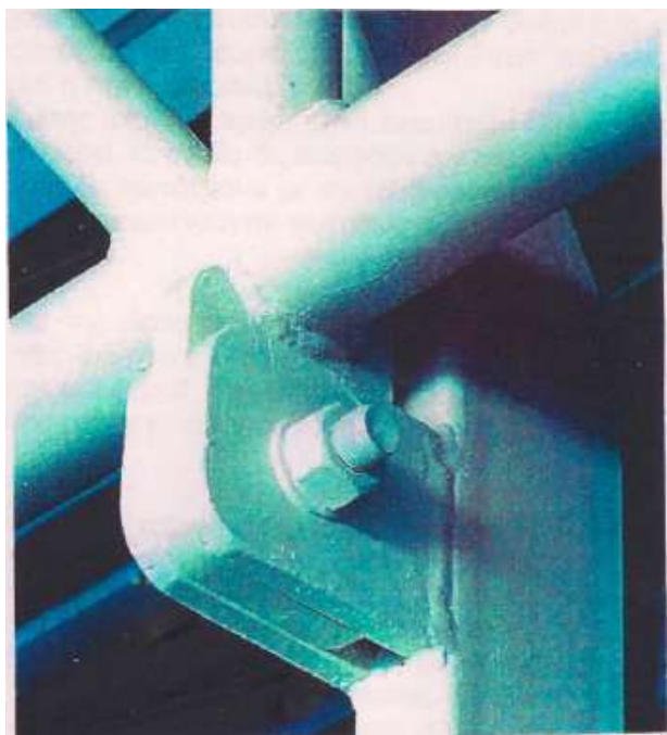
Εικόνα 12: Εφαρμογή χρώματος πυροπροστασίας σε μεταλλικό στοιχείο
