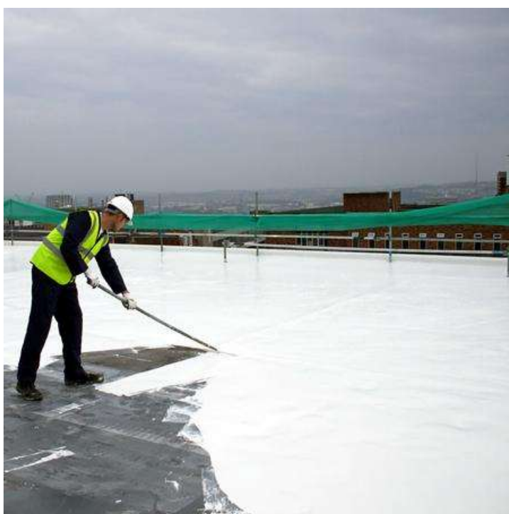
Εικόνα 13: Εφαρμογή χρώματος πυροπροστασίας σε μεταλλική στέγη
