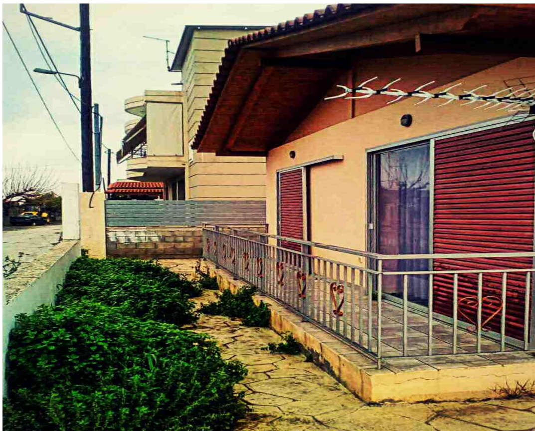
Εικόνα 1.4.5 Βορειοδυτική όψη κατασκευής. Πηγή: προσωπικό αρχείο (2017)
