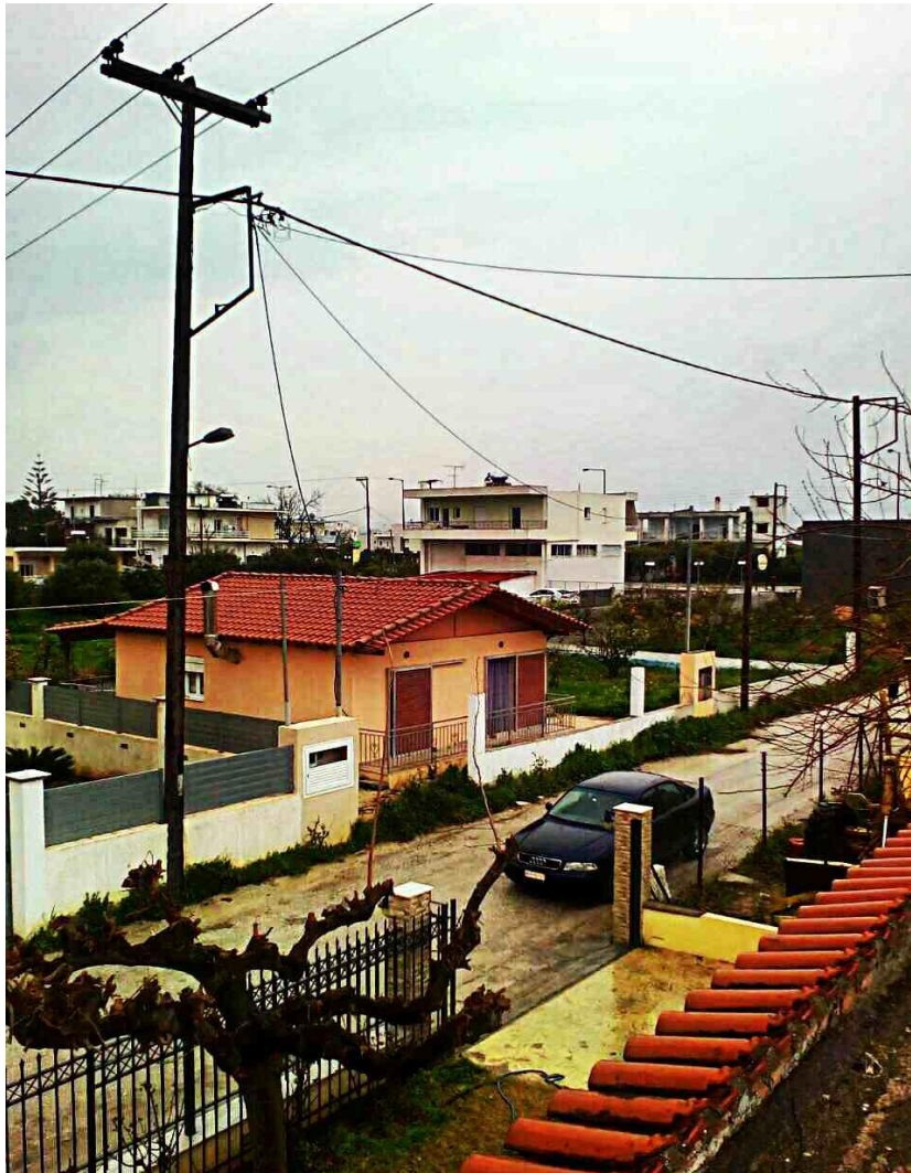
Εικόνα 1.4.2 Βορειοδυτική και βορειοανατολική όψη κατοικίας. Πηγή: προσωπικό αρχείο (2017)
