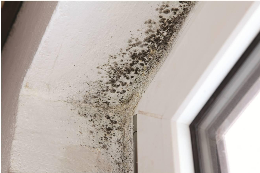
Εικόνα 3.3.2 Δημιουργία τοπικής μούχλας στο πρέκι του παραθύρου. Πηγή : https://verkom.ru/public/image859a584e.jpg
