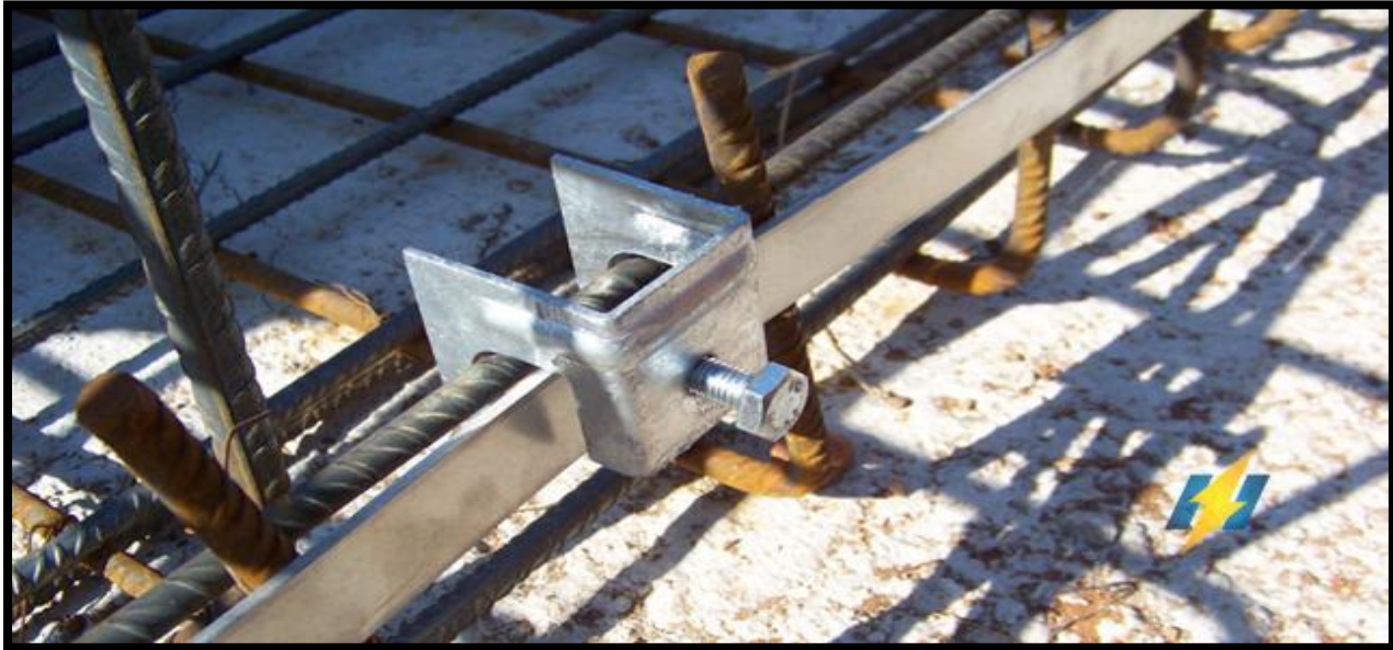
Πίνακας 4.6. Κατασκευή θεμελιακής γείωσης για την φωτοβολταϊκή εγκατάσταση.
