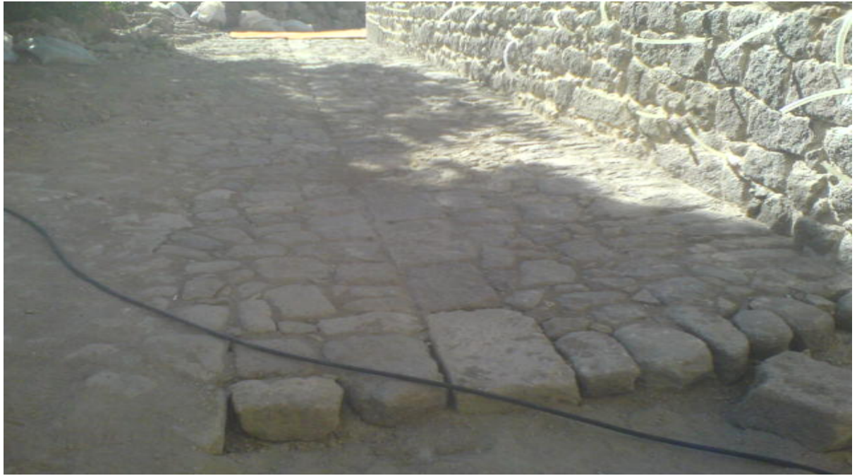
Ολοκλήρωση τμήματος λιθοστρωτου
