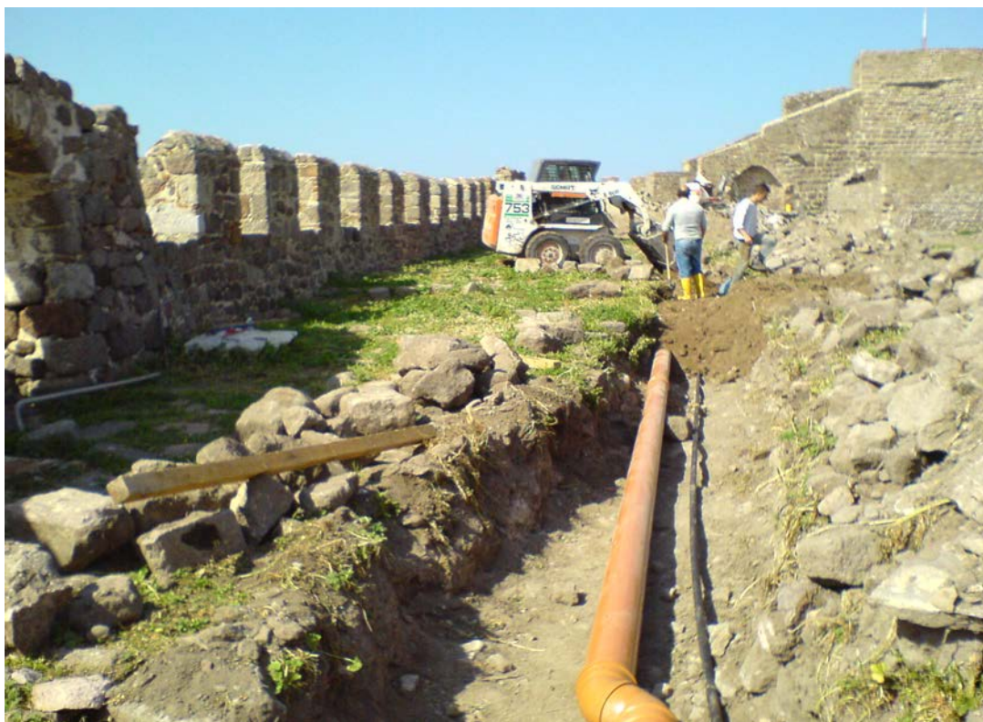
Τοποθέτηση σωληνων ομβριων υδατων – υδρευσης – ισχυρων και ασθενων η-μ εγκαταστασεων.
