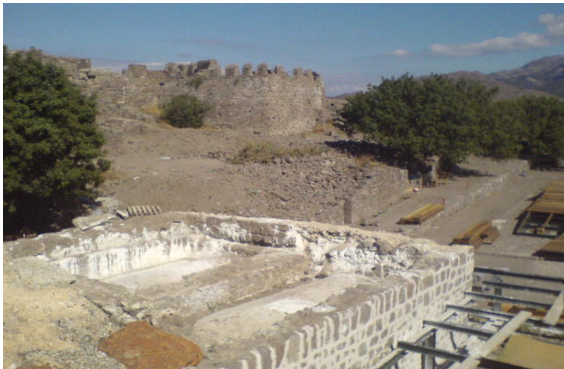
Ολοκλήρωση ενεματος Στο Κ1
