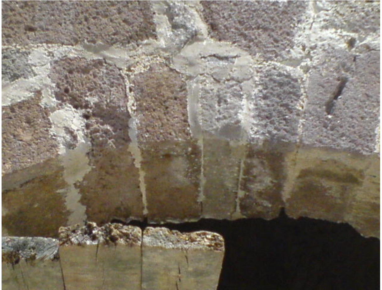
Αντικατάσταση λίθινου κλειδίου
