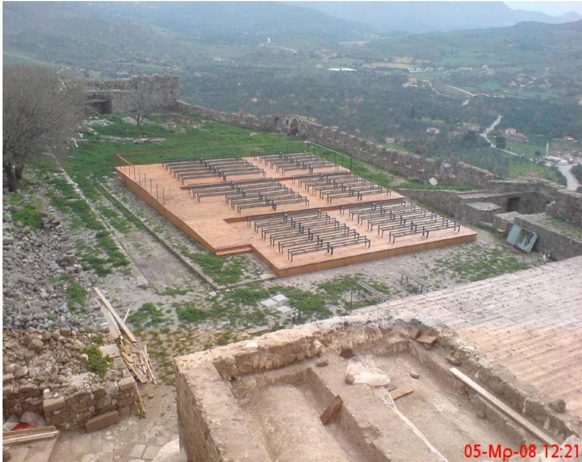
Τοποθέτηση καθισμάτων στις κερκίδες του θεατρου
