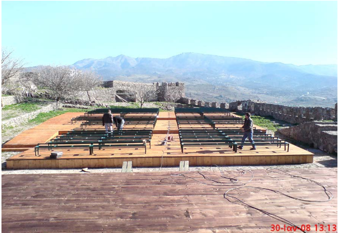
Τοποθέτηση καθισμάτων με χαμηλή πλατυ
