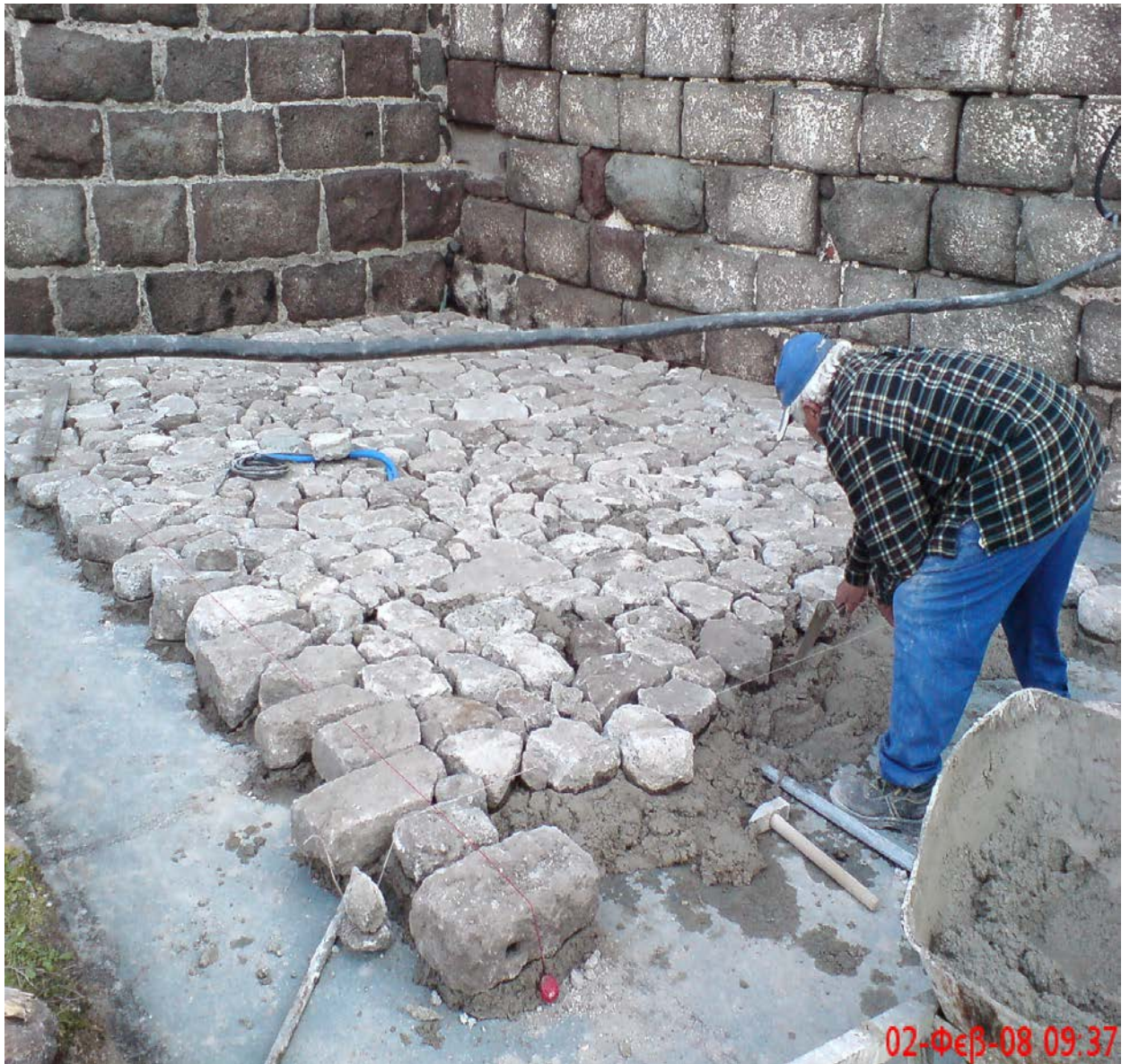
Κατασκευή λιθόστρωτου με λίθους από διαλογή
