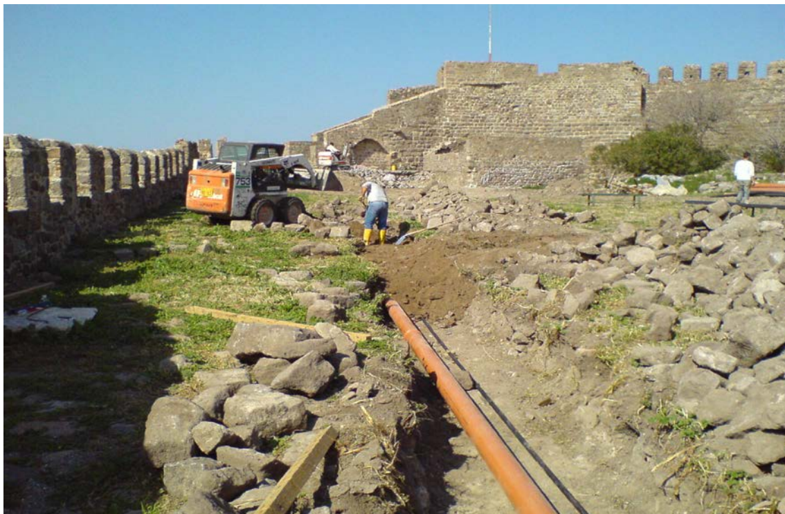
Τοποθέτηση σωληνων ομβριων υδατων – υδρευσης – ισχυρων και ασθενων η-μ εγκαταστασεων.
