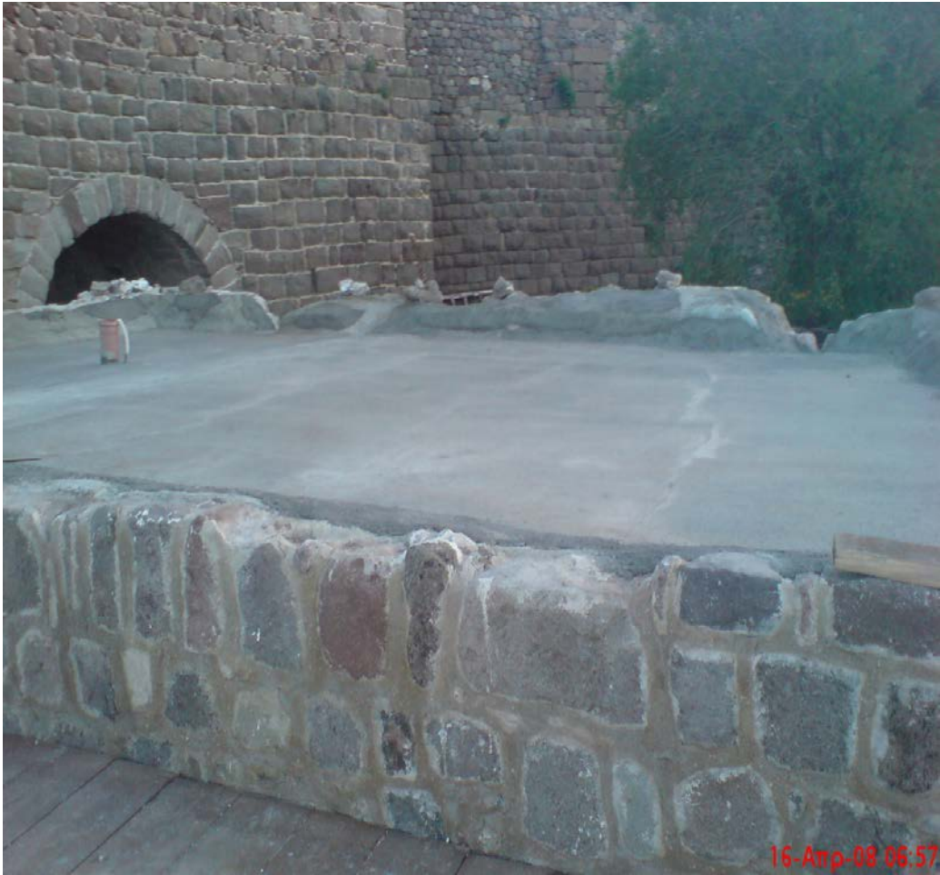
Περλιτοδεμα στο δώμα του Εκθεσιακού κατασκευή
