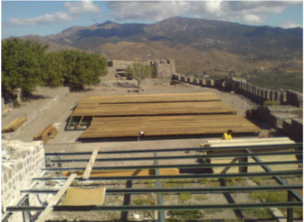
Σανιδωμα κερκιδων με σανιδες παχους 47 χιλιοστων και πλτος 300 χιλιοστων
