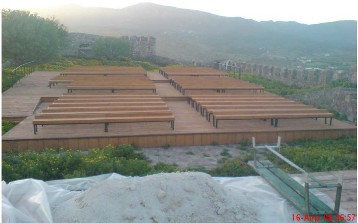
Ολοκλήρωση καθισμάτων κερκιδων
