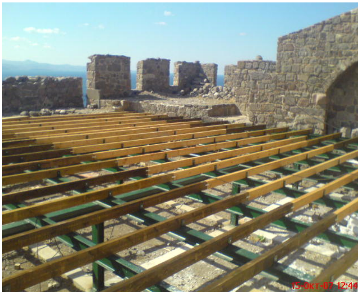
Τοποθέτηση τεγιδων διατομής 0,125*0,05 στη σκηνη
