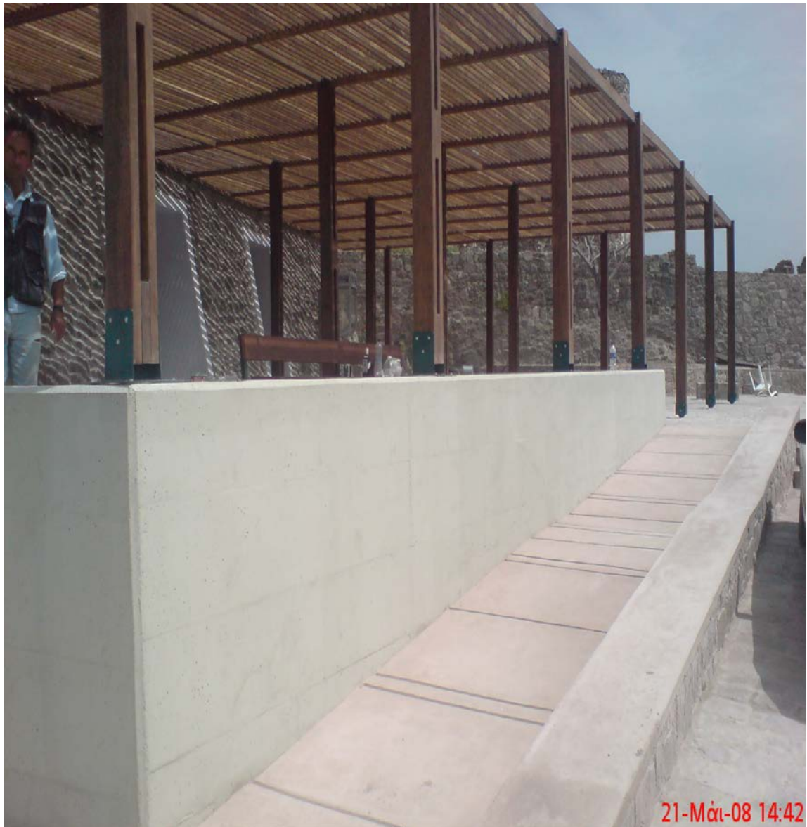
Ραμπα εισόδου με σκυρόδεμα με προσμικτο υλικό ακρυλικής βασής
