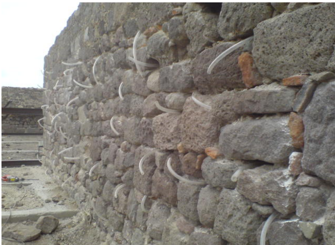
Σωληνησκοι για την εναρξη ενεματος
