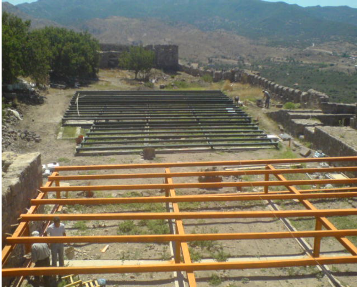
Κατασκευή μεταλλικής σκηνής και προετοιμασία για χρωματισμό
