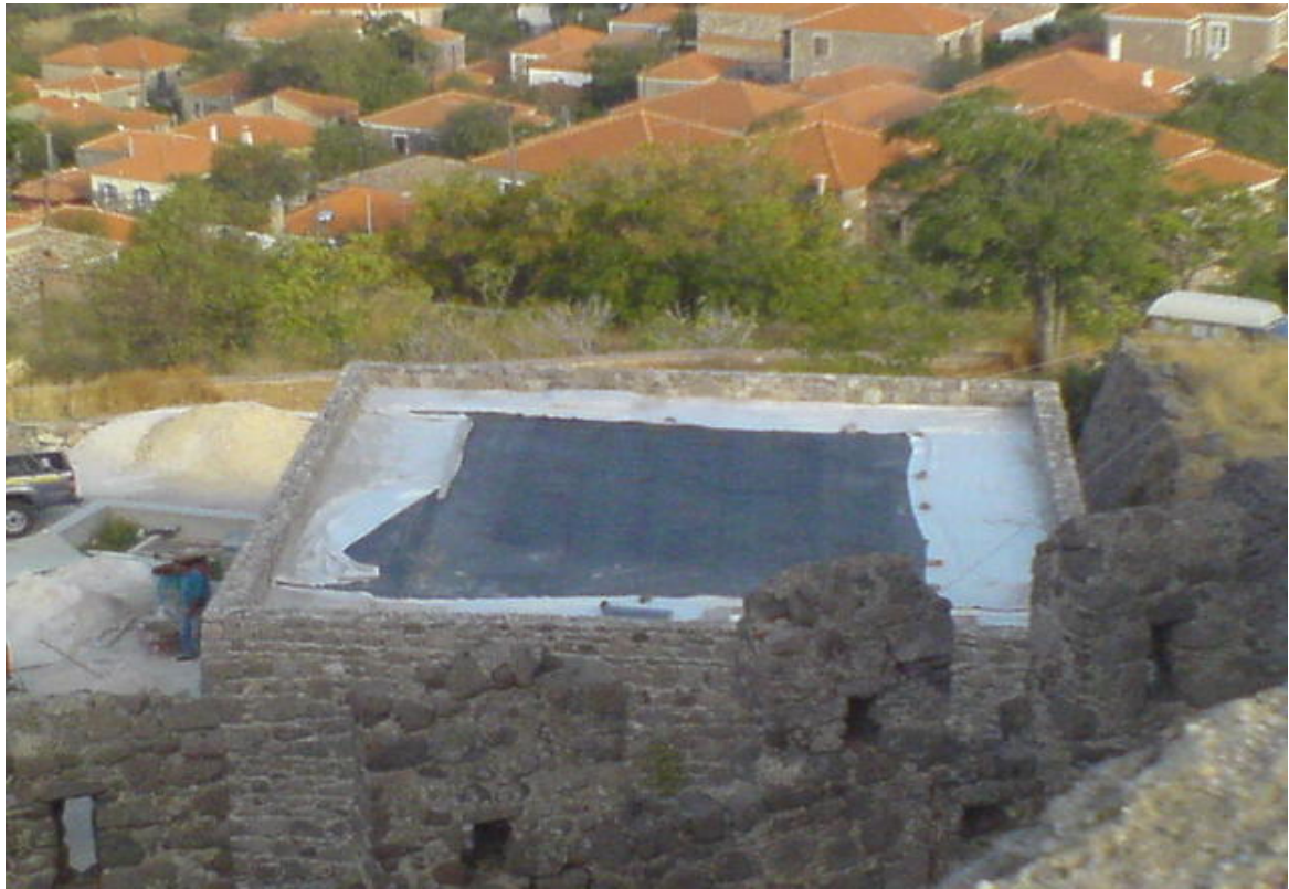
Μόνωση δώματος Αναψυκτηριου
