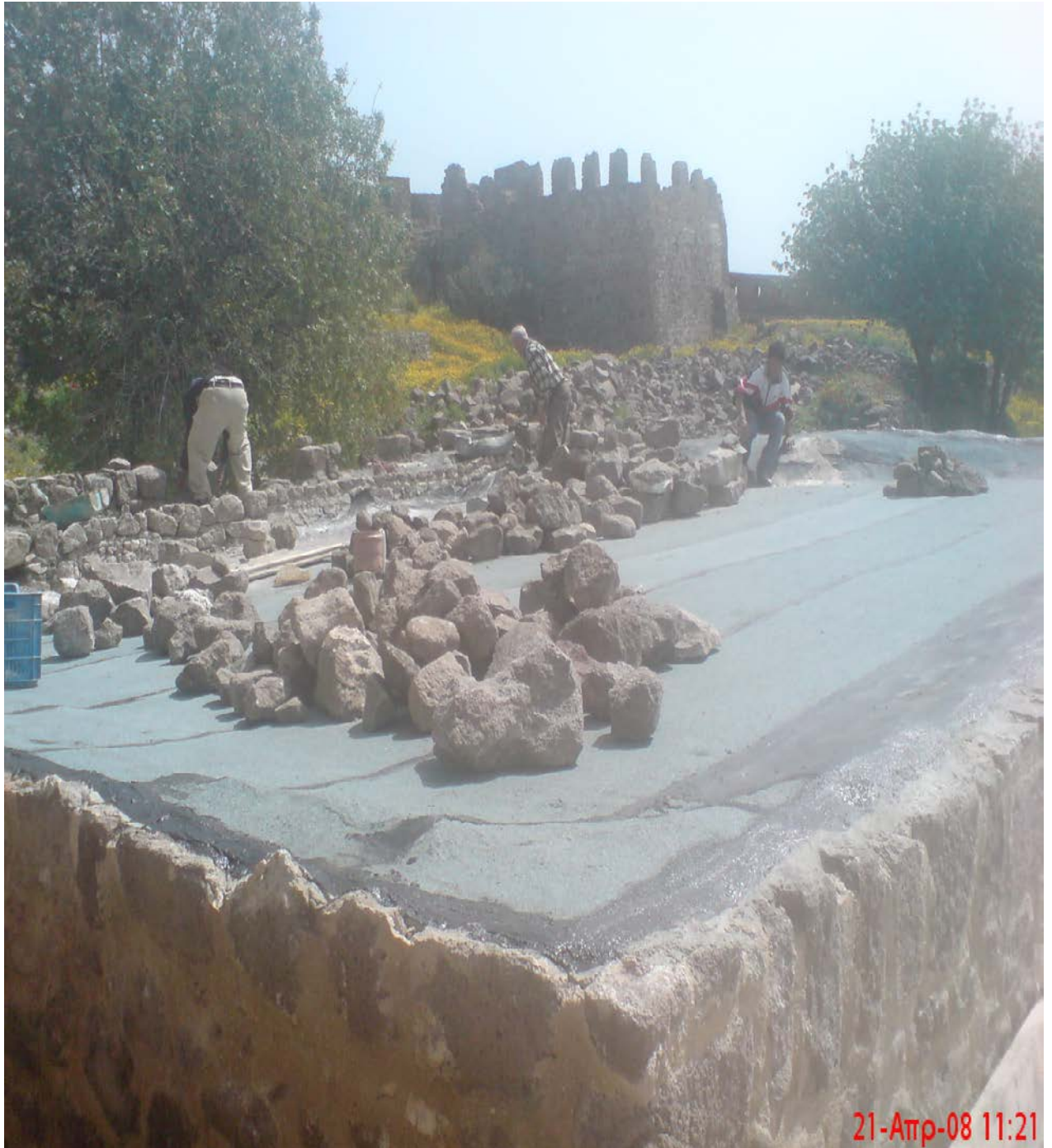
Μόνωση δώματος Εκθεσιακού χώρου με ασφαλτοπανο των 4kg/m 2 .
