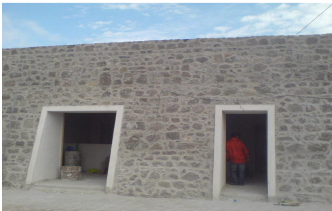
Ολοκλήρωση κορνιζων στις θυρες του Αναψυκτηριου
