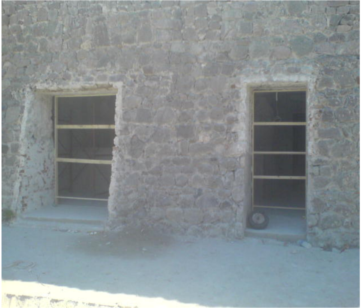
Τοποθέτηση ψευδοκασσας στο Αναψυκτηριο
