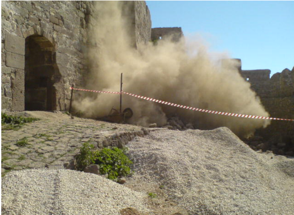
Απομακρυνση μπαζων εντος κάστρου Καθαιρεση υφισταμενης σκηνης
