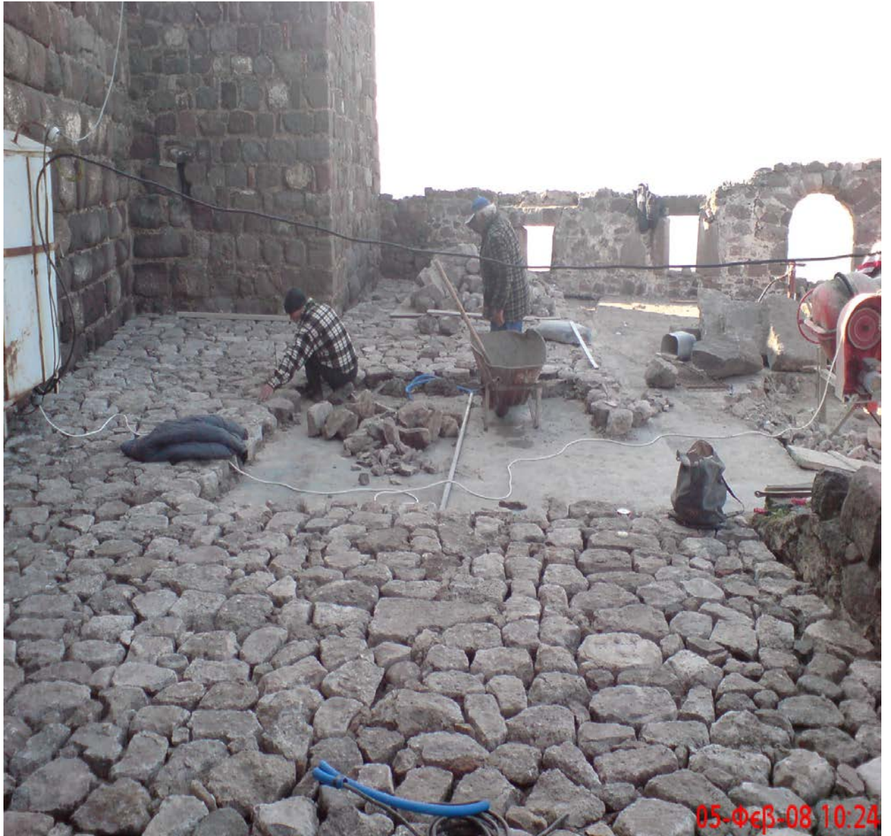
Λιθόστρωτο στο δώμα του Πωλητήριου
