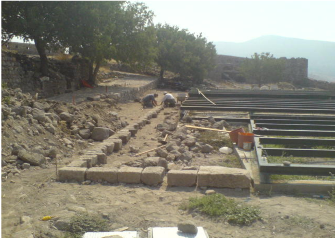
Κατασκευή λιθόστρωτου διαδρόμου κερκίδων
