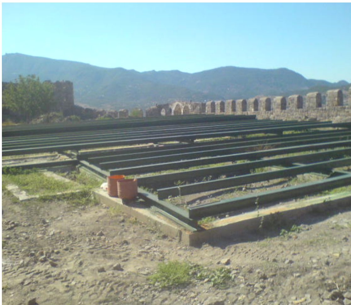
Μεταλλική κατασκευή κερκίδων και χρωματισμος με χρήση πιστολεττο με συνθετηκες ριτηνες
