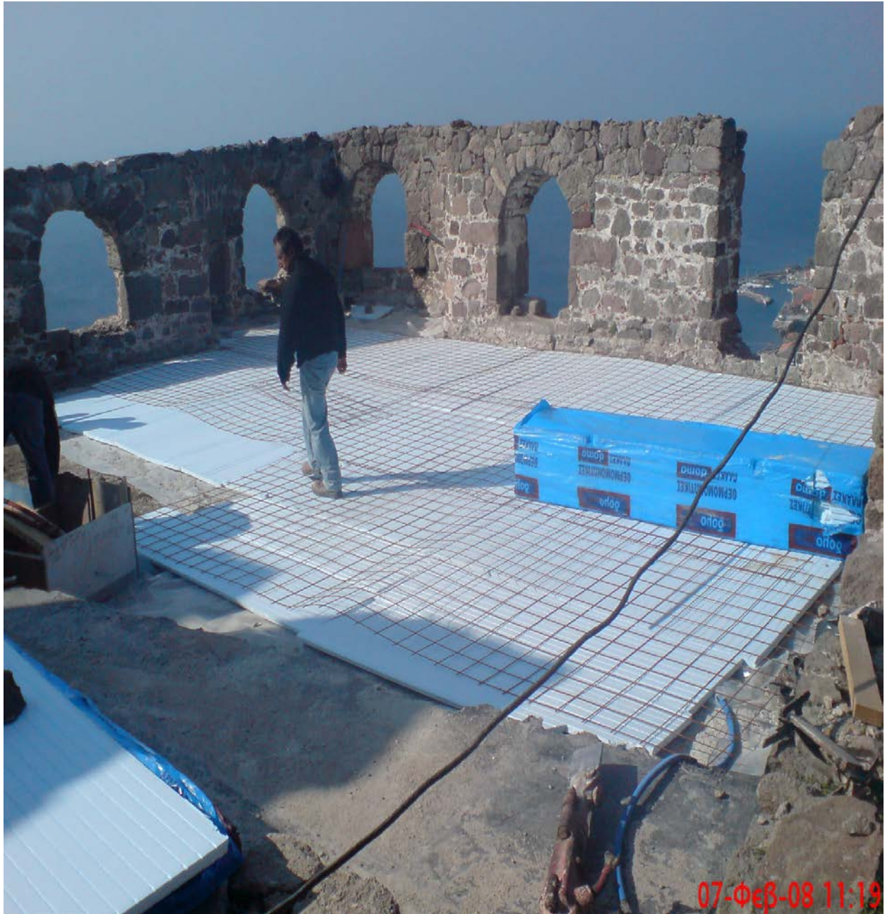
Μόνωση Πωλητηρίου με φράγμα υδρατμών-φύλλα πολυστερίνης-πλέγμα T191
