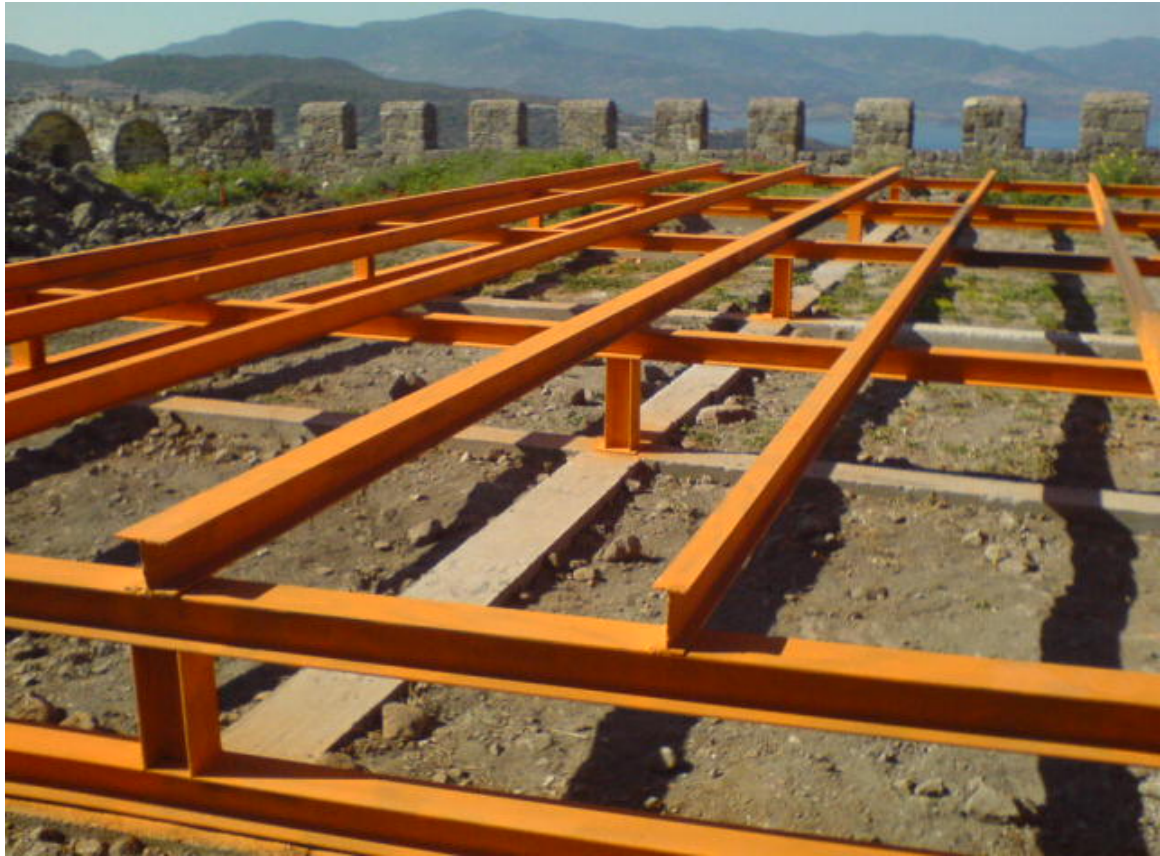
Σιδηροδοκοι διατομής ΗΕΒ 140 και ΙΡΕ 100 και προετοιμασια σιδηρων για τον τελικο χρωματισμο
