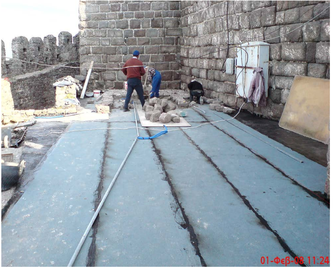
Μόνωση δώματος ΠΠ1 (Δώμα Πωλητηρίου-Αποθήκης)
