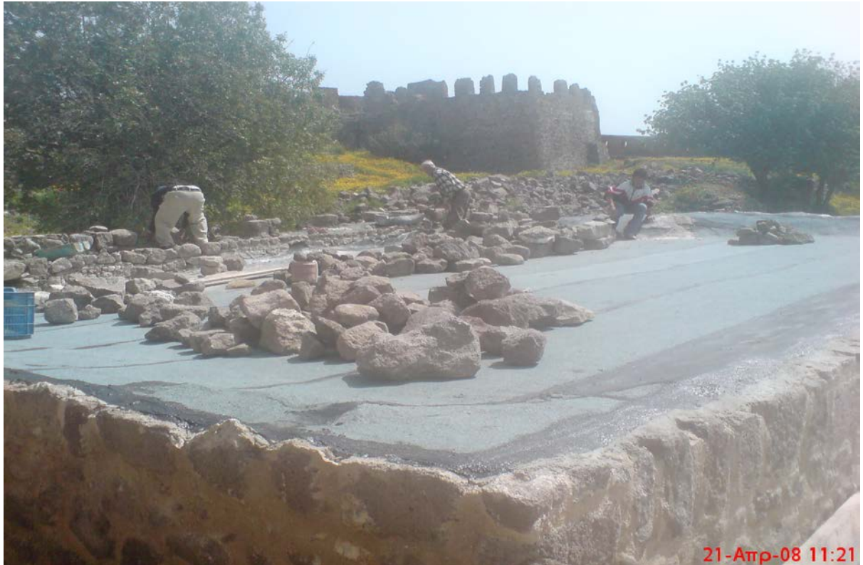
Κατασκευή ανώδομης στο κτίριο Κ 1
