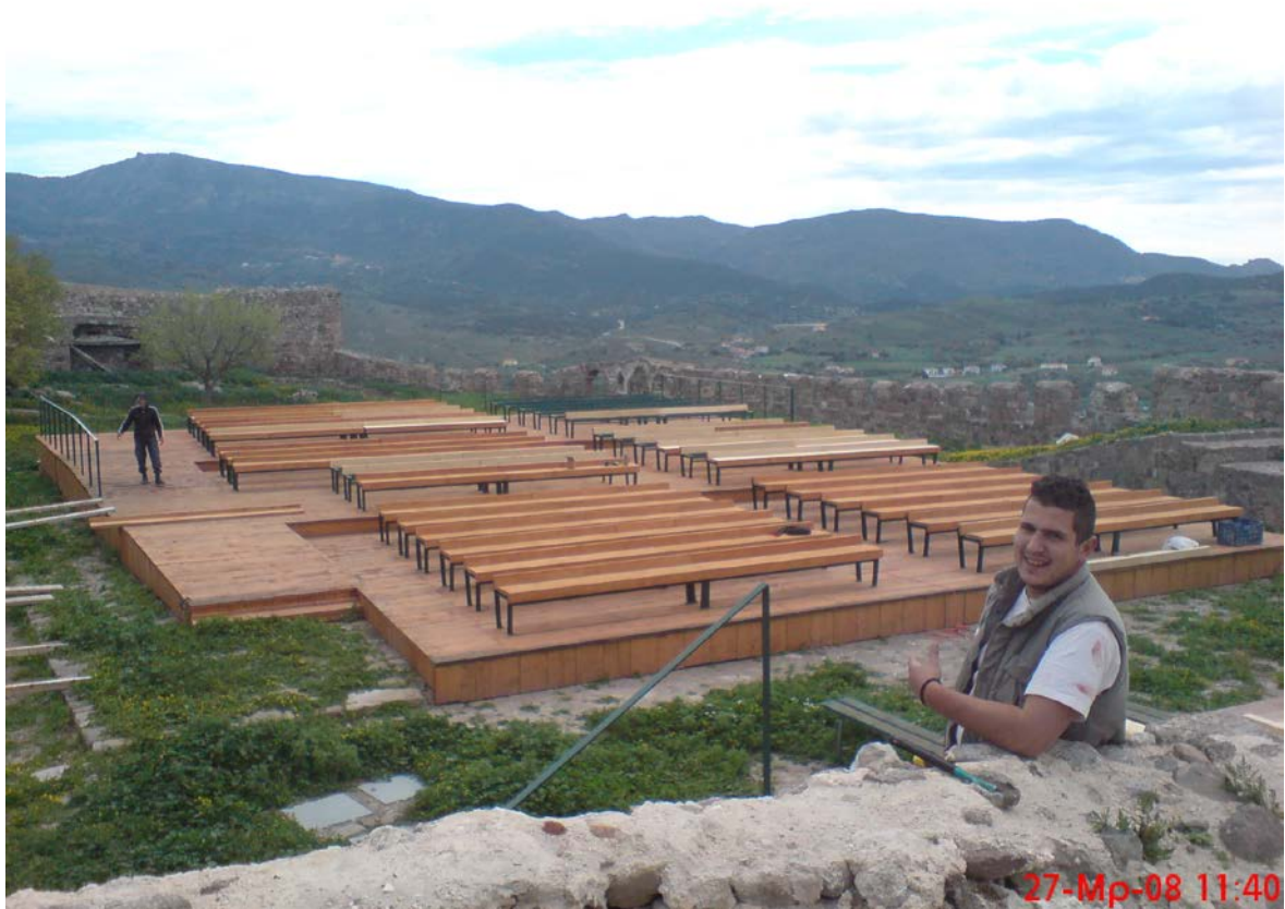
Τοποθέτηση ξυλινων καθισμάτων στις κερκίδες
