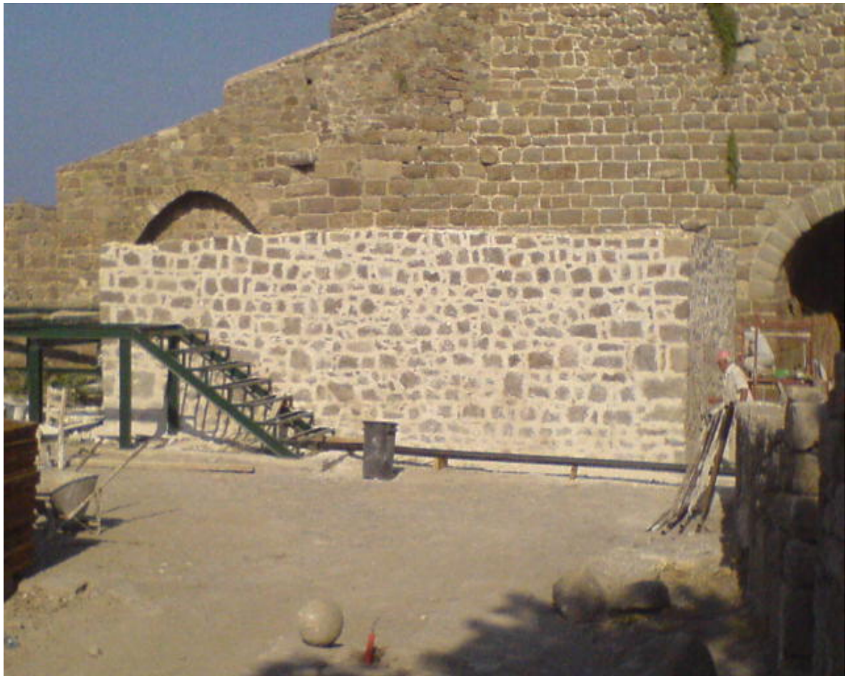
Τελικο αρμολογημα στο κτηριο Κ1 (Εκθεσιακός χώρος )
