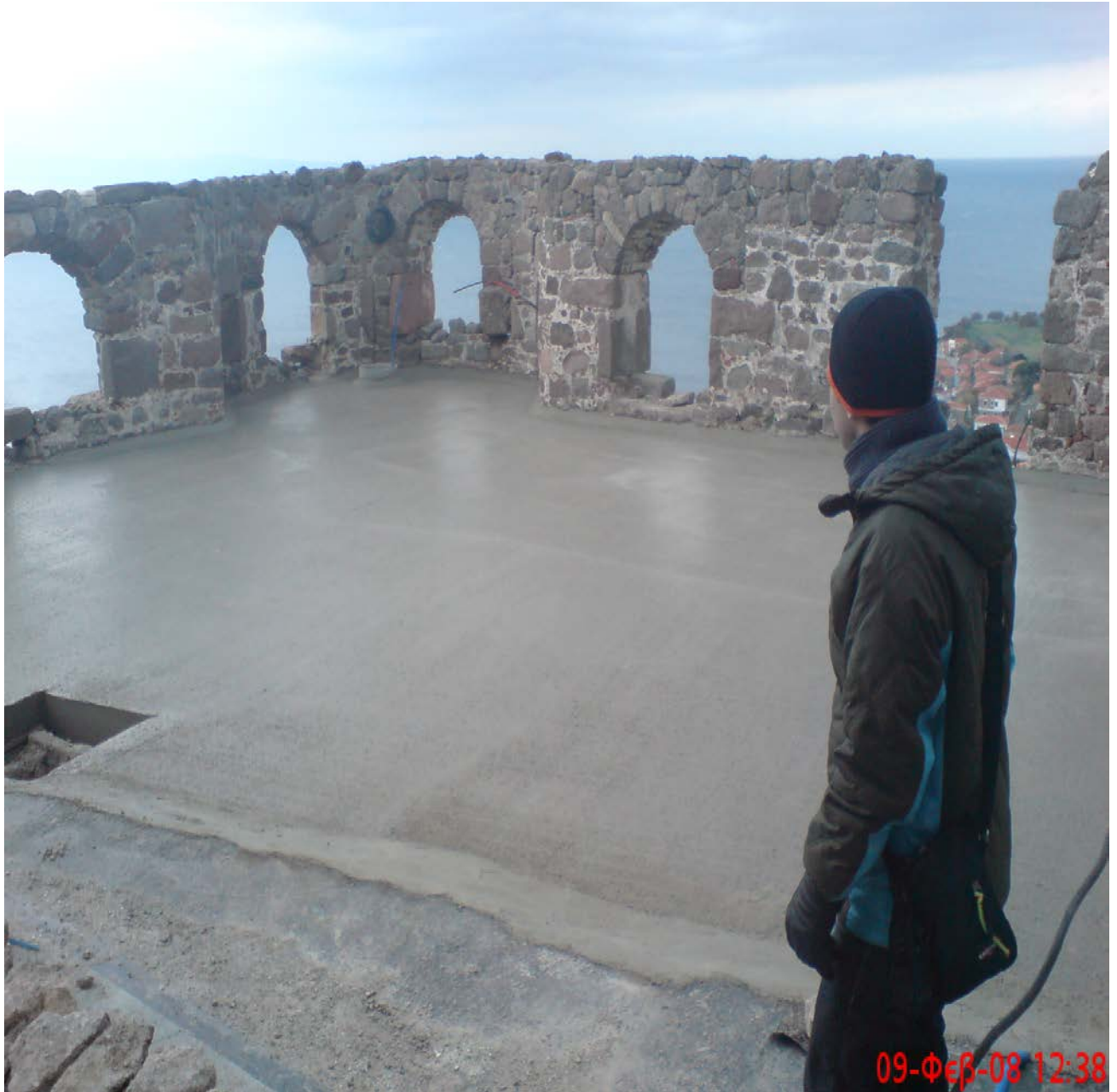
Περλιτοδεμα από ελαφρόπετρα για την στεγάνωση δώματος Πωλητηρίου-Αποθήκης
