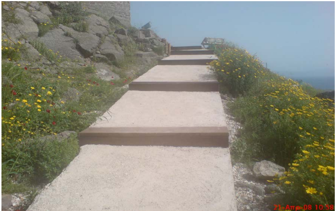
Βαθμιδες και διάδρομος από μίγμα γαρμπιλιου-χωματος και λευκού τσιμεντου
