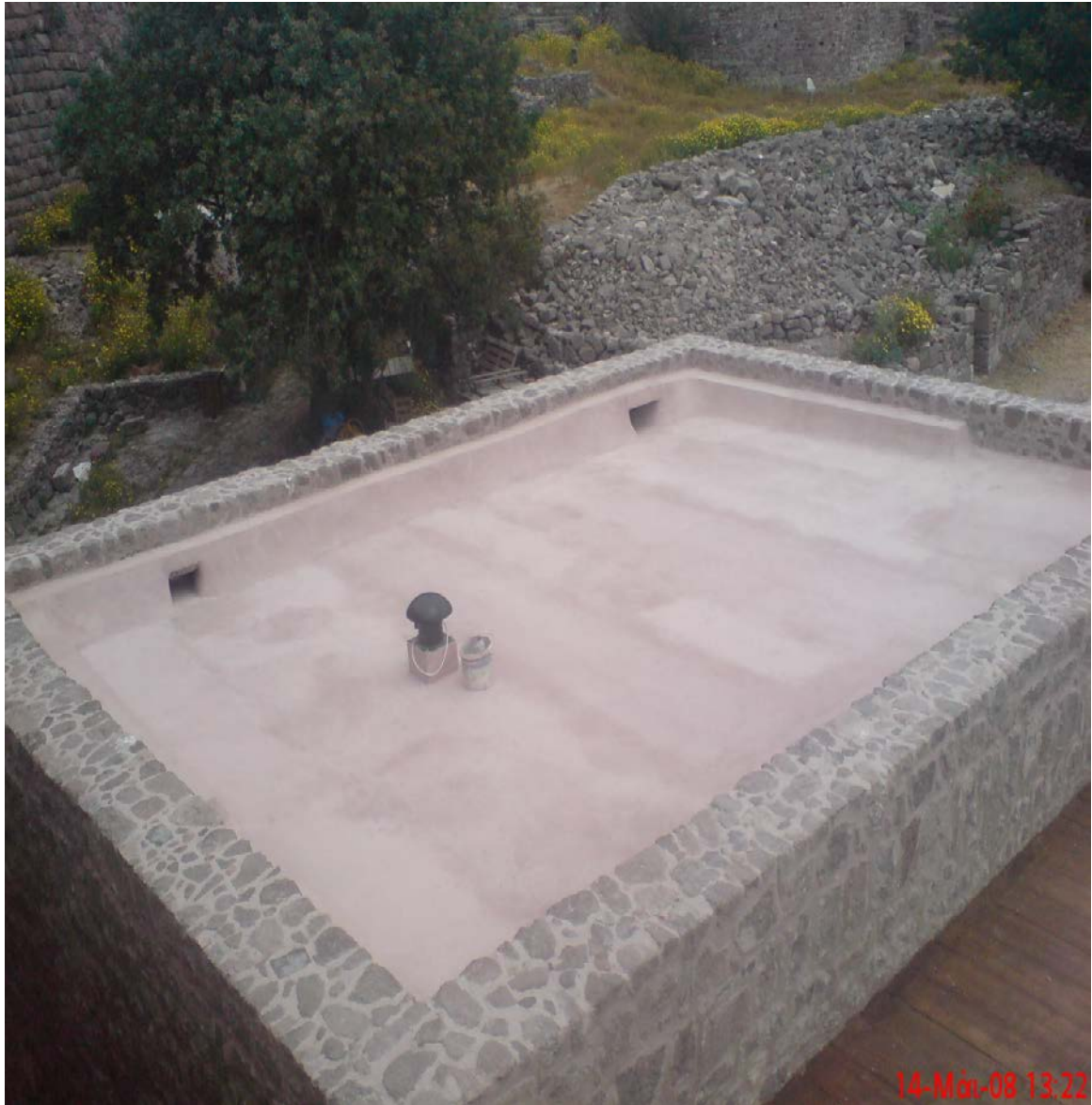
Τελική μορφή δώματος Εκθεσιακου χώρου με τσιμεντοκονιαμα
