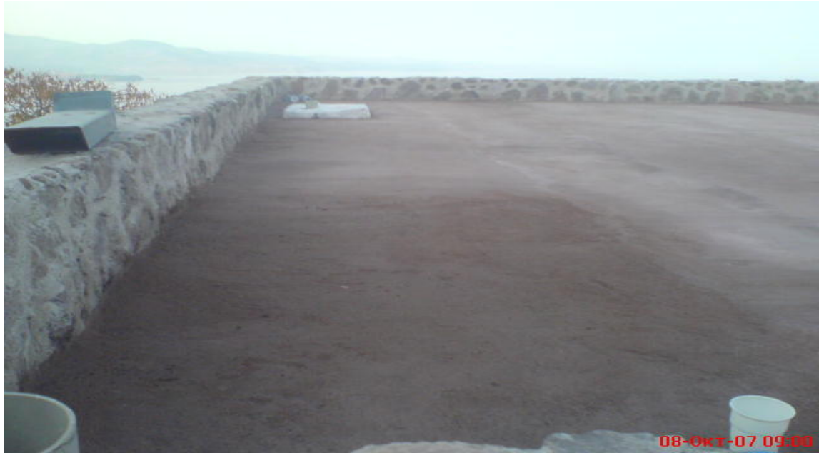
Ολοκλήρωση ανωδομης και τελικη στρωση τσιμεντοκονιαματος στο Αναψυκτηριο
