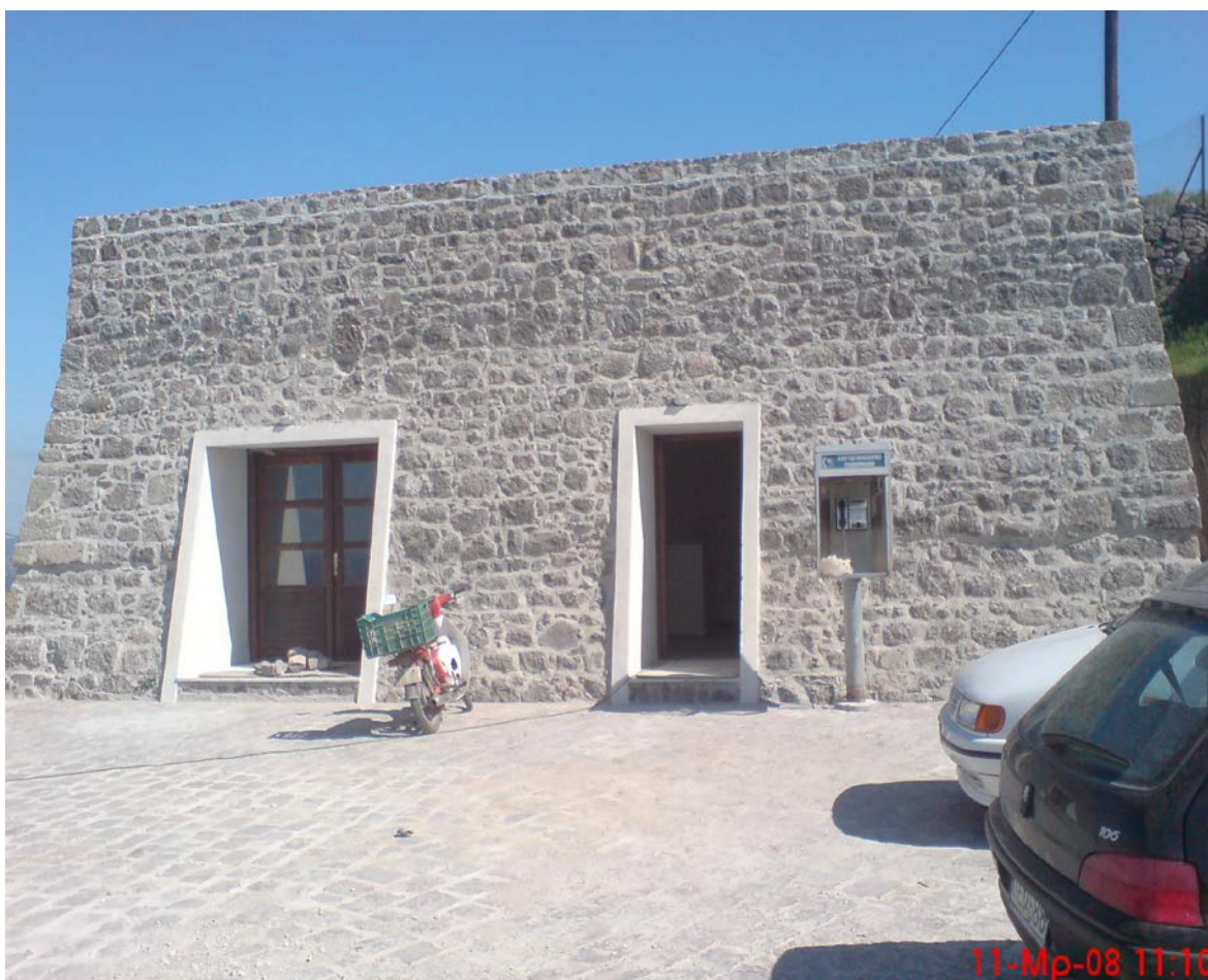
Τοποθέτηση θυρων από ξυλεία ορεγκον παιν
