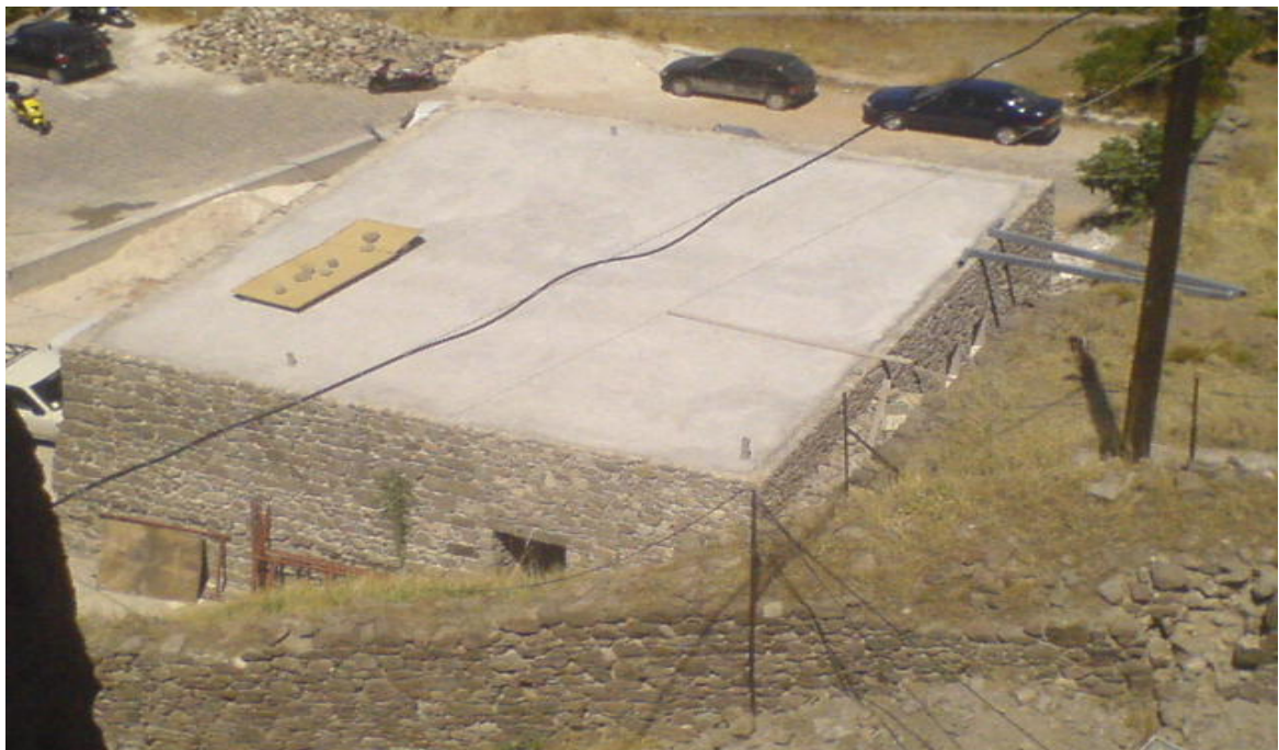
Ολοκλήρωση τσιμεντοκονιαματος στο Αναψυκτηριο
