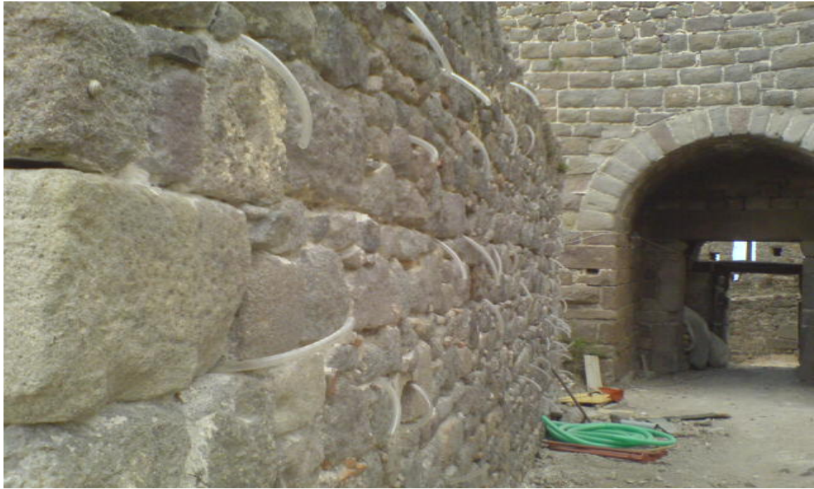
Τοποθέτηση σωληνίσκων στο Κ 1 για την ρηψει ενεματος και της ενησχυσεις του κτιρίου
