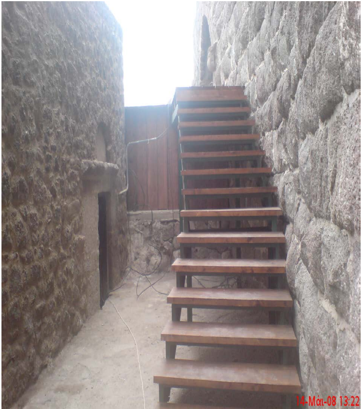
Μεταλλική σκάλα εισόδου σκηνής
