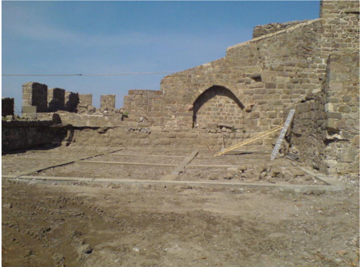
Λωρίδες από οπλισμεμο σ/δ για την τοποθέτηση της μεταλλικής σκηνής
