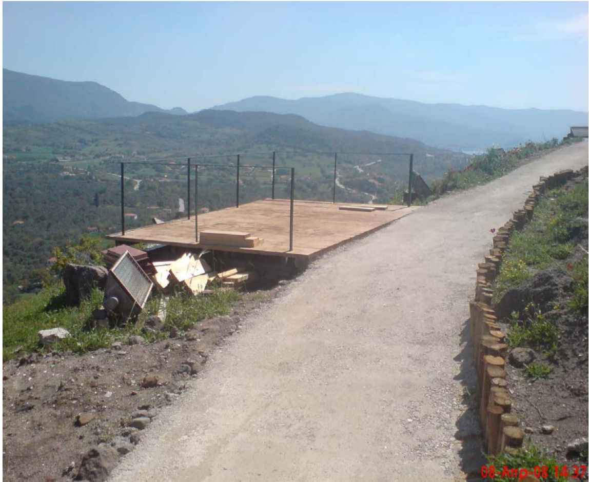
Μεταλλική πλατφόρμα και επένδυση με ξυλεία Ρωσίας
