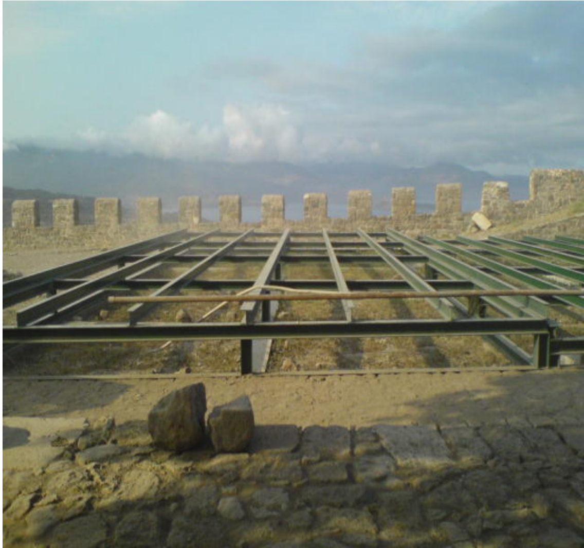
Μεταλλική κατασκευή κερκίδων και κατασκευή λιθόστρωτου διαδρομou
