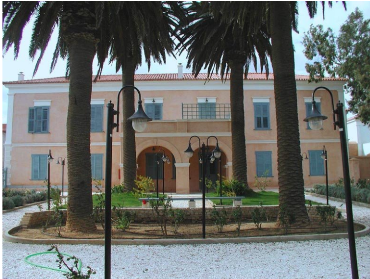
Εικόνα Β.12:Βίλλα Σερπιέρη (εκτός)
