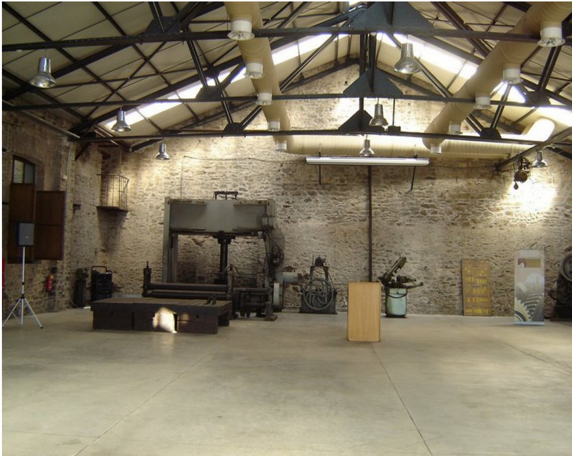
Εικόνα Β.9: Το εσωτερικό του Μηχανουργείου 1
