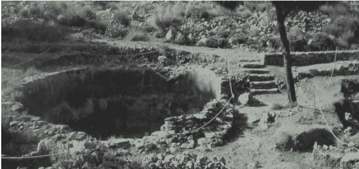
Εικόνα Α.21: Δεξαμενή νερού. (Φαίνεται το υδραυλικό κονίαμα)
