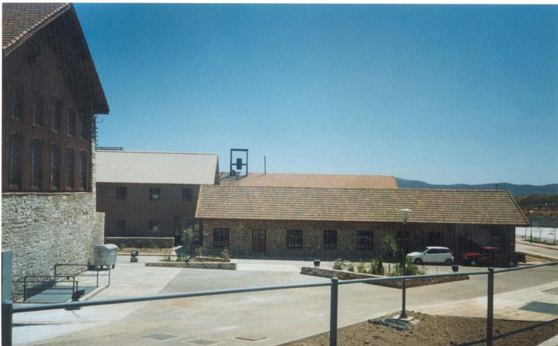
Εικόνα Β.11: Κτίρια που έχουν υποστεί εργασίες αποκατάστασης
