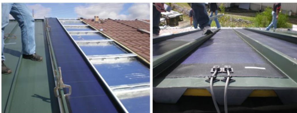
Κατασκευή πειραματικής οροφής (PCN-PV Tennessee USA)[20]
