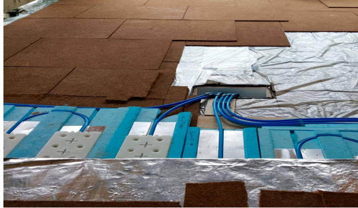
Ενδοδαπέδιο ηλεκτρικό πάτωμα με PCM[31]
