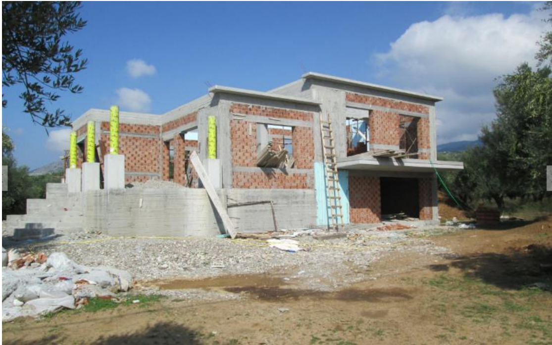
Εικόνα 1 Το κτίσμα όπου εξετάζεται στην παρούσα εργασία
