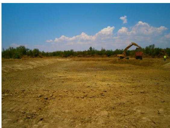
Εκσκαφή Δευτερεύουσας Υδατοσυλλογής 2 (ΔΥ2)
