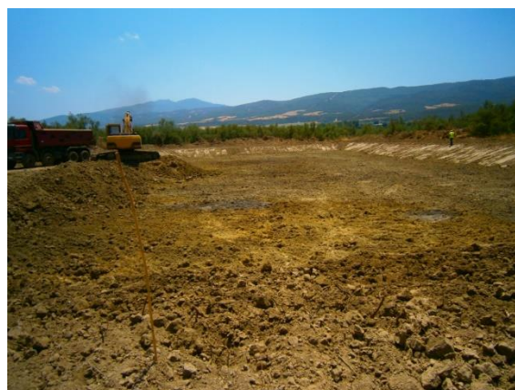
Εκσκαφή Δευτερεύουσας Υδατοσυλλογής 1 (ΔΥ1)
