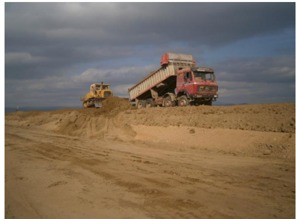
Κατασκευή προσωρινών αναχωμάτων
