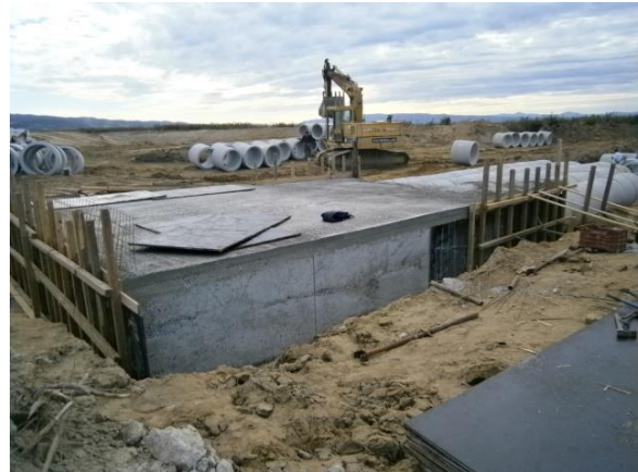
Κατασκευή προσωρινών εκκενωτών
