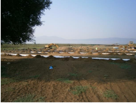
Κατασκευή στραγγιστηρίων
