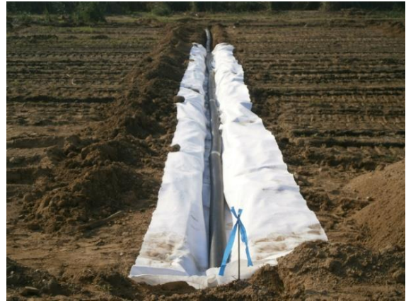
Κατασκευή στραγγιστηρίων
