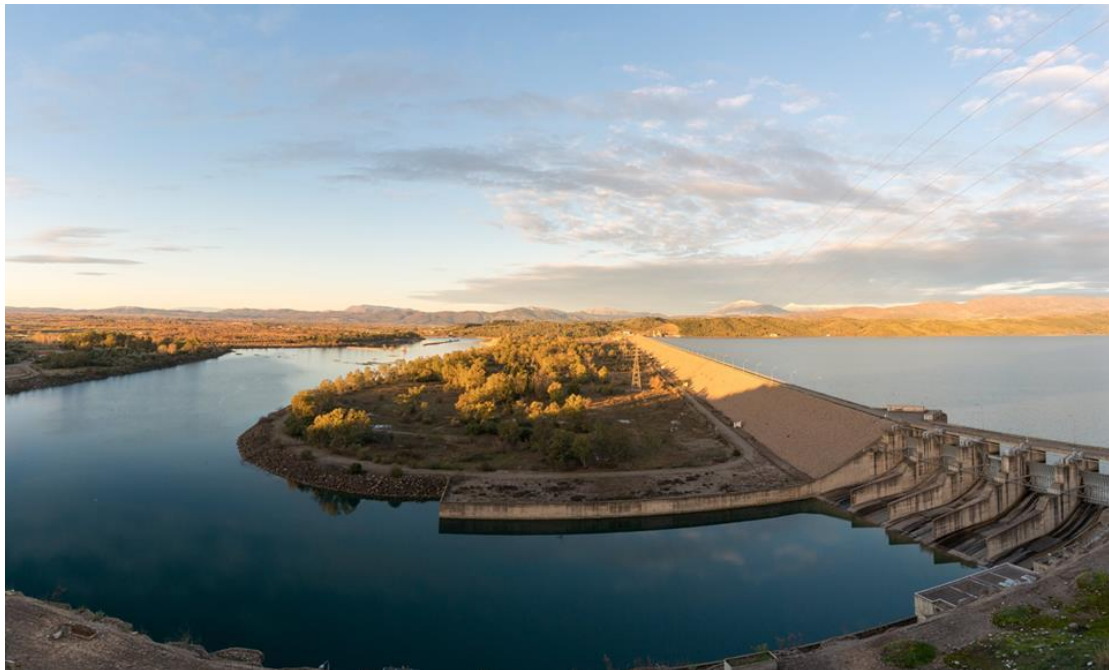
40 Το φράγμα του Καστρακίου, Πηγή φωτογραφίας © Καπνιάς Ανδρέας
