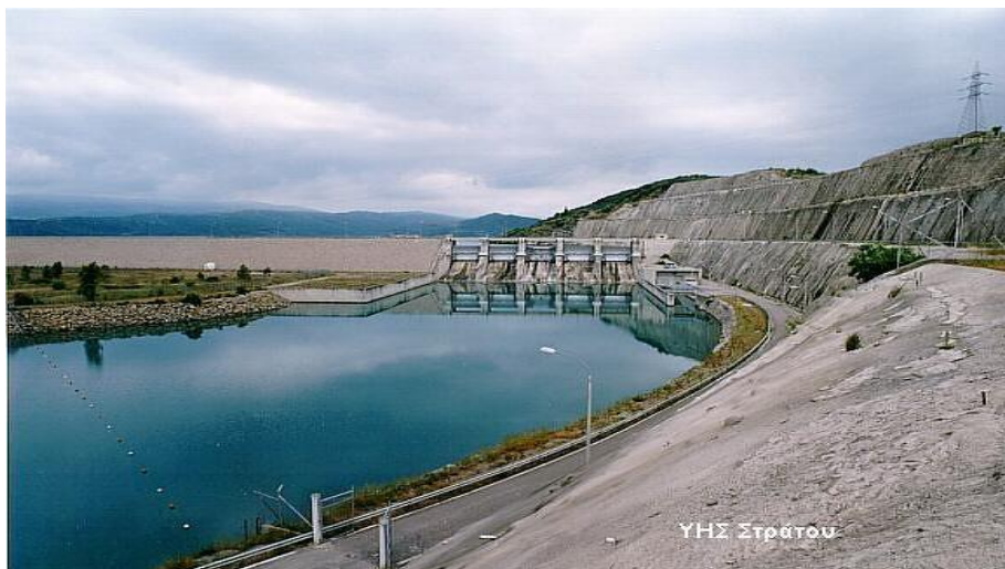
43.Υδροηλεκτρικό φράγμα Καστρακίου πηγή φωτογραφίας Καπνιάς Ανδρέας
