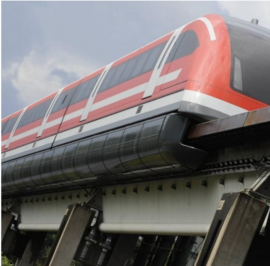
Εικόνα 34. Η τεχνολογία Transrapid χαρακτηρίζεται από την μικρή της απόσταση μεταξύ τρένου και σιδηροτροχιάς, με αποτέλεσμα τον αυξημένο κίνδυνο ύπαρξης ατυχήματος
