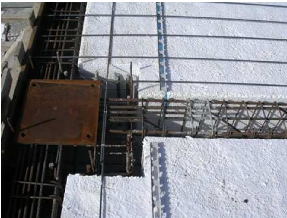
Εικόνα 48 Οπλισμός πεδילוδοκών και θερμομονωτικές πλάκες
