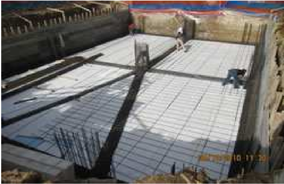
Εικόνα 47 Πανοραμική όψη μόνωσης θεμελίωσης με θερμομονωτικές πλάκες
