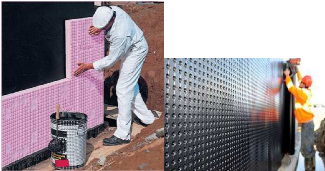
Εικόνα 52 συγκόλληση θερμομονωτικών πλακών
