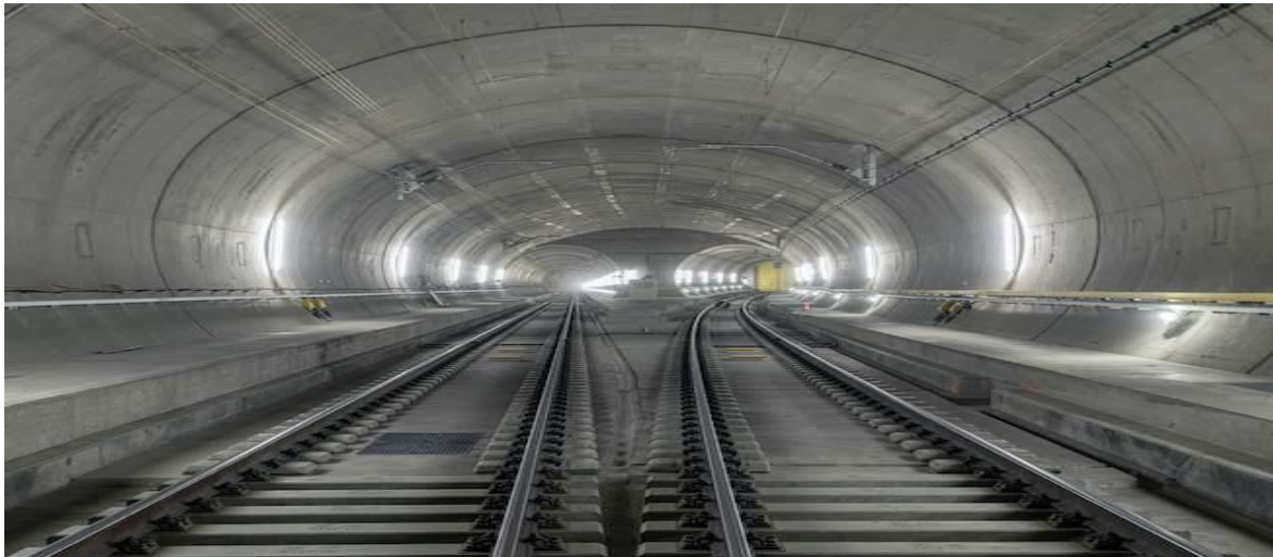
Εικόνα 3.2: Σήραγγα Τράπεζας: 2,7χλμ-Μονή σήραγγα διπλής κατεύθυνσης στο τμήμα Κιάτο-Αίγιο-Ολοκληρωμένη κατασκευή-Προβλεπόμενη λειτουργία 2017
