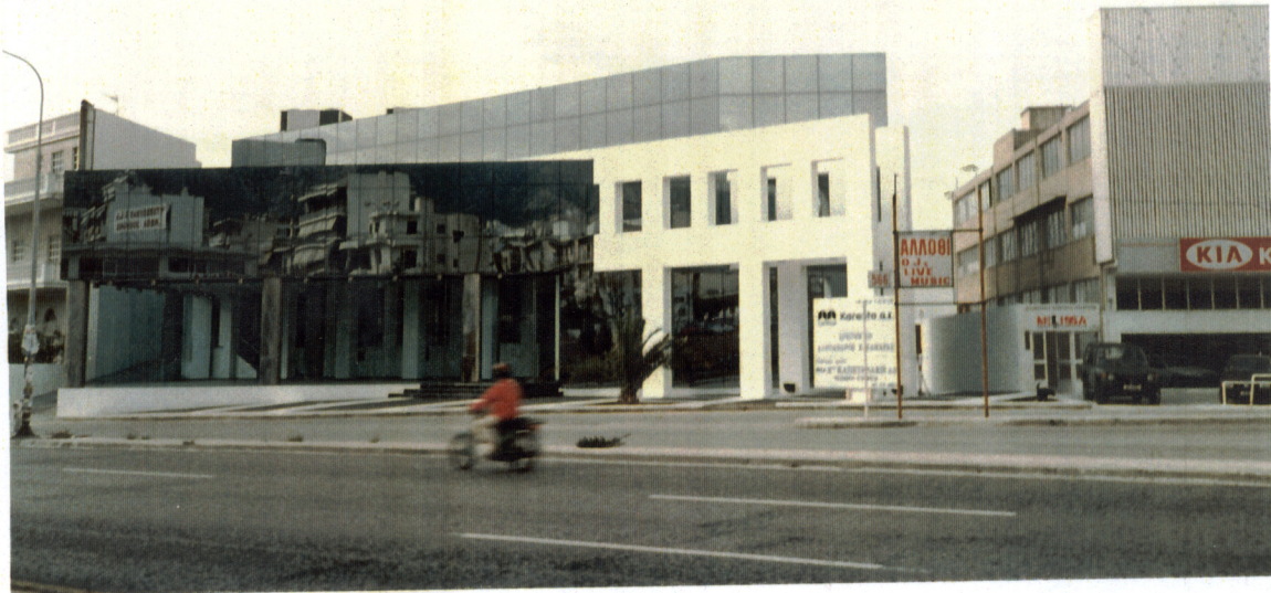
κτίριο Λεωφ. Βουλιαγμένης. Στοιχείο κατασκευής του κτιρίου: γυαλί, μέταλλο. Μη ύπαρξη συμμετρίας
