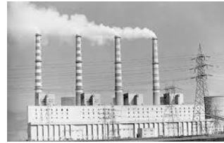
Σταθμός Παραγωγής Ενέργειας
