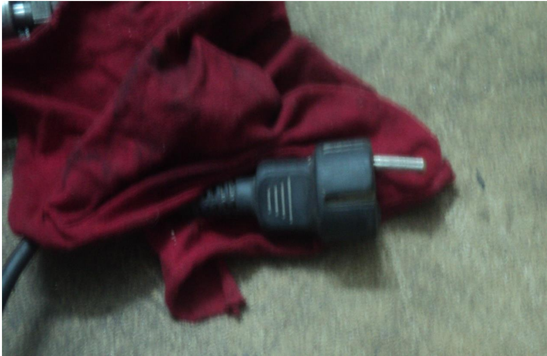
Εικόνα 4 Οπτική επιθεώρηση του καλωδίου και του ακροδέκτη
