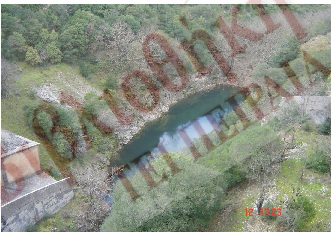
Η κοίτη του Λάδωνα αμέσως μετά το φράγμα, με εμφανές το αποτέλεσμα διαρροών.
