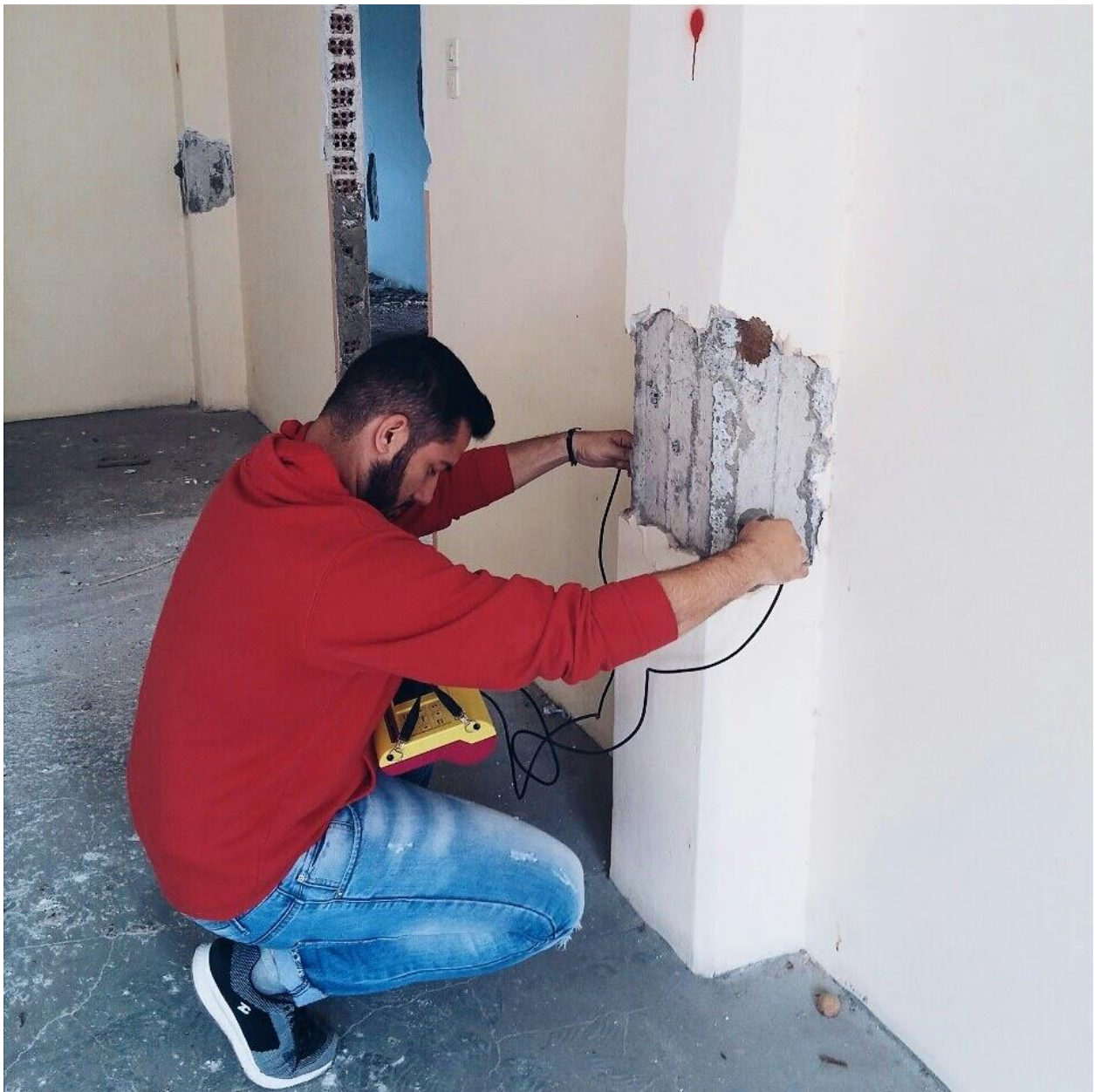
Εικόνα 4.10: Φωτογραφία μέτρησης ταχύτητας υπερήχων σε υποστώλωμα του β ορόφου
