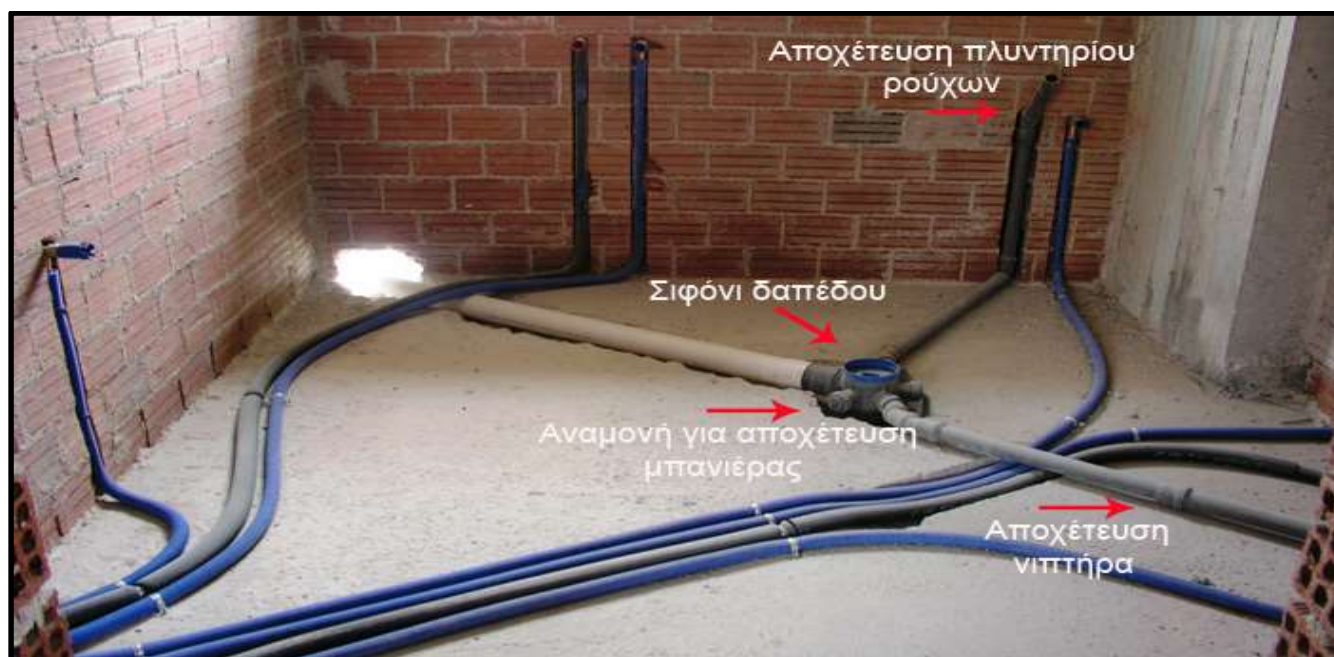
Απεικόνιση υδραυλικών σωληνώσεων μπάνιου
