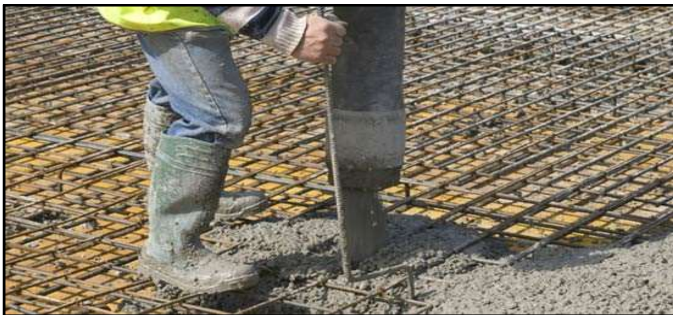
Έγχυση σκυροδέματος σε πλάκα μέσω πρέσας Πηγή φωτογραφίας: http://www.kontosmek.gr/
