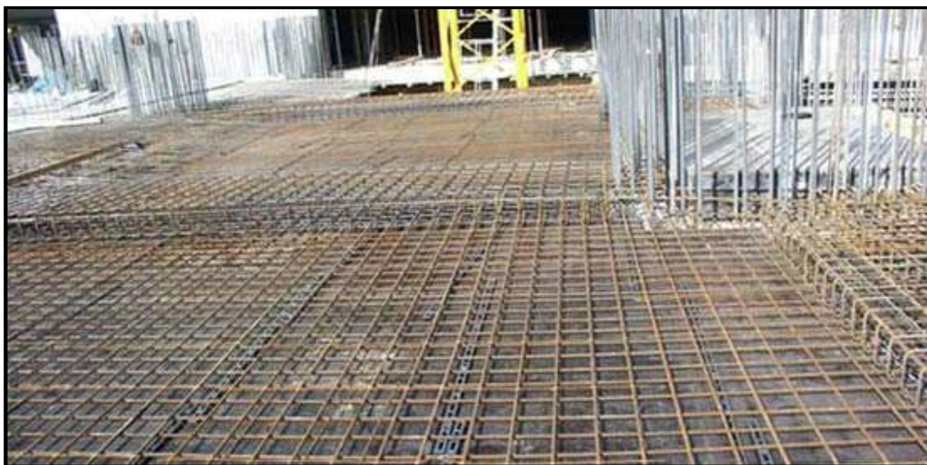
Τοποθέτηση σιδηρού σπλισμού σε πλάκα Πηγή φωτογραφίας: http://www.kontosmek.gr/
