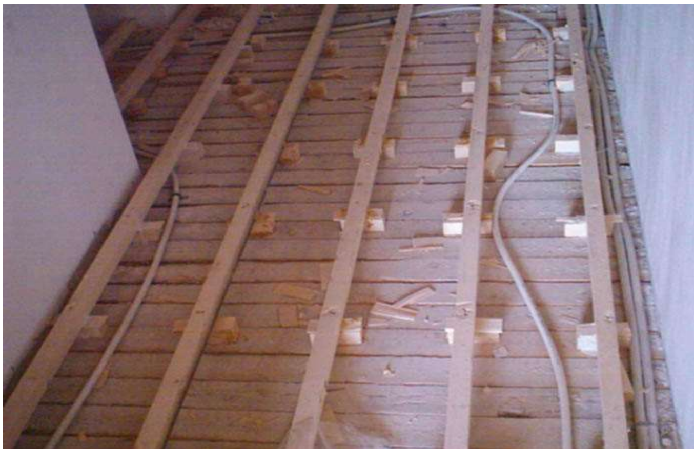
Κατασκευή ξύλινου δαπέδου.
