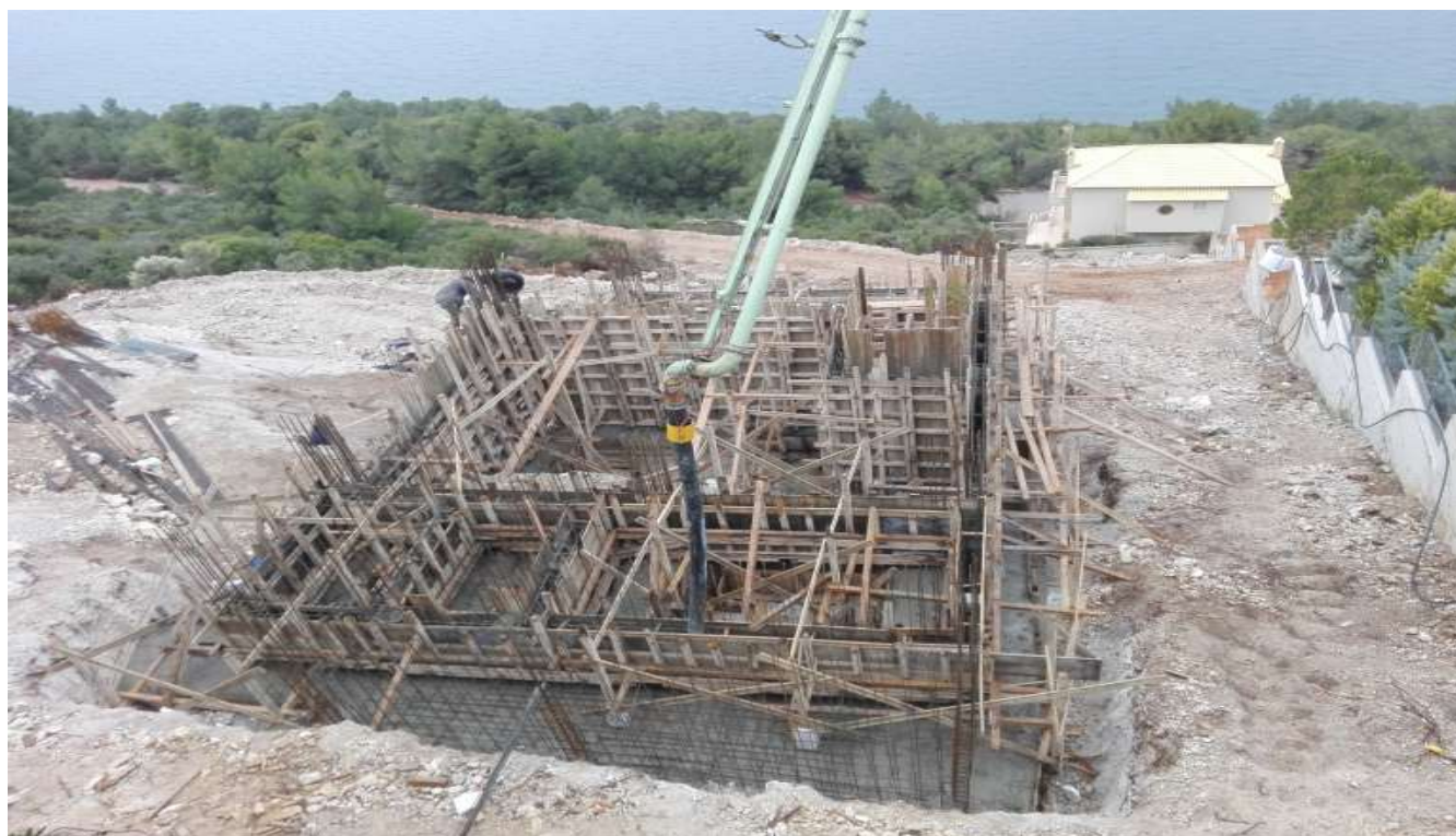
Σκυροδέτηση θεμελίωσης.
