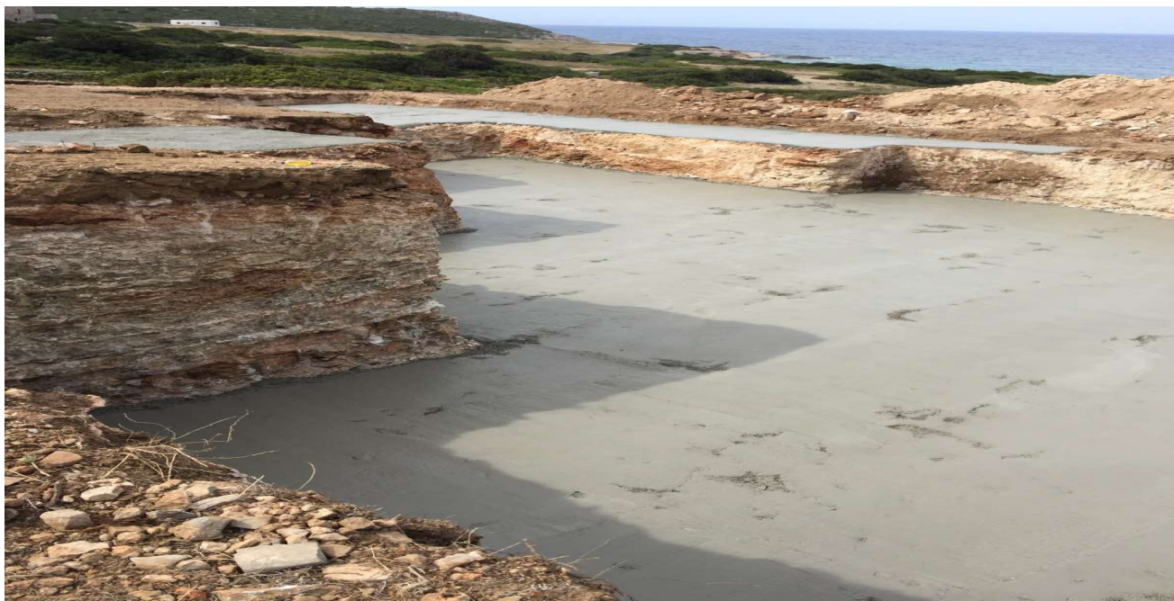
Διάστρωση σκυροδέματος καθαριότητας.
