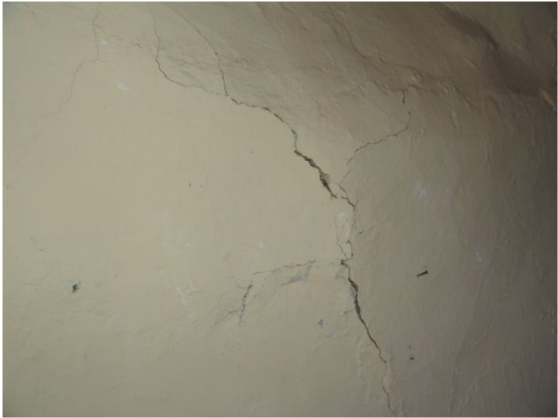
Φ101. Αποσύνθεση τοιχοποιίας από αοπτοπλινθοδομή (στο πλατύσκαλο προς τον όροφο).
