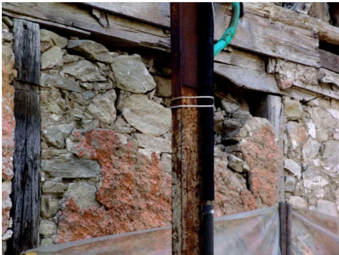
Φ47. Λιθοδομή στο ισόγειο και ξύλινοι ορθοστάτες.
