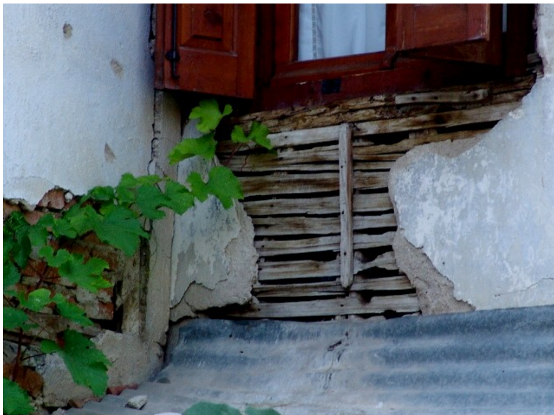
Φ49. Ξύλινη κατασκευή στον όροφο.
