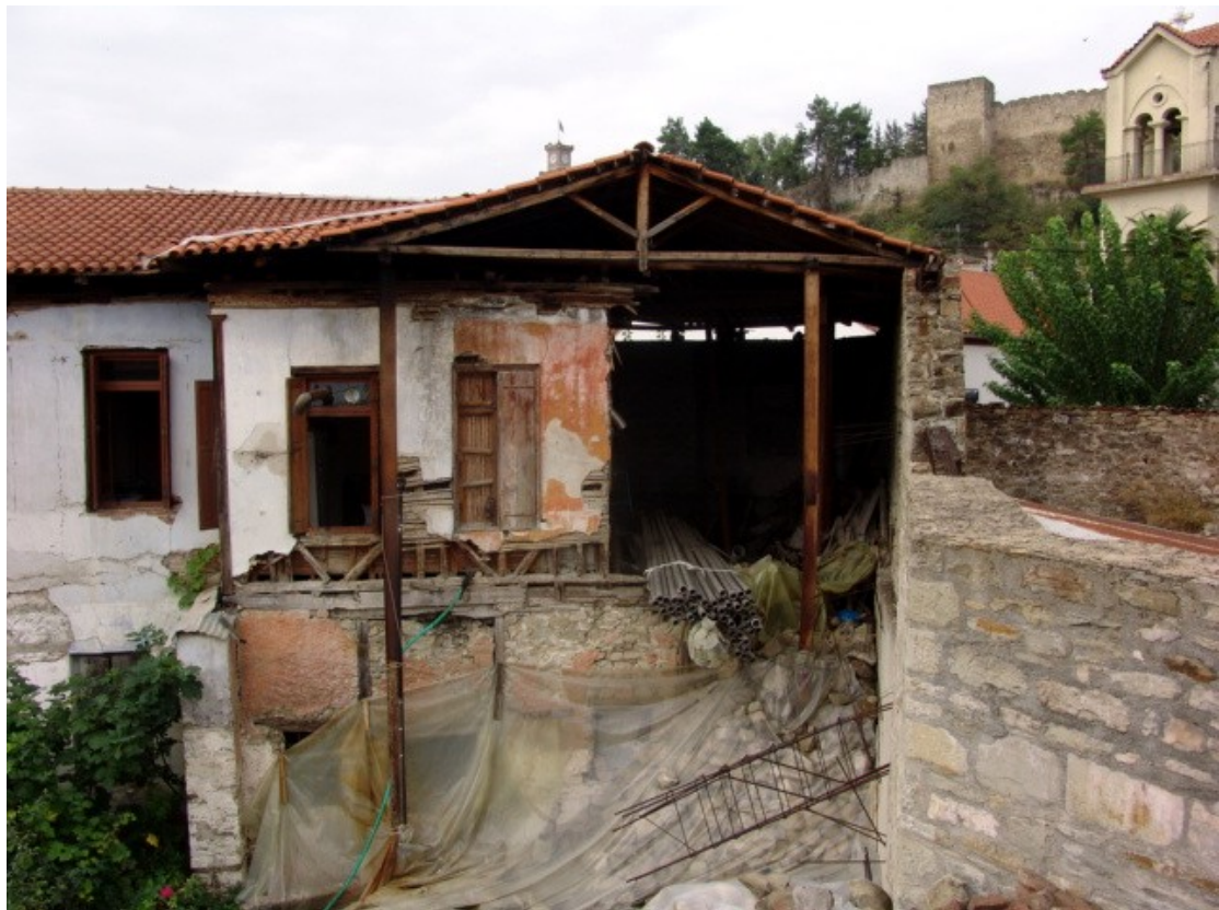
Φ42. Λιθοδομή στον μανδρότοιχο και το ισόγειο –ξύλινη κατασκευή στον όροφο - στέγη.
