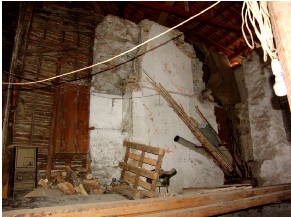
Φ52. Συνδυασμός ξύλινης κατασκευής και λιθοδομής στον οστά για το τζάκι..
