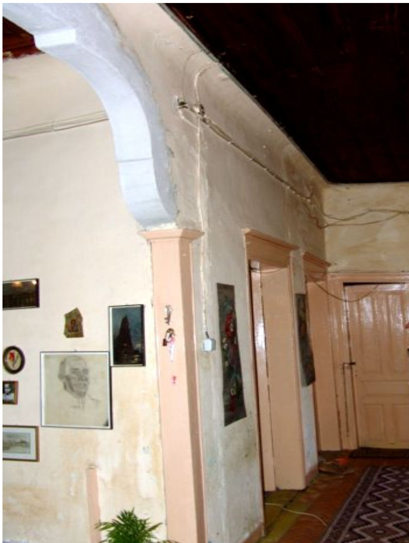
Φ27. Εσωτερική λεπτομέρεια ορόφου (όπου και η αγίδα στην απόληξη της εσωτερικής κλίμακας).
