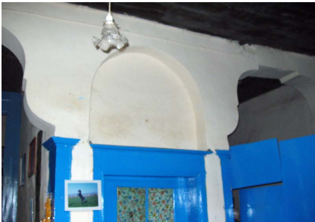
Φ21. Η σύνθεση των δυο ανοικτών αψιδωμάτων με το κεντρικό κλειστό στο ισόγειο.
