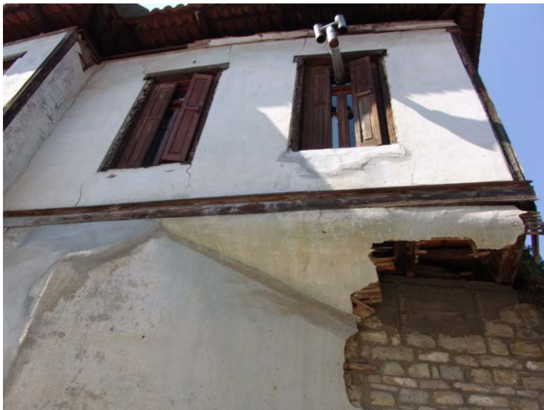
Φ12. Μανδρότοιχος επί της Παύλου Μελά, σύνδεση με τον φέροντα οργανισμό της κατοικίας και το δάπεδο ορόφου.
