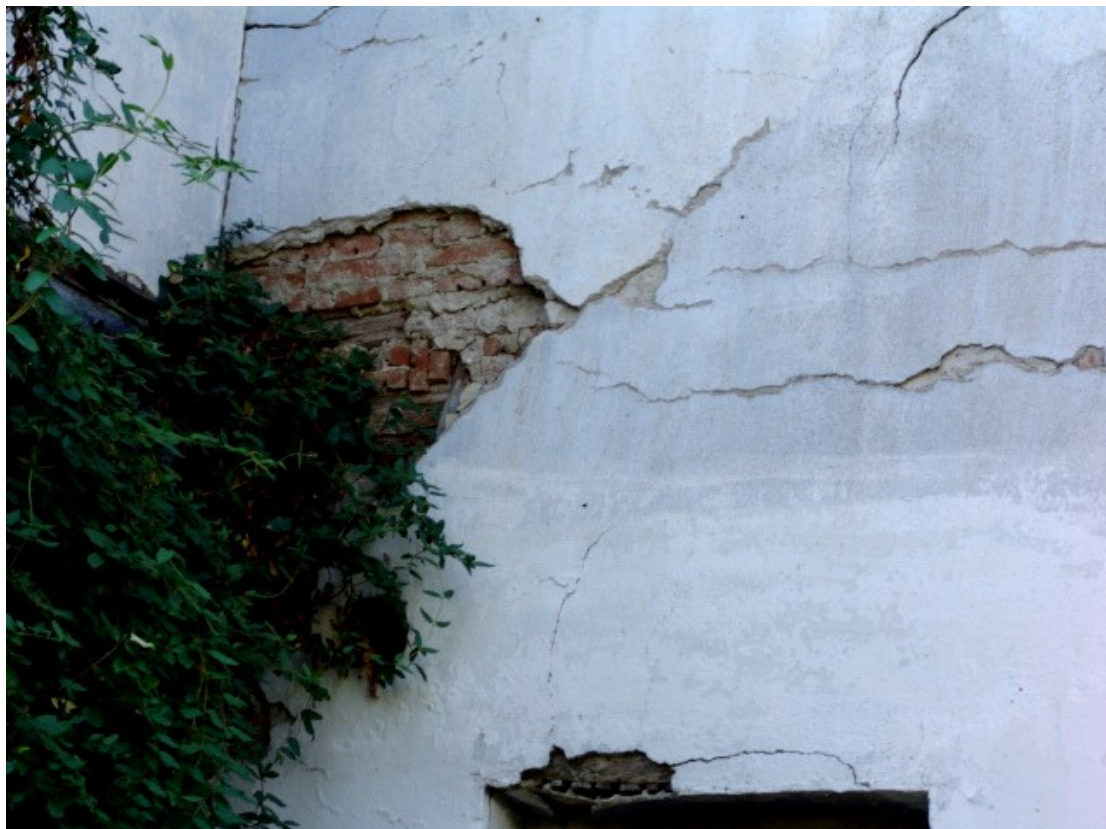
Φ77. Λεπτομέρεια αποκόλλησης της ξυλόπηκτης τοιχοποιίας στον όροφο από την οπτοπλινθοδομή στην ένωσή τους.
