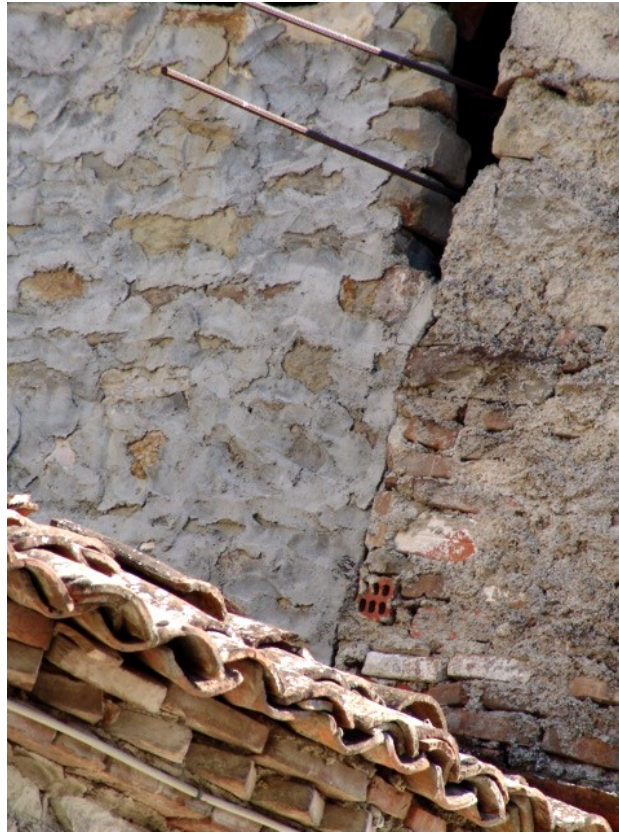
Φ85. Λεπτομέρεια λιθοδομής στον όροφο.
