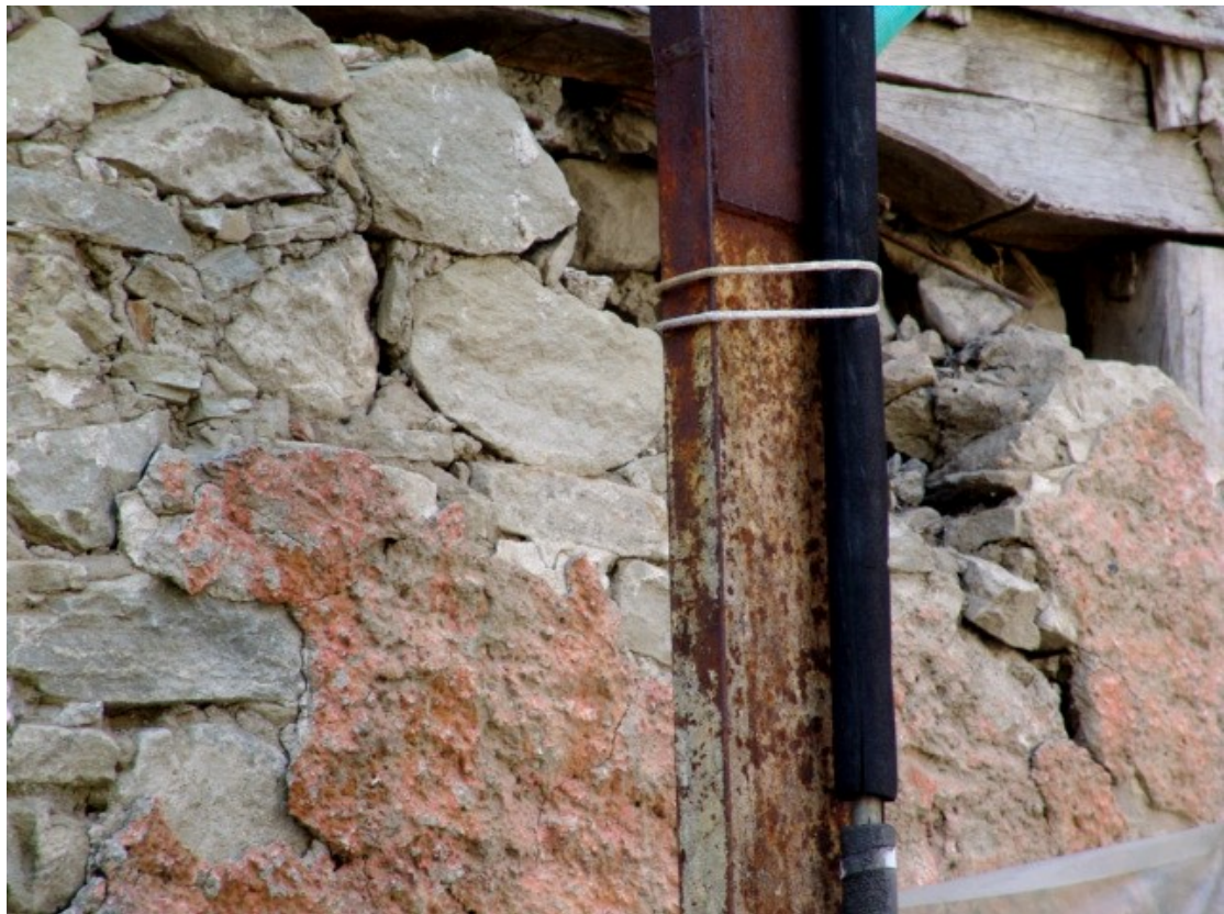
Φ68. Λεπτομέρεια στη λιθοδομή του ισόγειου. Αποδιοργάνωση και κατάρρευση της τοιχοποιίας (ενσωματωμένοι ξύλινοι ορθοστάτες).
