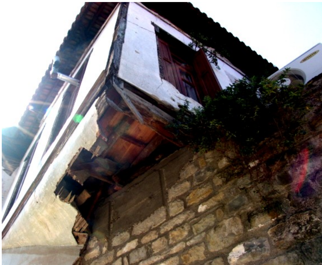
Φ40. Λιθοδομή στον μανδρότοιχο και ξύλινη κατασκευή στον όροφο (δάπεδο, τοιχοποιία).
