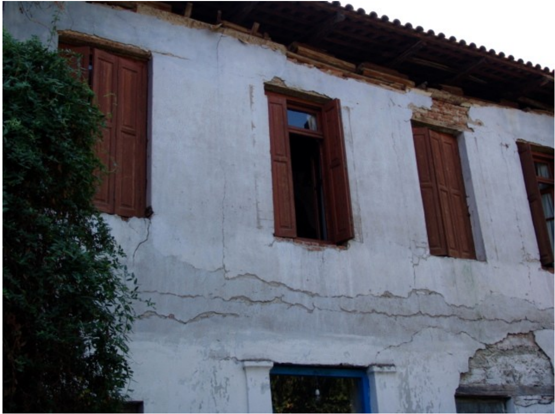
Φ74. Αποδιοργάνωση στο επίπεδο του δαπέδου ορόφου.
