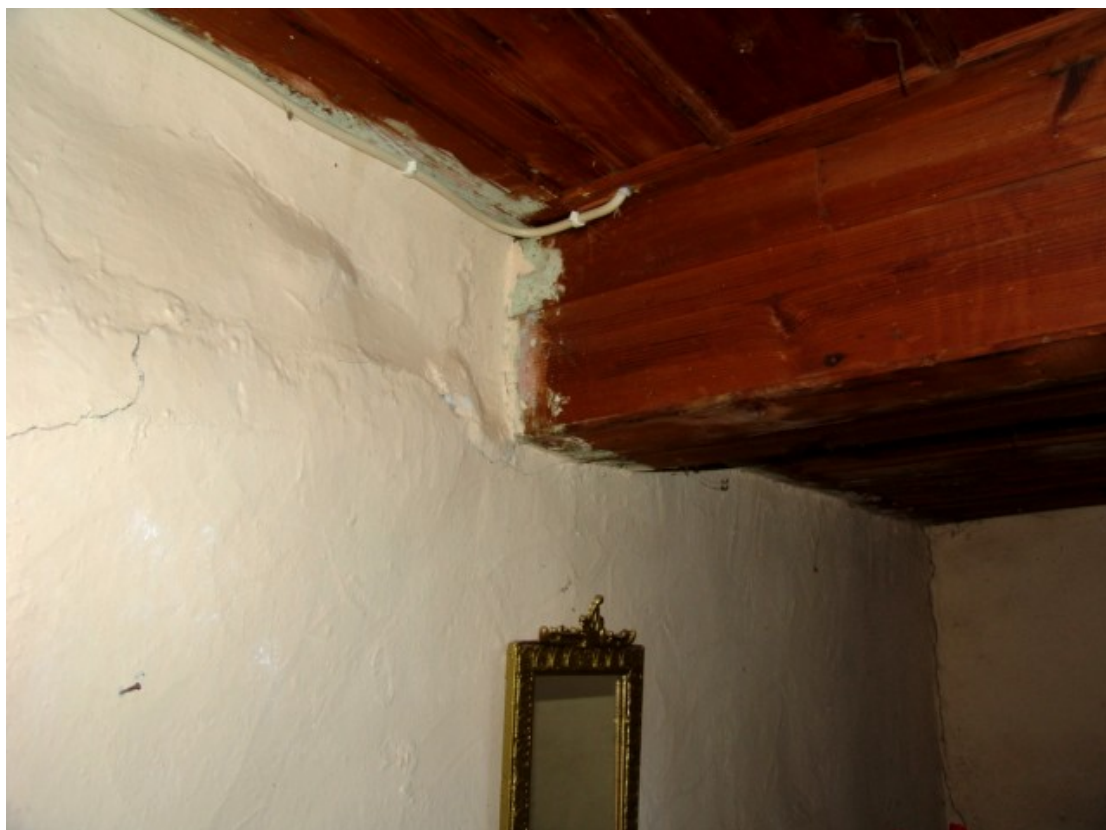
Φ34. Εσωτερική κατασκευαστική λεπτομέρεια (ταβάνι), στην αλλαγή κατεύθυνσης της εσωτερικής κλίμακας από το ισόγειο στον όροφο, στο πλατύσκαλο.
