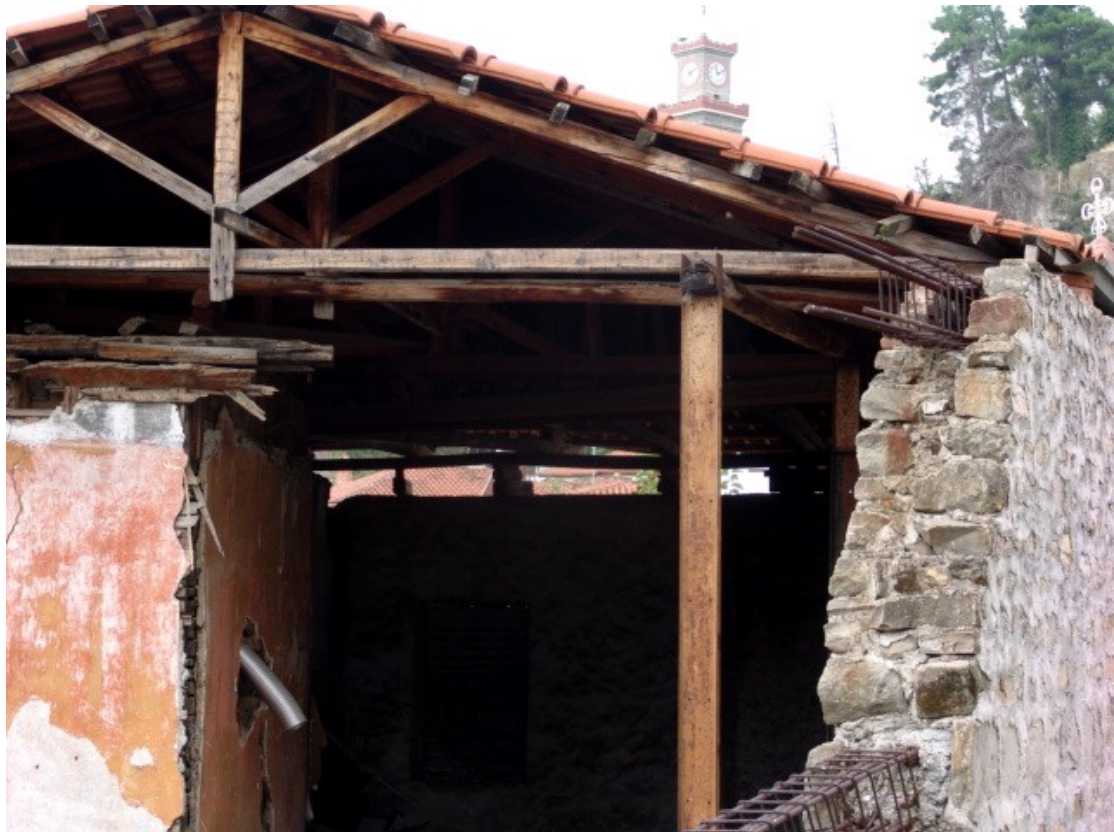
Φ45. Λιθοδομή-ξύλινη κατασκευή στον όροφο-στέγη.
