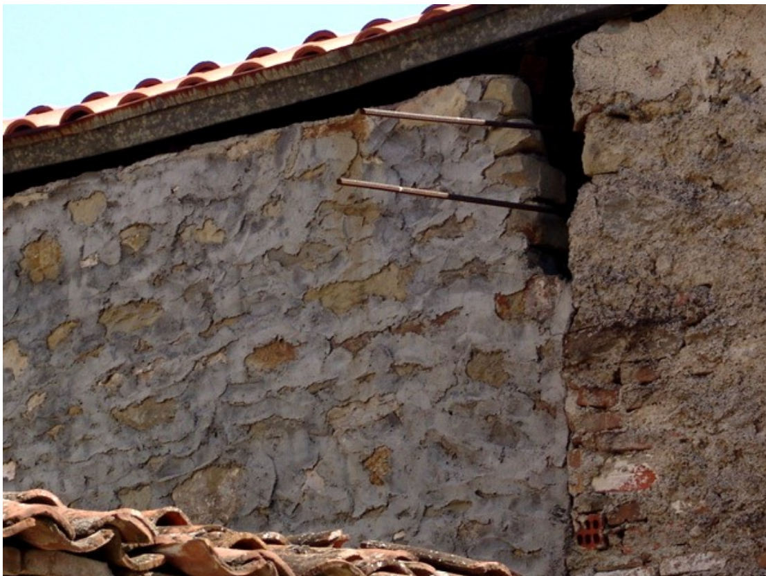
Φ84. Λεπτομέρεια λιθοδομής στο όριο με ιδιοκτησία Σιμή.
