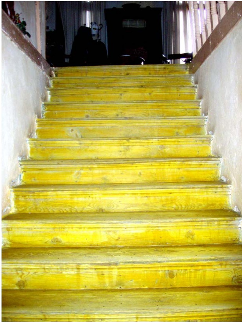
Φ22. Εσωτερική ξύλινη κλίμακα προς όροφο.
