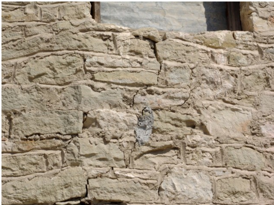
Φ91. Ρηγμάτωση στη λιθοδομή (πάνω από το πρέκι)
