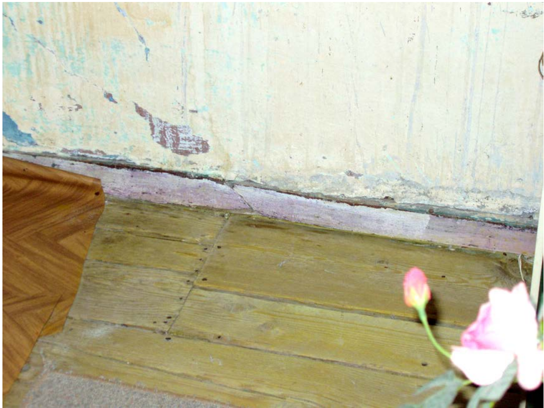
Φ29. Λεπτομέρεια ξύλινου δαπέδου, ( τμήματα ισογείου και όροφος).
