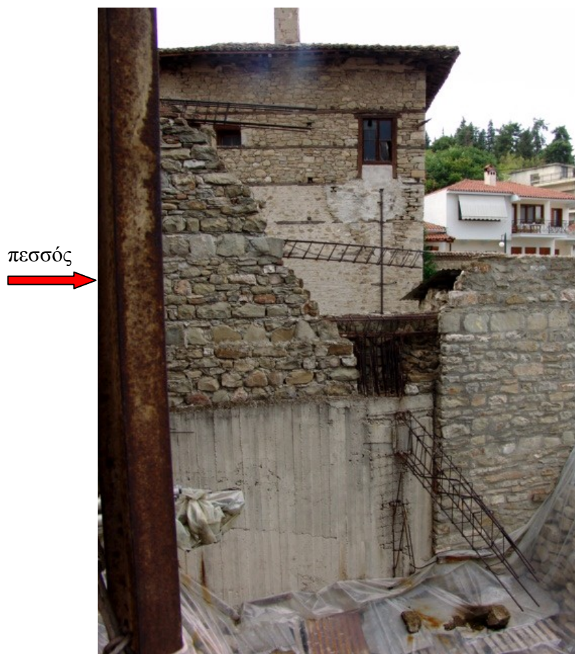
Φ43. Οπλισμένο σκυρόδεμα στο ισόγειο κάτω από τη στάθμη του αύλειου χώρου της κατοικίας Σιμή, λιθοδομή στον όροφο και στη συνέχεια στο μανδρότοιχο.
