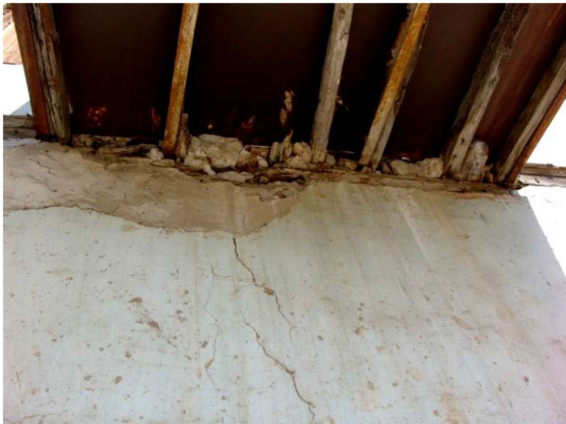
Φ86. Ρηγμάτωση τοιχοποιίας από αοπτοπλινθοδομή στο ισόγειο και αποδιοργάνωση εξώστη (επί της Τέλλου Άγρα).
