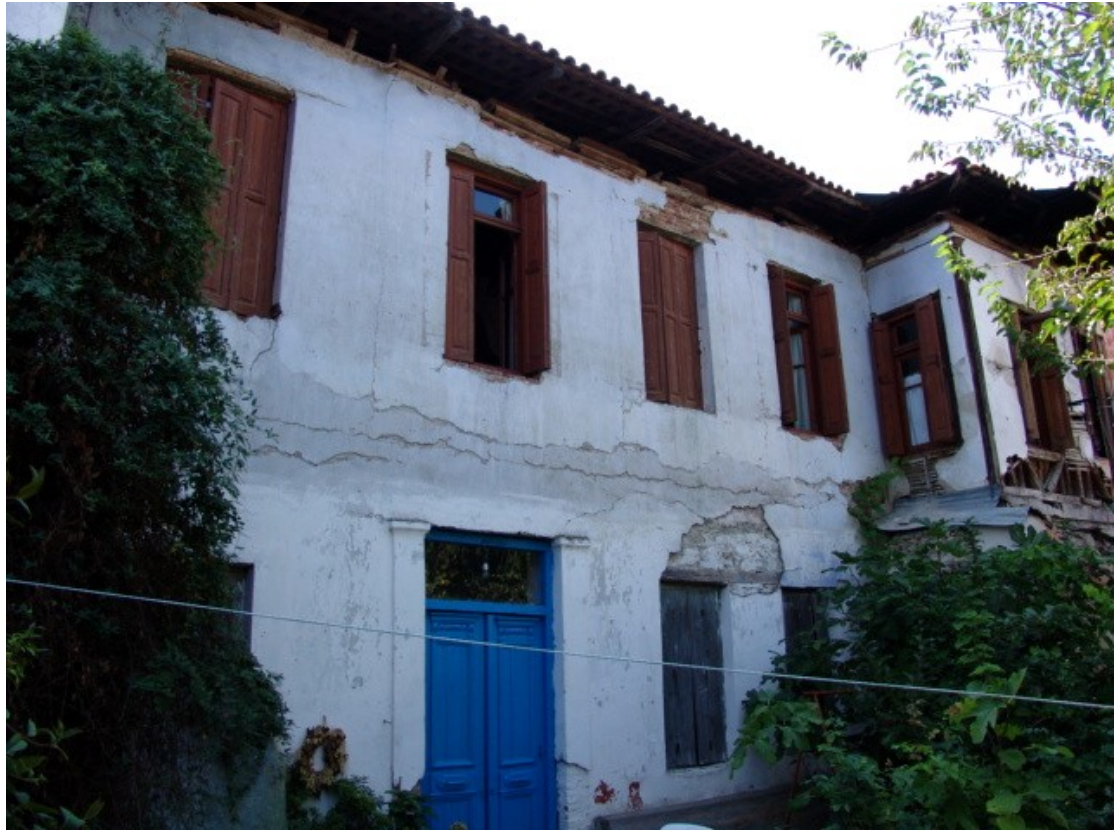
Φ66. Αποδιοργάνωση στο επίπεδο του δαπέδου ορόφου- ρηγματώσεις και στα δύο επίπεδα.
