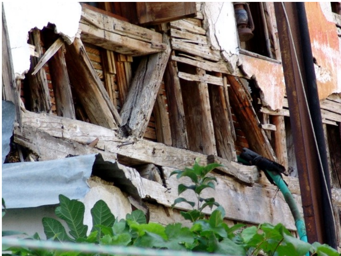
Φ48. Εύλινη κατασκευή στον όροφο.
