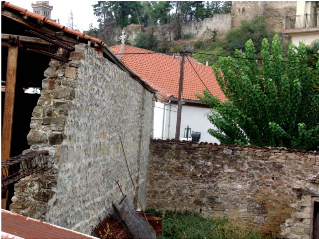
Φ15.Λεπτομέρεια της λιθοδομής στο όριο με την ιδιοκτησία Σιμή..
