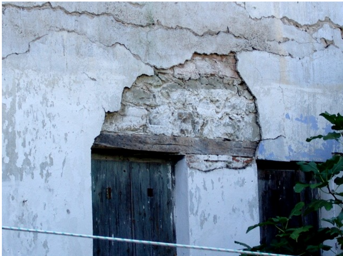
Φ50. Λιθοδομή, ξύλινο πρέκι στο ισόγειο.
