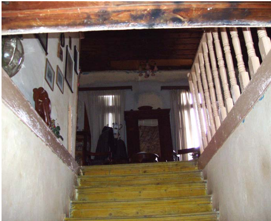
Φ22. Εσωτερική ξύλινη κλίμακα προς όροφο.
