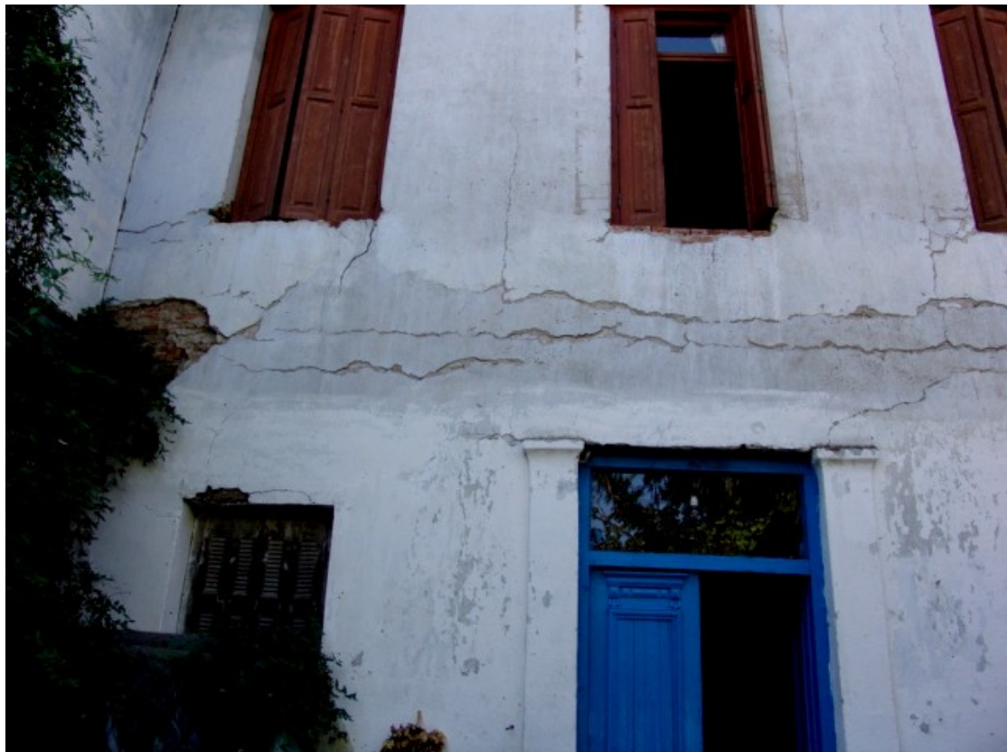
Φ73. Αποδιοργάνωση στο επίπεδο του δαπέδου ορόφου και στην αλλαγή κατεύθυνσης της τοιχοποιίας (οριζόντιες και κατακόρυφες ρηγματώσεις).
