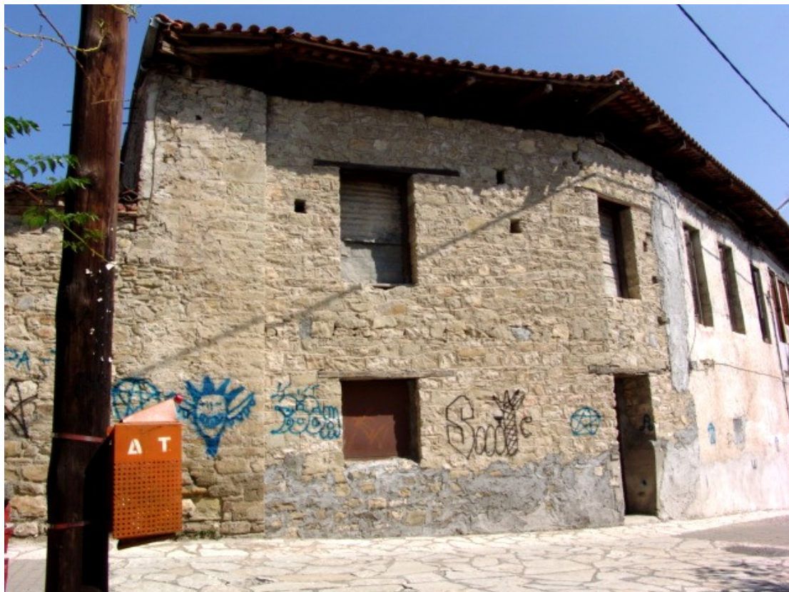
Φ87. Ρηγματώσεις, νεοανοιχθείσα προσωρινά πόρτα.
