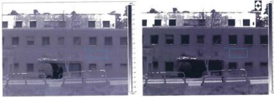
Εικόνα 5.40 Θερμογραφίες ενός κτηρίου που πάρθηκαν από απόσταση 30m . Πίστωση εικόνας : ITC
