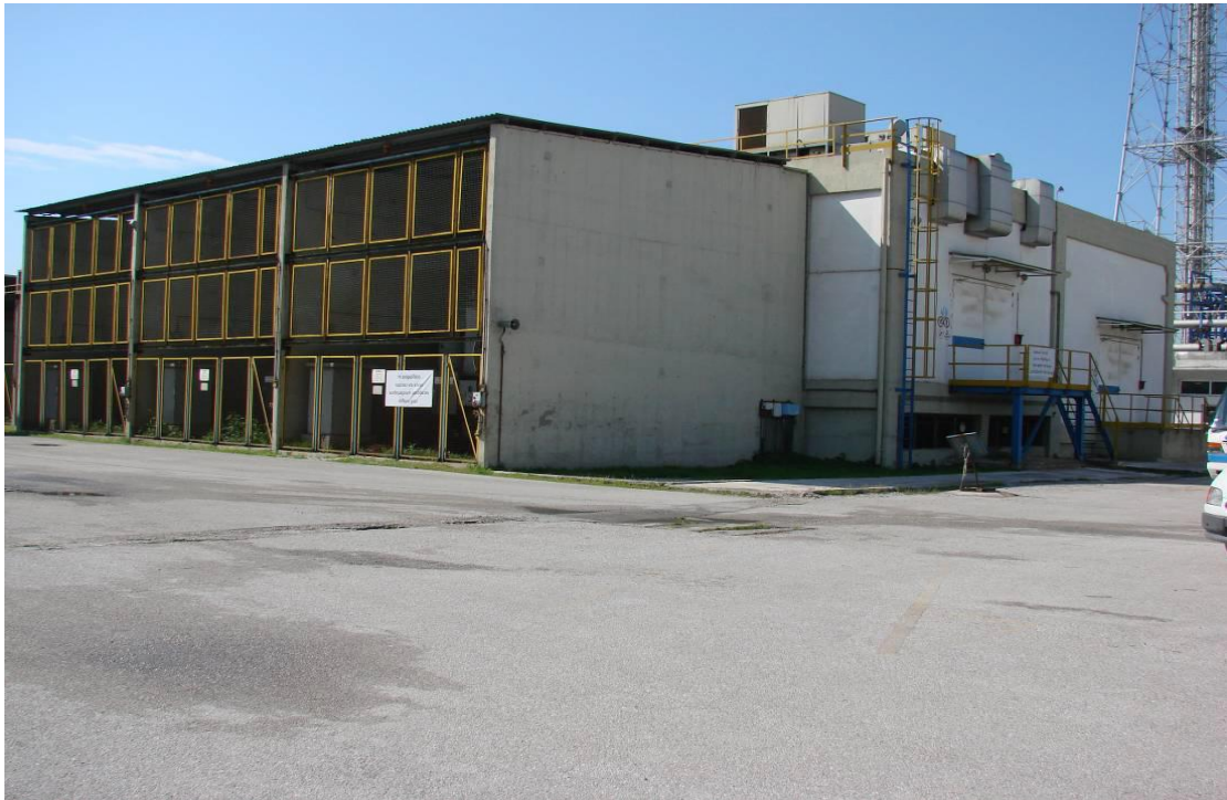
Εικόνα 6 Εξωτερική όψη Υποσταθμού R-7000
