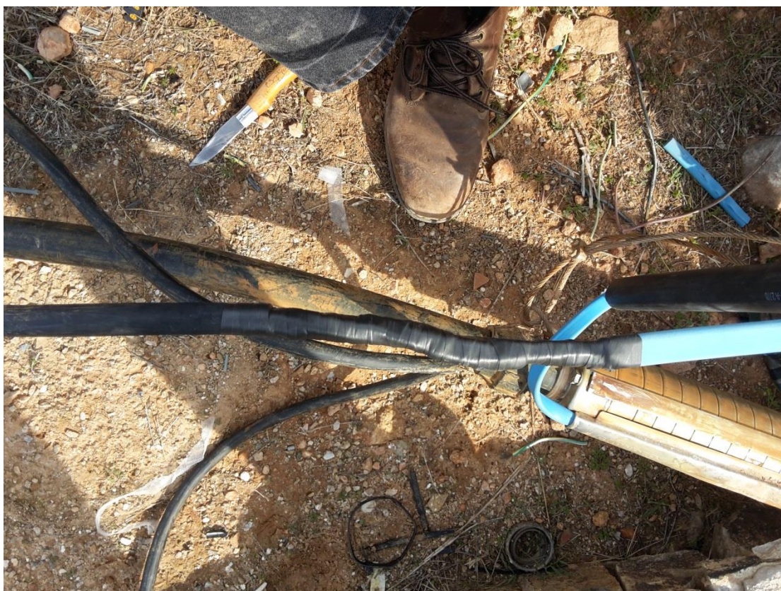
Σχήμα 9.7 : Το καλώδιο μονωμένο με μονωτική ταινία και λαστιχοταινία.
