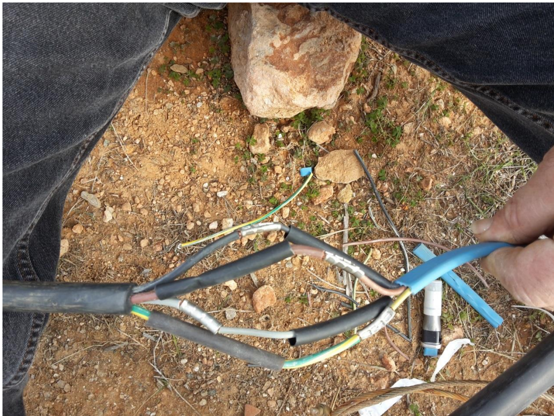
Σχήμα 9.6 : Συνδεδεμένοι αγωγοί με ακροδέκτες και θερμοσυστελόμενο.
