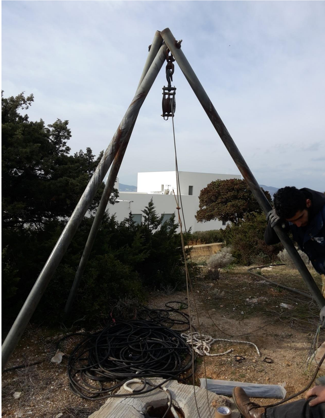
Σχήμα 10.7 : Κατακόρυφη εγκατάσταση της αντλίας.
