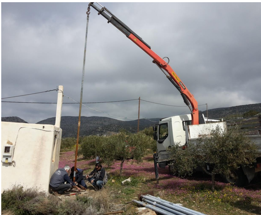
Σχήμα 10.8 : Ανύψωση μίας μονάδας αντλίας μεγάλου μεγέθους με γαλβανισμένους σωλήνες.
