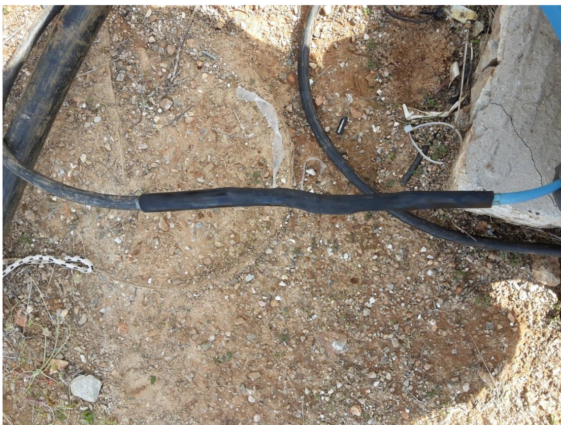
Σχήμα 9.8 : Τελική μόνωση με τη χρήση θερμοσυστελόμενου.
