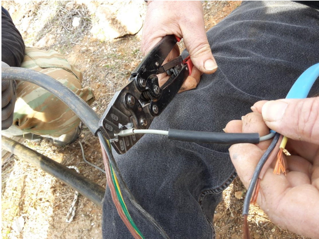
Σχήμα 9.5 : Σύνδεση καλωδίου παροχής με κινητήρα.
