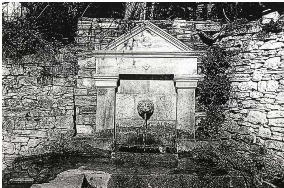
Φωτογραφία 4: Η νεοκλασική κρήνη στον Άγιο Γεώργιο Νηλείας με μαρμάρινη "γούβα" και λεοντοκεφαλή σα στόμιο εκροής του νερού. Κατασκευάστηκε το 1881 με αφορμή την ενσωμάτωση της Θεσσαλίας (φωτ. Αρχείο 5ης Εφορείας Νεωτέρων Μνημείων ΥΠ. ΠΟ.). ΠΗΓΗ : "ΚΑΘΗΜΕΡΙΝΗ" της Κυριακής, της 14ης Απριλίου 2002 Αφιέρωμα: ΚΡΗΝΕΣ: ΤΑ ΝΑΪΔΡΙΑ ΤΟΥ ΝΕΡΟΥ
