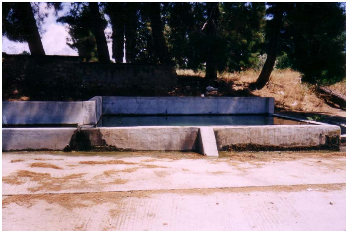
Φωτογραφία 19 : Ανατολική όψη της παλιάς βρύσης – η δεξαμενή της.
