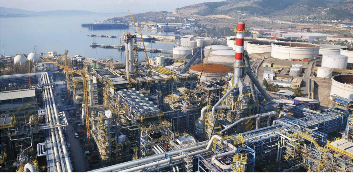
Εικόνα 3.3 Μονάδα Hydrocracking U34 [v]
