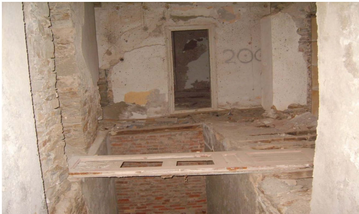
Εσωτερικό κτιρίου Φωτογραφία 6.20
