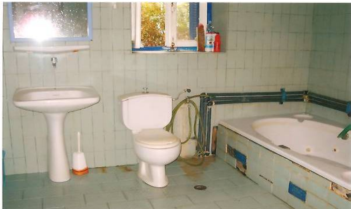
Χώρος του υδρομασάζ Φωτογραφία 6.9
